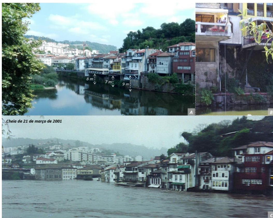
Figura 33 - (A) Alturas das varandas situadas na margem esquerda do rio Tâmega; (B) Medições efetuadas com recurso a um fio de prumo; (C) Aspeto das mesmas varandas durante a cheia de 21 de março de 2001.
