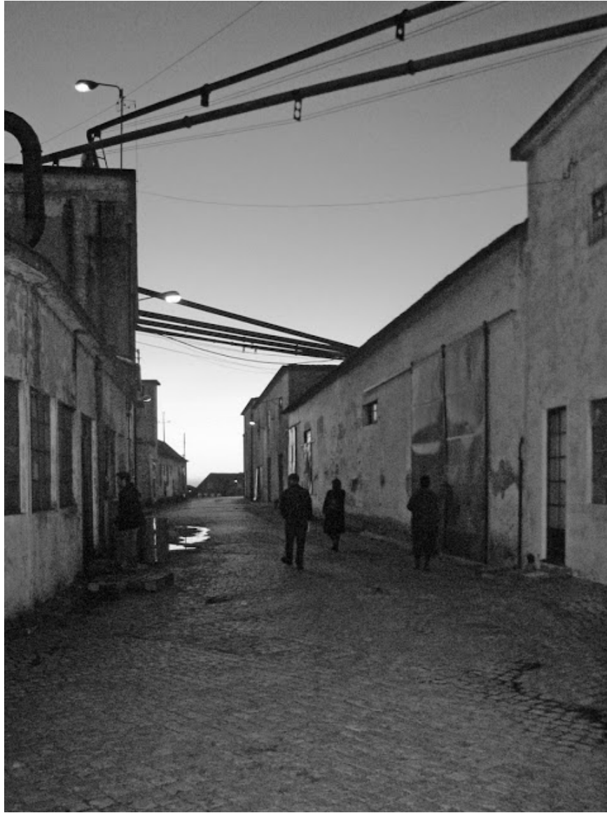
23| Vista do interior do complexo da fábrica Robinson, antes da requalificação.
