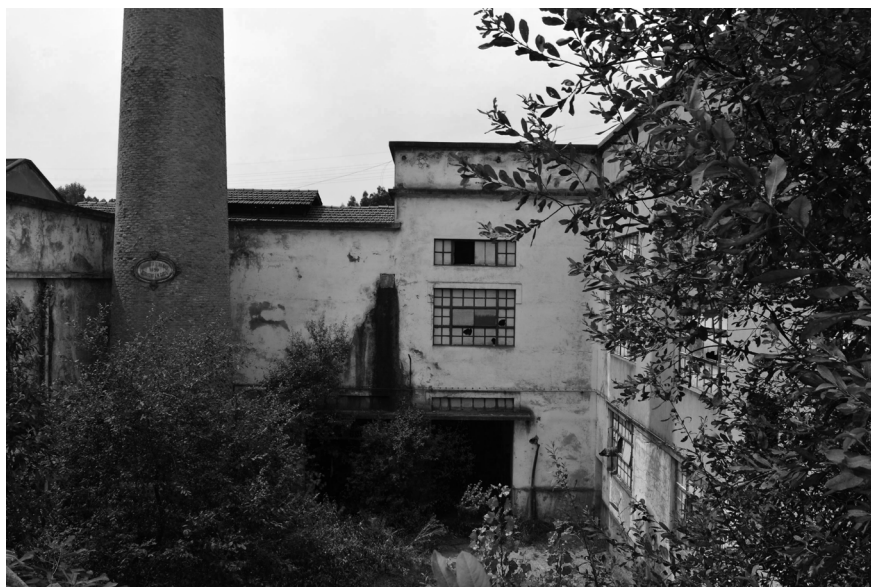
20| Estado actual da fábrica Sampaio Ferreira. Chaminé de tijolo.
