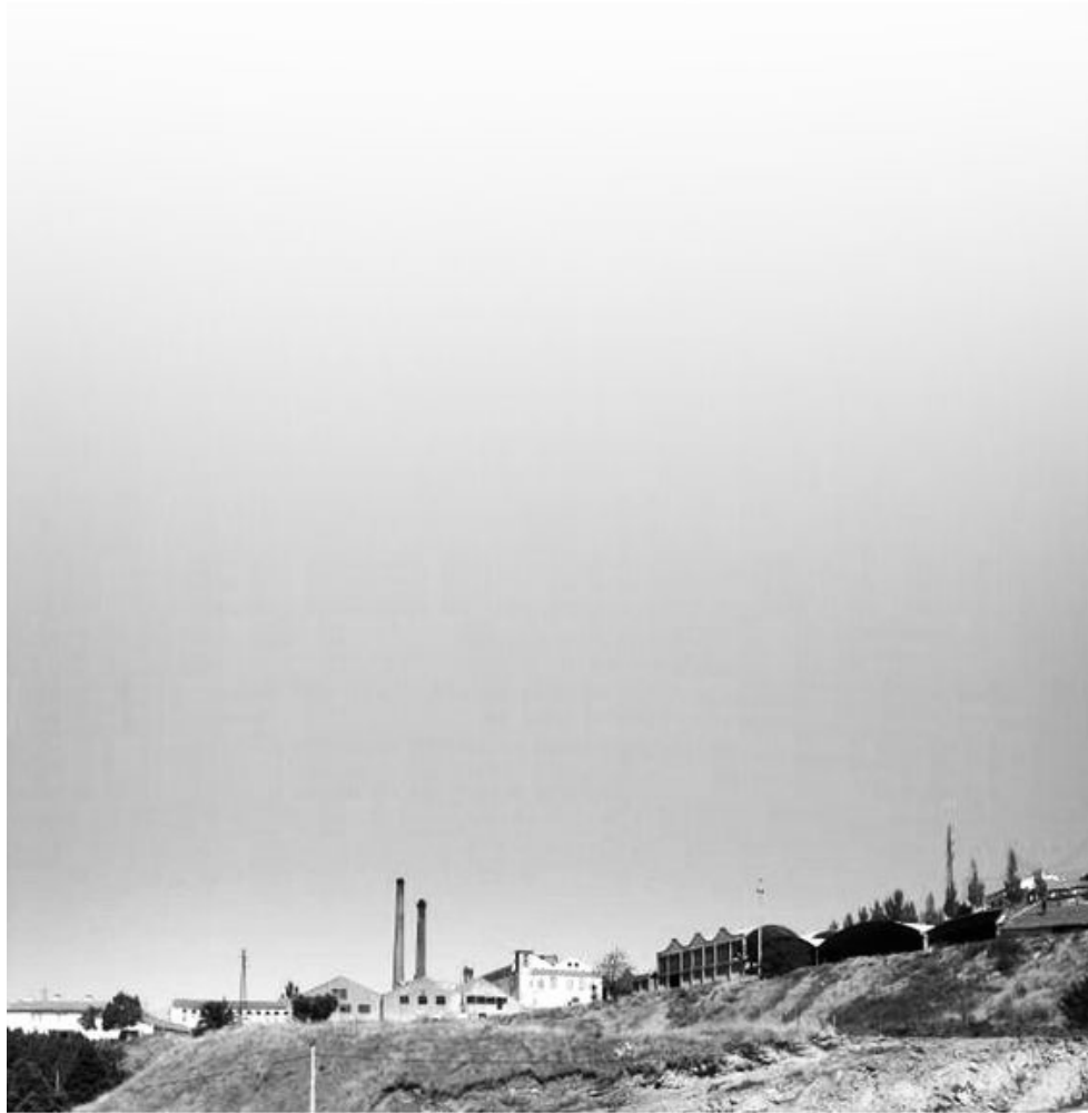
21| Vista Nascente do complexo da fábrica Robinson, antes da requalificação.
