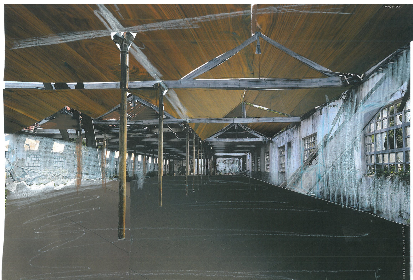
62| Colagem sob fotografia, espaço a reabilitar em Sala de Documentação.
