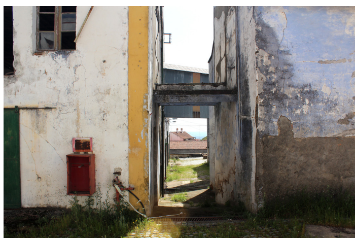
27| Vista actual, Espaço Robinson (4). Cores originais pré-existente.
