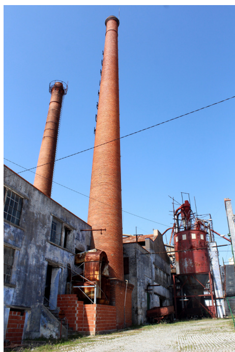
35| Vista exterior, edifício principal da Fábrica (1)
