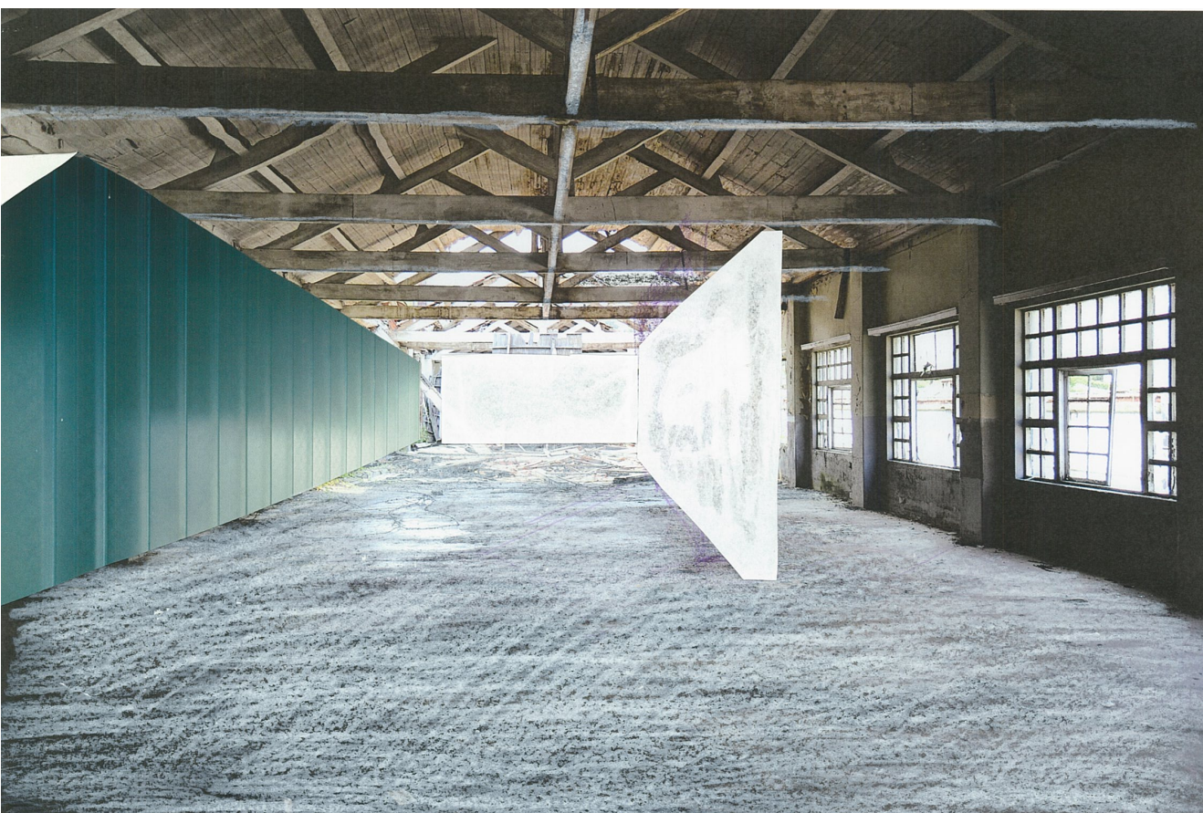
53| Desenho sob fotografia, espaço a reabilitar em Edifício Polivalente.
