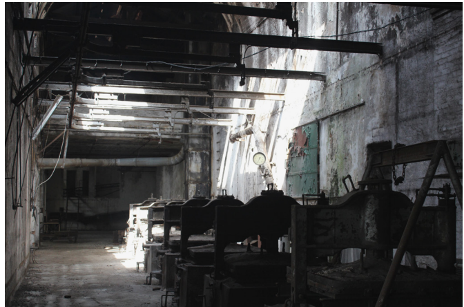
30| Vista interior do Volume 1. Maquinaria Fixa (prensas).
