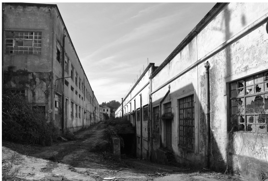
18| Estado actual da fábrica Sampaio Ferreira. Rua interior, à esquerda edifício 5, à direita edifício 4.
