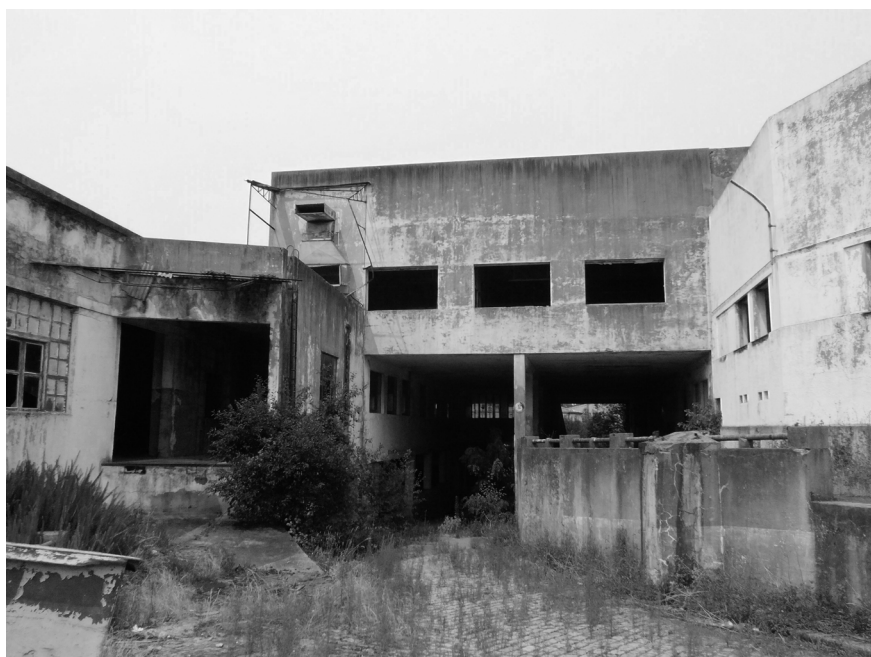
19| Estado actual da fábrica Sampaio Ferreira. Edifícios de administração, área 6.
