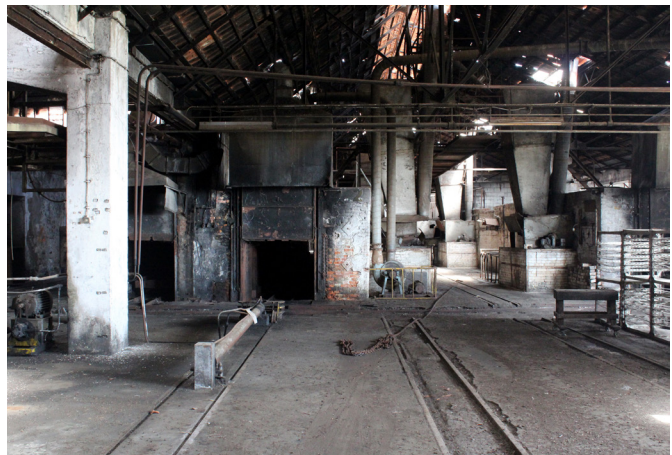
31| Vista interior do Volume 11. Zona de fornos.
