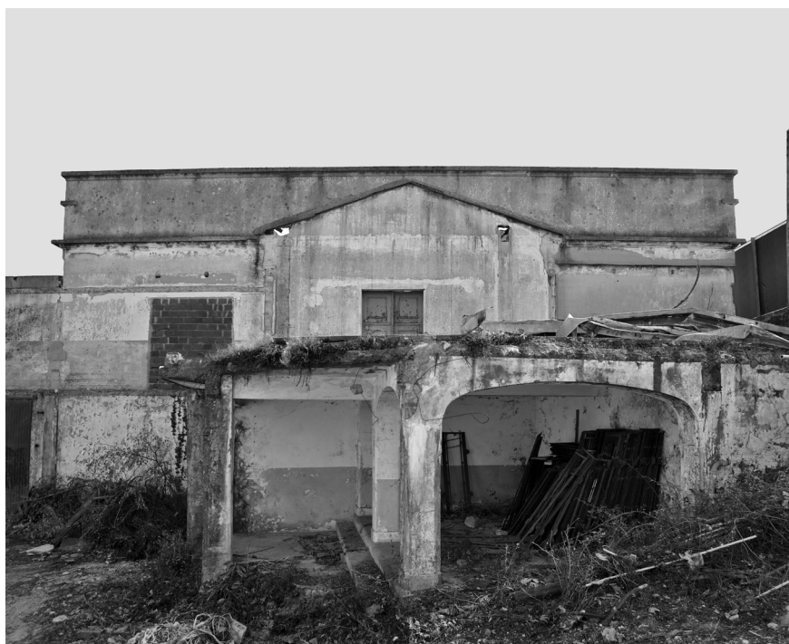
17| Estado actual da fábrica Sampaio Ferreira. Edifício 1.
