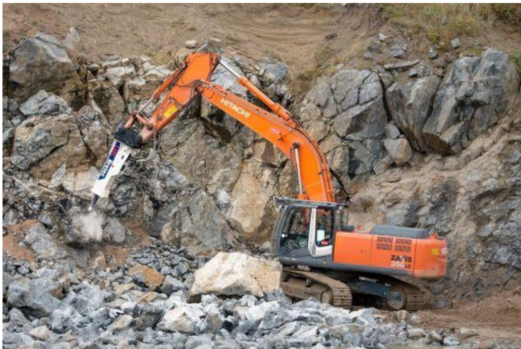
Figura 29- Imagem ilustrativa do taqueio de blocos de grandes dimensões após a realização do desmonte com recurso a explosivos.
