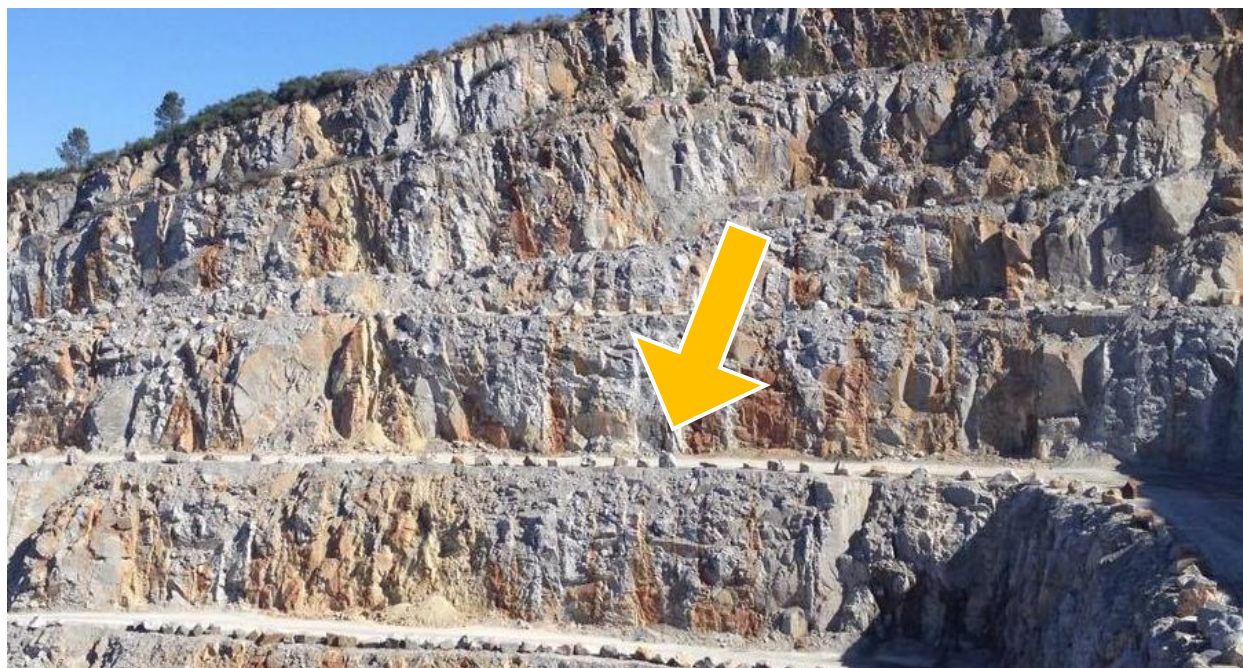
Figura 70 – Colocação de blocos de grande dimensão.
