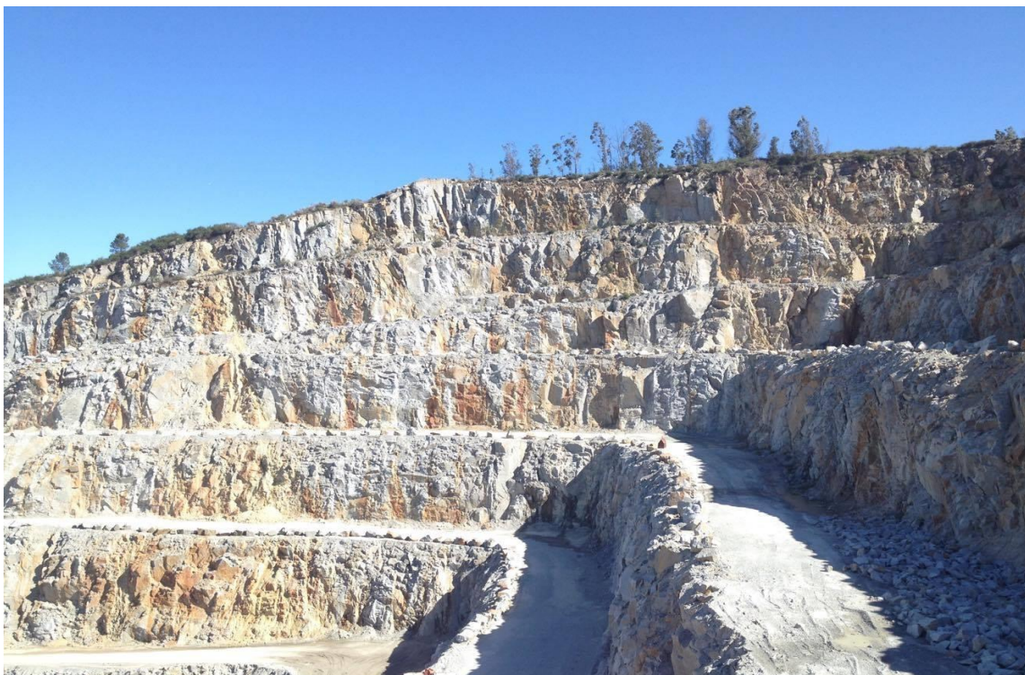
Figura 50 – Estado das frentes de desmonte.
