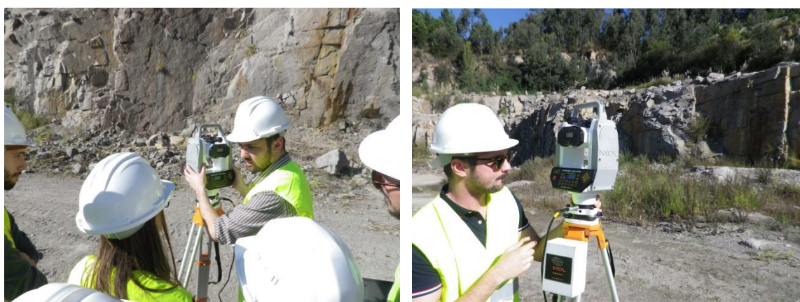
Figura 78 – Equipamento leitura laser .
