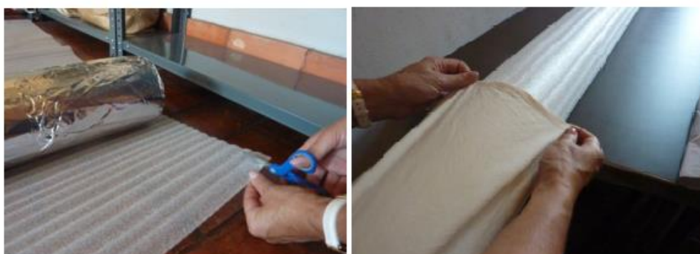
Fig. 23 - Isolamento do tubo de PVC. @Sofia Barbosa
