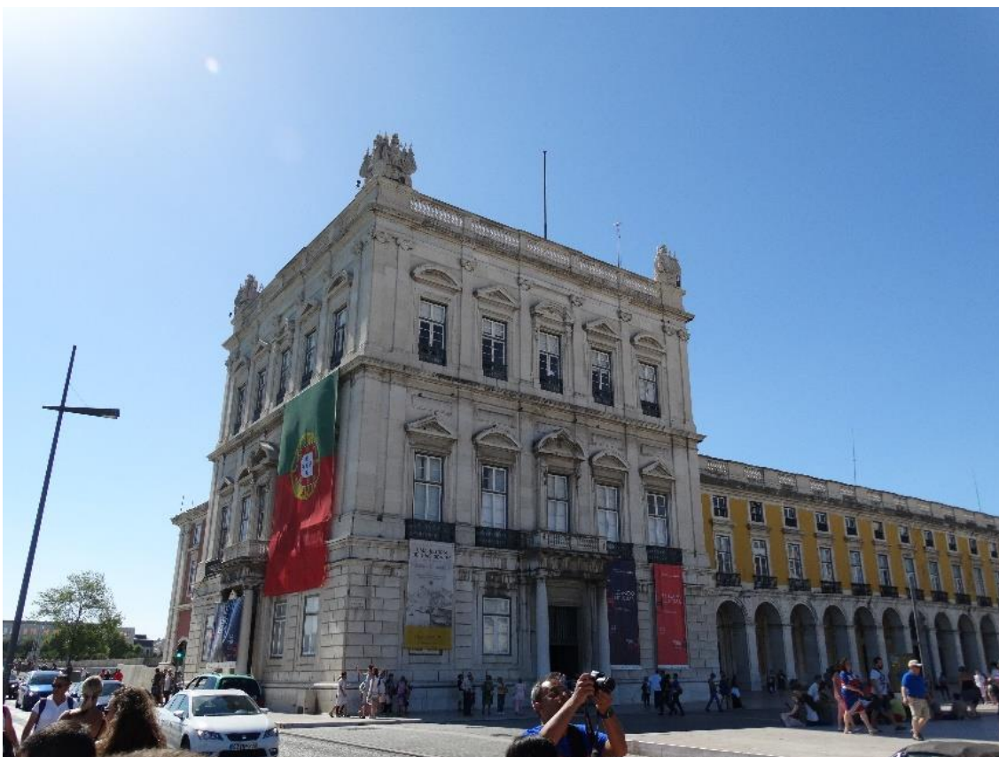
Fotografia 2 – Torreão Praça do Comércio
