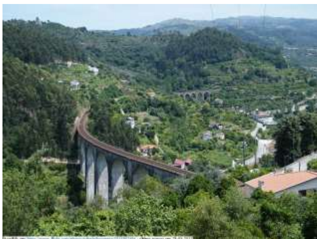
Figura 7 - Viaduto da pala e do Ovil
