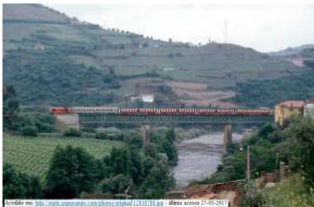
Figura 14 - Viaduto do Corgo
