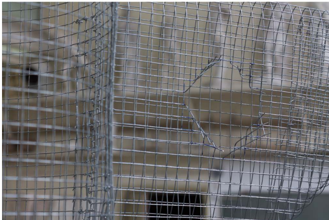
Imagens da construção da estrutura de arame
