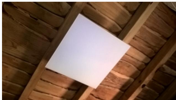
Figura 12. Exemplo de um elemento de aquecimento Vitramo.
