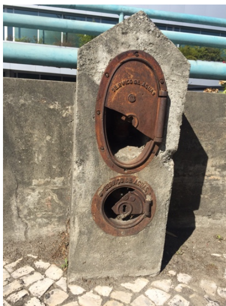
Figura 11 – Hidrante exterior
