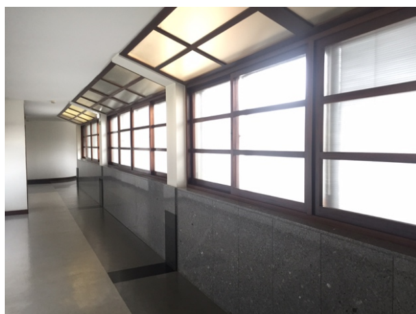
Figura 14 – Compartimentação existente entre o Setor Administrativo e a Área Produtiva
