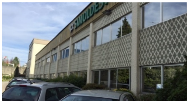
Figura 7 – Fachada Poente - Acesso ao Setor administrativo e Departamento Técnico
