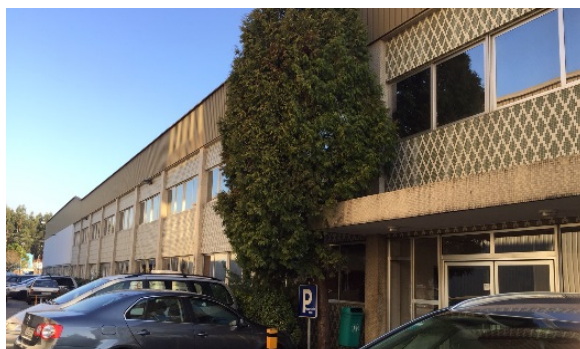
Figura 9 – Fachada Norte – Acesso aos Gabinetes de apoio à Produção e Setor Administrativo
