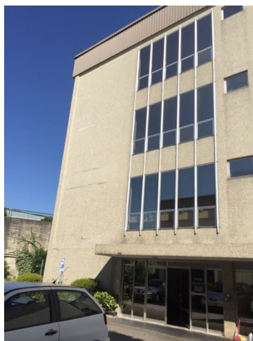
Figura 10 – Fachada de acesso ao Edifício Social
