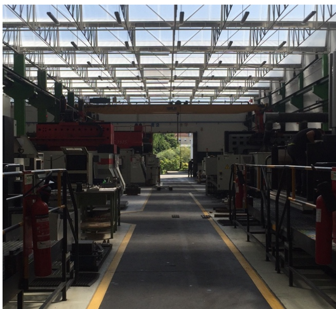
Figura 16 – Portão da Nave 1 da Área Produtiva
