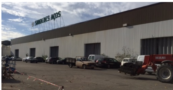
Figura 8 – Fachada Nascente - Acesso à Área Produtiva
