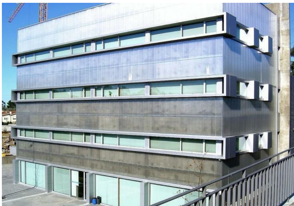
Fig. 2.20 – Fachada revestida em policarbonato transparente [34]
