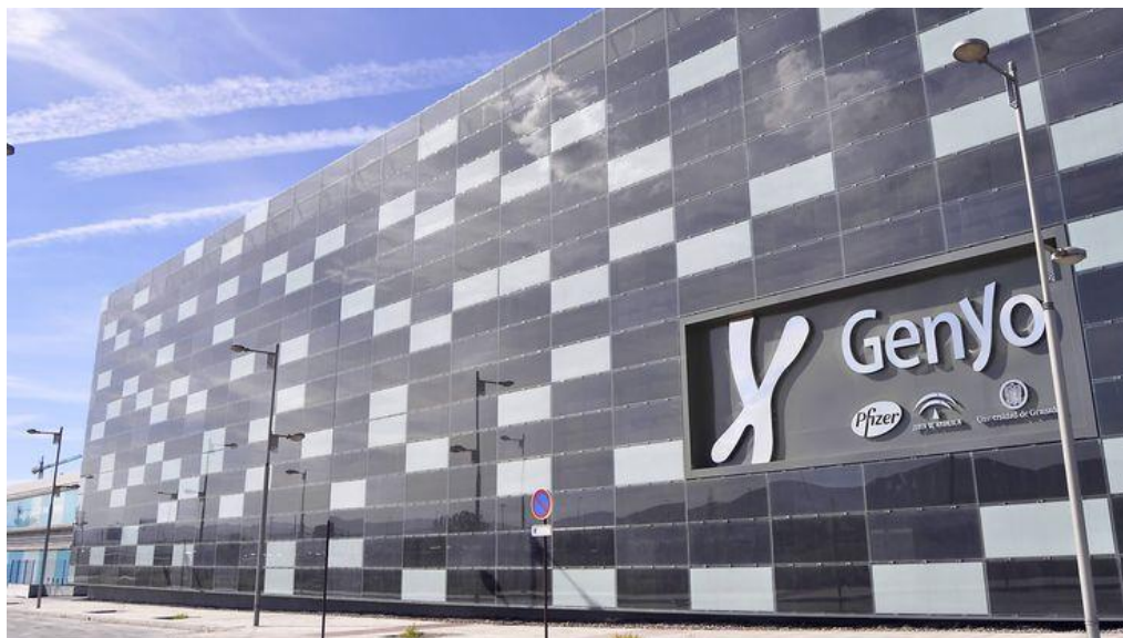
Fig. 2.21 – Fachada revestida com painéis fotovoltaicos [36]
