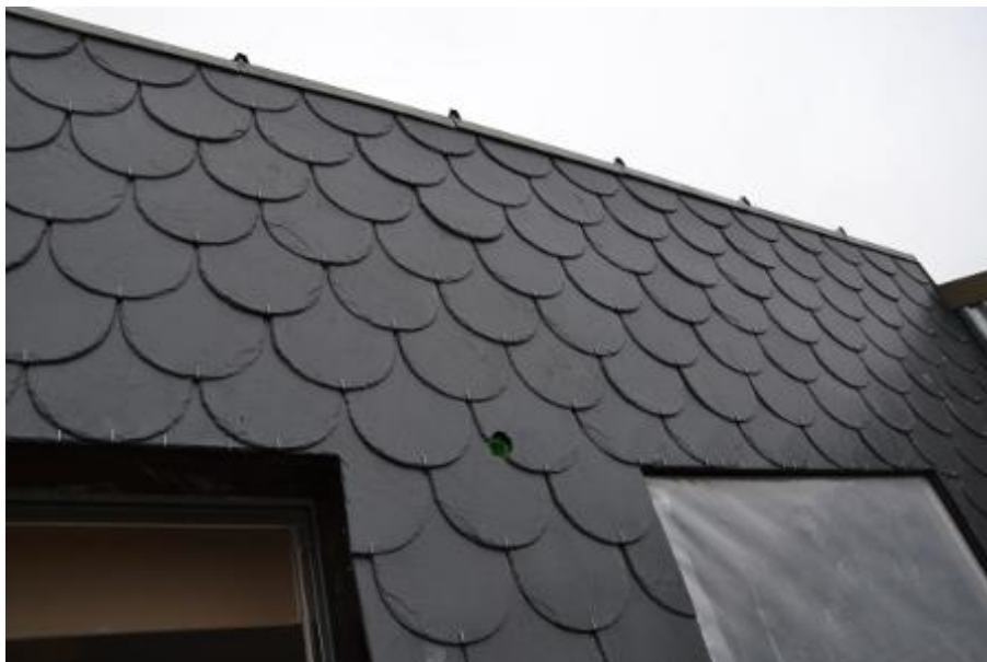
Fig. 2.7 – Fachada em soletos de ardósia [11]
