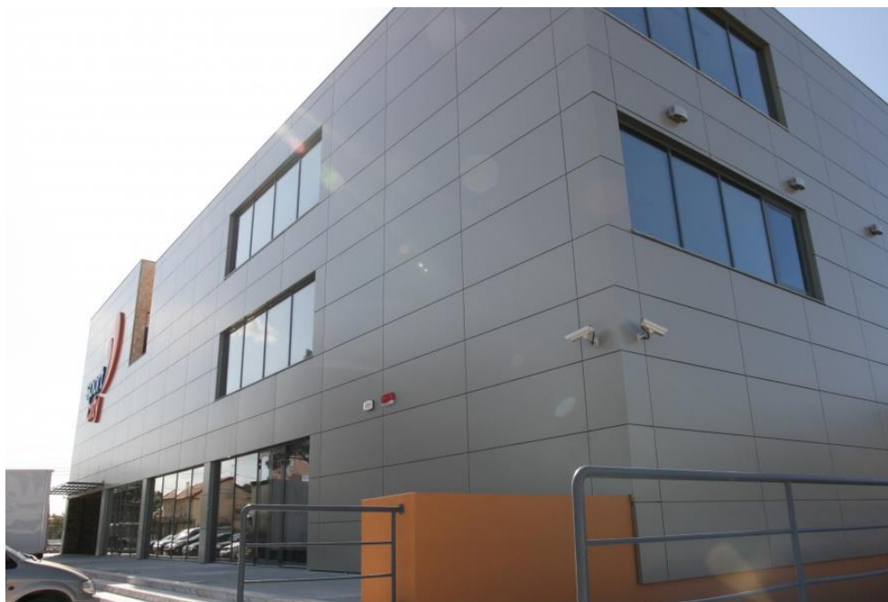
Fig. 2.10 – Fachada ventilada revestida a compósito de alumínio [18]
