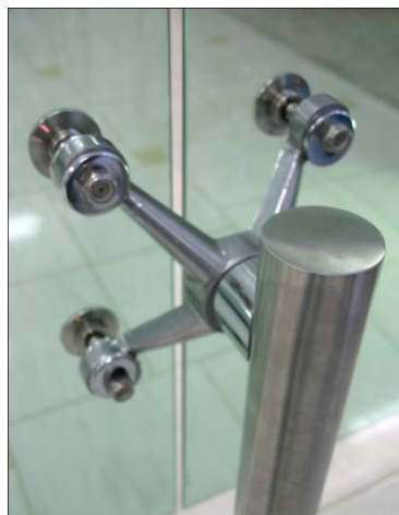
Fig. 2.28 – Ancoragem no tardo por sistema de aperto [40]
