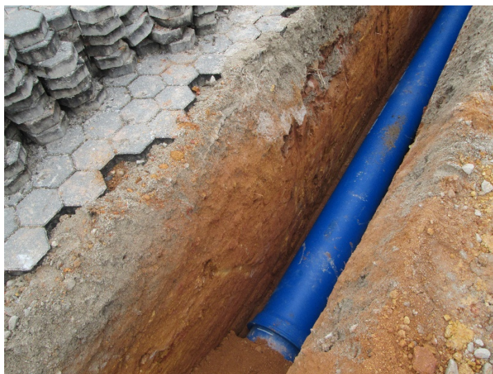
Fig.4.5. - Substituição de conduta na Águas de Gaia, EM, SA (24 de março de 2017)
