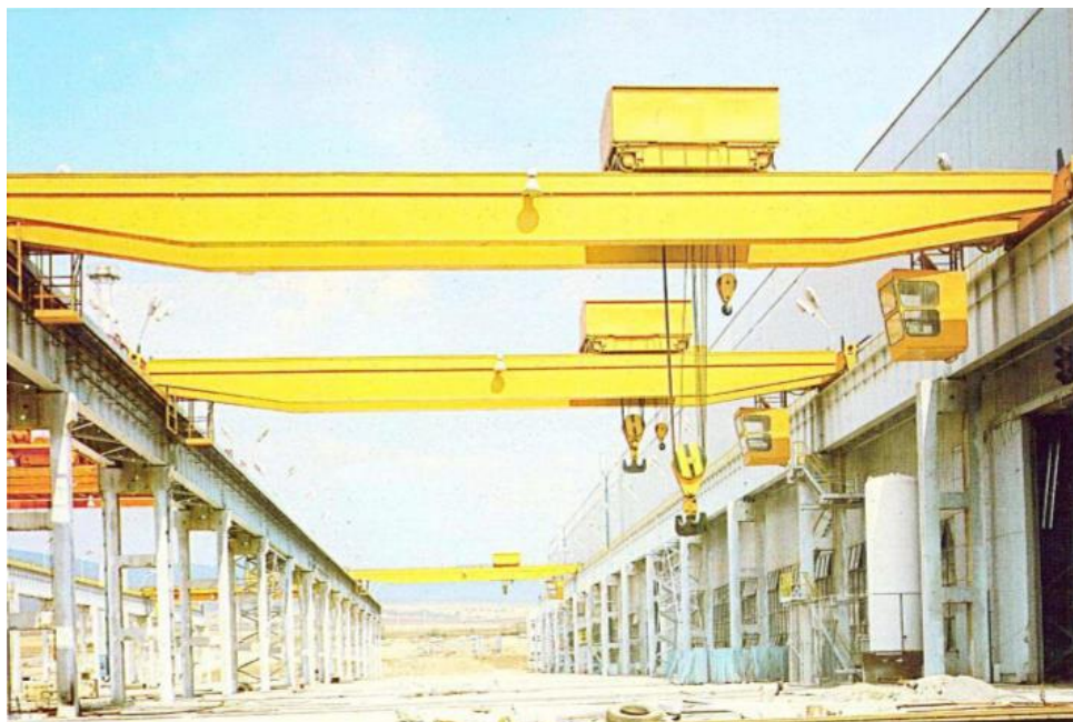
Fig.2.6- Guindaste elétrico dupla viga[6].
