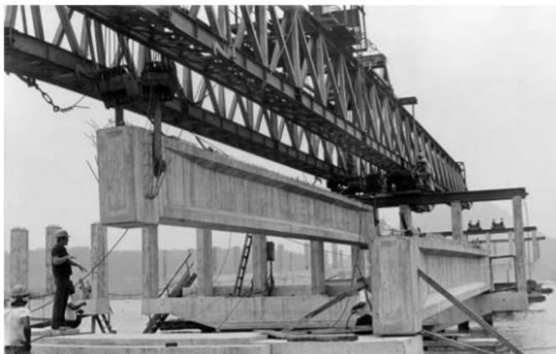
Fig. 2.2- Ponte rolante com estrutura em treliça[3].
