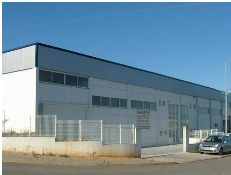
Fig. 2.3 - Zona industrial Lagoa
