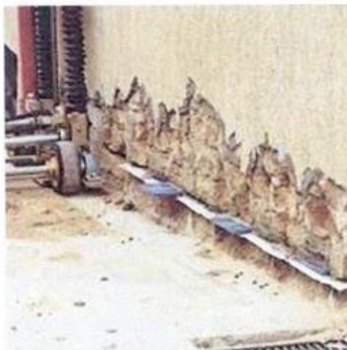
Fig. 2.2 – Corte hídrico com recurso a barreiras físicas [5]
