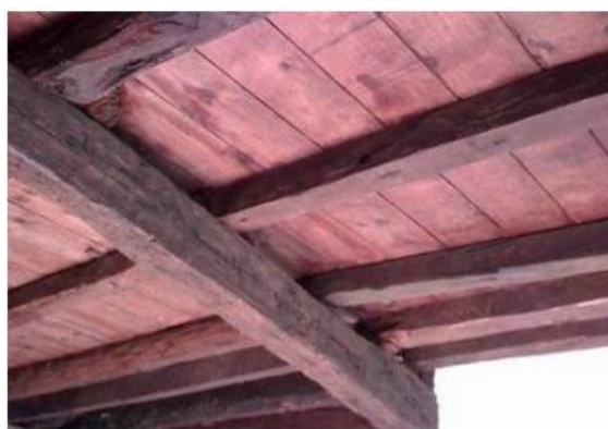
Fig. 31 – viga de reforço a dividir o vão das existentes (Dias, 2008)
