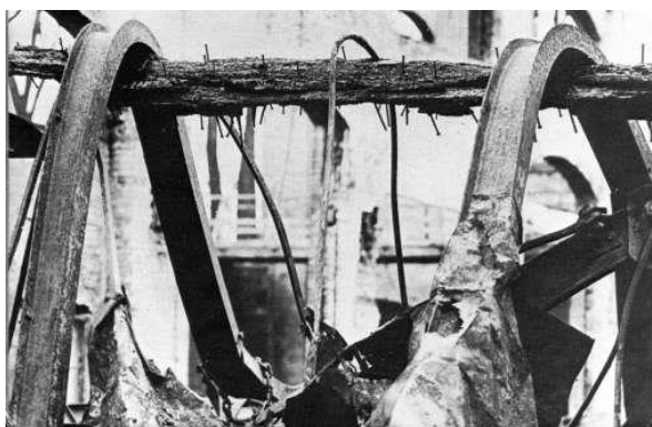
Fig. 18 – Comparação do efeito do fogo em estrutura de madeira e metálica, retirado de (Costa, 2009)
