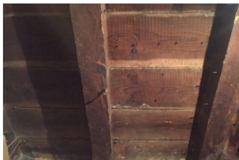
Fig. 13 – Vigamento de pavimento de habitação do século XIX, Leiria
