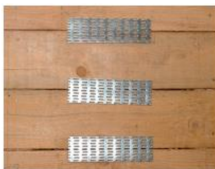
Fig. 56 – Tábuas do soalho de madeira conectadas com as placas de metal perfurado (Gattesco et al. , 2008)
