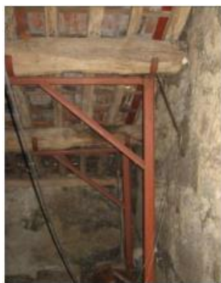
Fig. 25 – Exemplo de cachorro metálico, retirado de (Dias, 2008), por sua vez retirado de (Costa et al. , 2008a)
