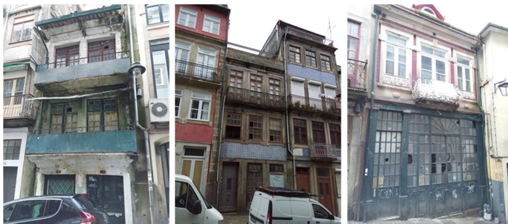
Fig. 4.7 – Fotos exemplo de edifícios da zona em análise, considerados pelo autor como estado de conservação “DEVOLUTO”.
