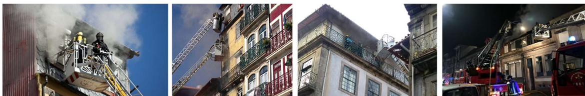
Fig. 2.1 – Imagens de alguns incêndios no CHP, [17], [18], [19], [20].
