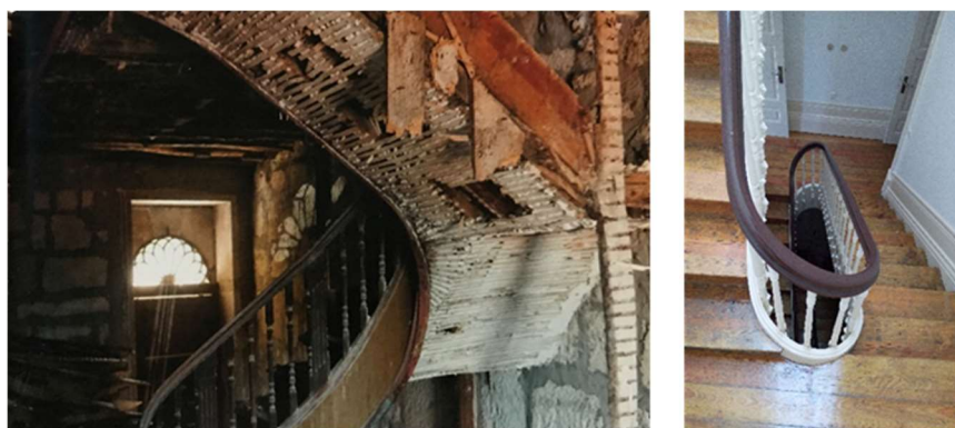
Fig. 3.9 - Exemplos de escadas de madeira de edifícios do CHP.
