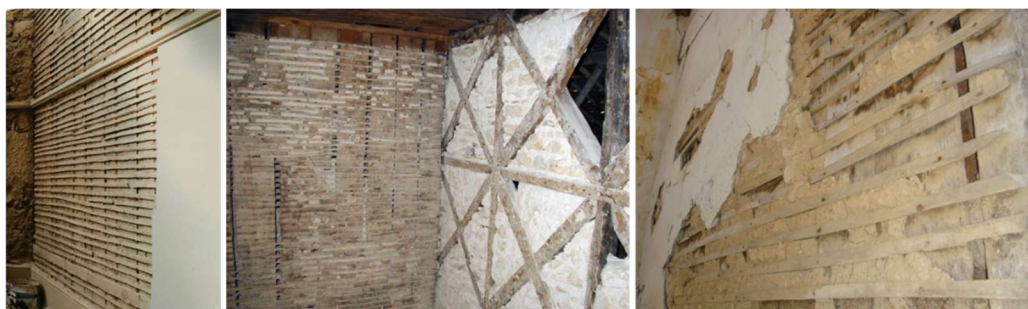
Fig. 3.8 - Exemplo de paredes interiores em Tabique
