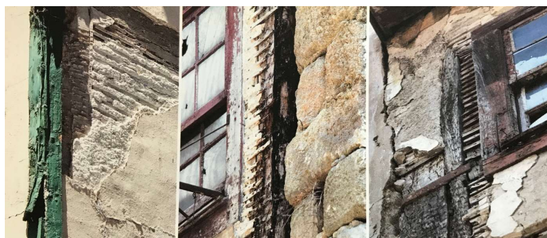
Fig. 3.6 - Exemplos de paredes exteriores de tabique [15]
