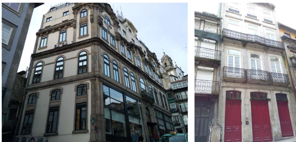
Fig. 4.4 – Fotos exemplo de edifícios da zona em análise, considerados pelo autor como estado de conservação “BOM”.
