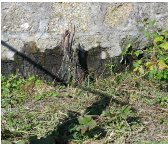
Fotografias 9 e 10 – Escorrências de águas sujas no muro oeste da Quinta.
