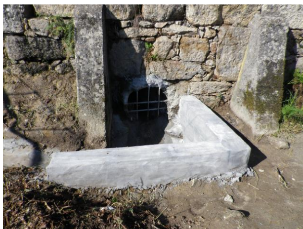
Fotografia 6 – Entrada de águas pluviais nos terrenos da Quinta, em direcção ao colector construído pela Câmara Municipal de Paredes
