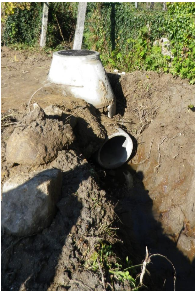
Fotografias 8 e 9 – Ponto de descarga provisório de águas pluviais e canal paralelo ao muro norte da Quinta para circulação destas águas.
