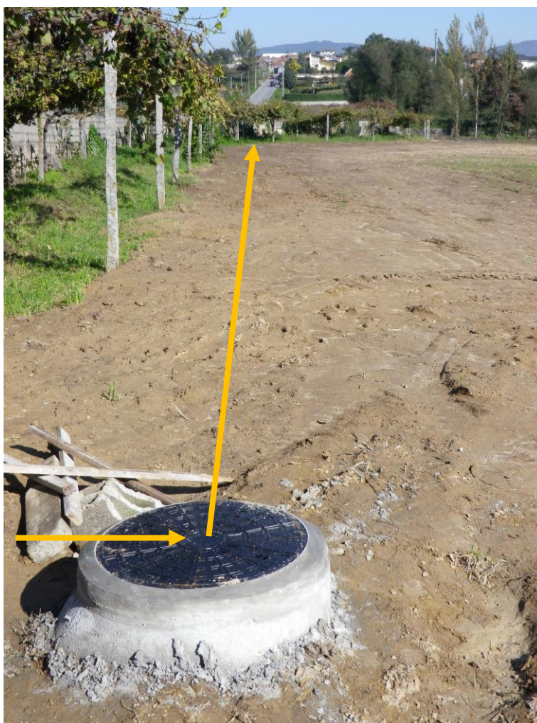
Fotografia 7 – Caixa de visita do colector de águas pluviais construído pela Câmara Municipal de Paredes. Assinala-se com setas o traçado do colector enterrado.
