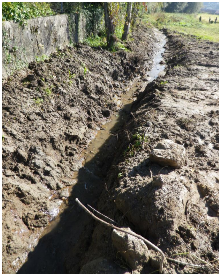
Fotografias 8 e 9 – Ponto de descarga provisório de águas pluviais e canal paralelo ao muro norte da Quinta para circulação destas águas.
