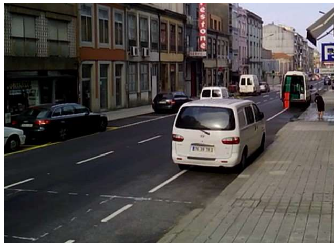
Figura 15 – Marcação de vias (Retirado de vídeo recolhido) Este espaço destinado à circulação de velocípedes possibilitava um uso abusivo desse local para estacionamento ilegal, paragem de veículos
