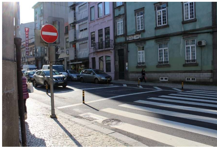
Figura 16 – Linha de paragem após intervenção (Foto própria)
