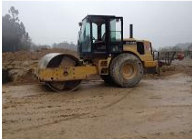
Figura 4.19 - Compactação do aterro
