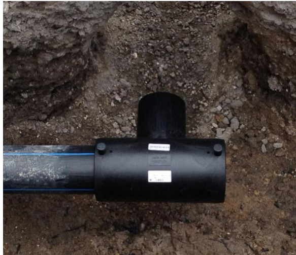
Figura 4.34 - Junta cega
