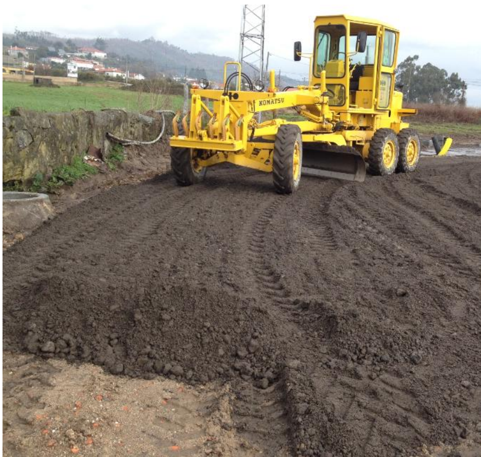
Figura 4.61 - Execução da camada sub-base com espalhamento do agregado de granulometria extensa com recurso a uma motoniveladora
