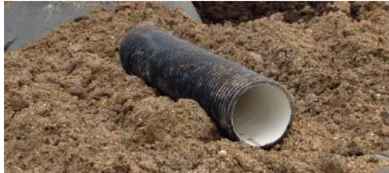
Figura 4.23 - Tubagem em PP corrugado SN8
