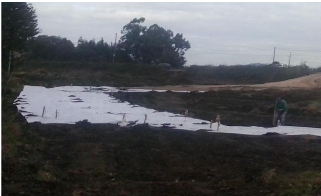
Figura 4.11 - Colocação do geotêxtil na zona viária
