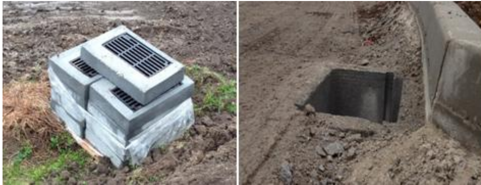
Figura 4.26 - Sarjetas em betão armado
