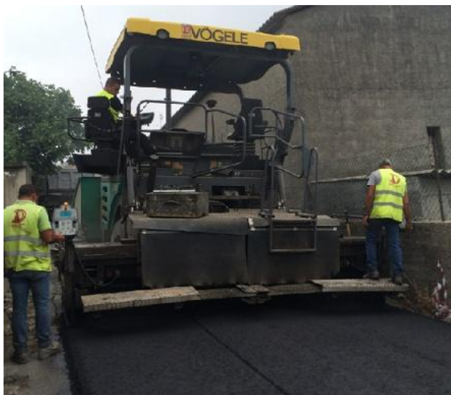
Figura 4.65 - Espalhamento da mistura
