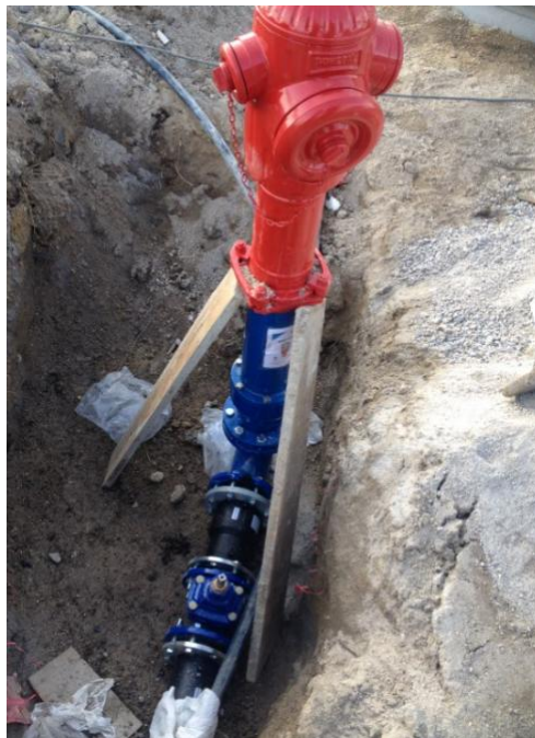
Figura 4.33 - Marco de Incêndio
