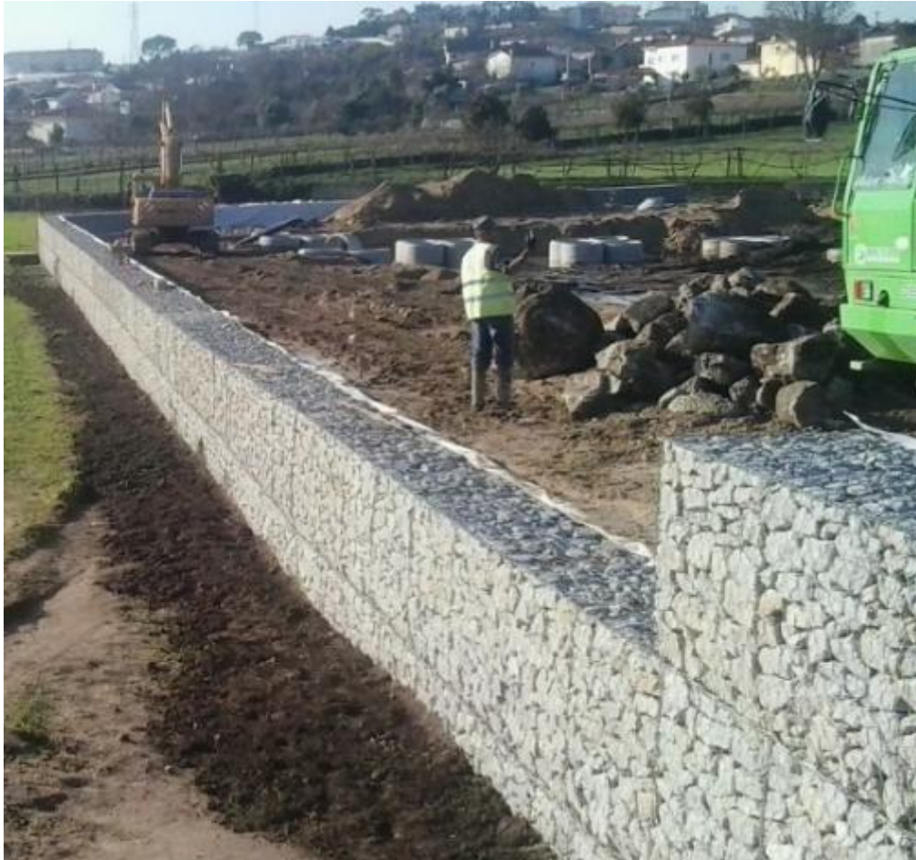
Figura 4.15 - Construção do muro de gabiões
