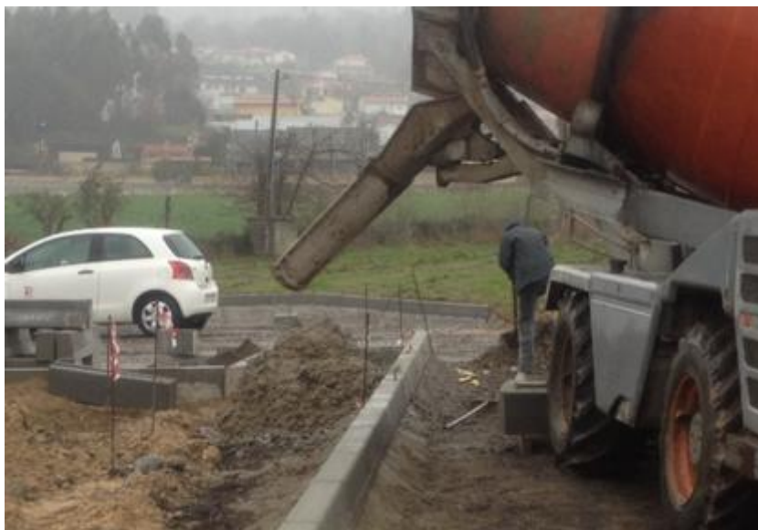
Figura 4.53 - Colocação do betão para assentamento dos lancis
