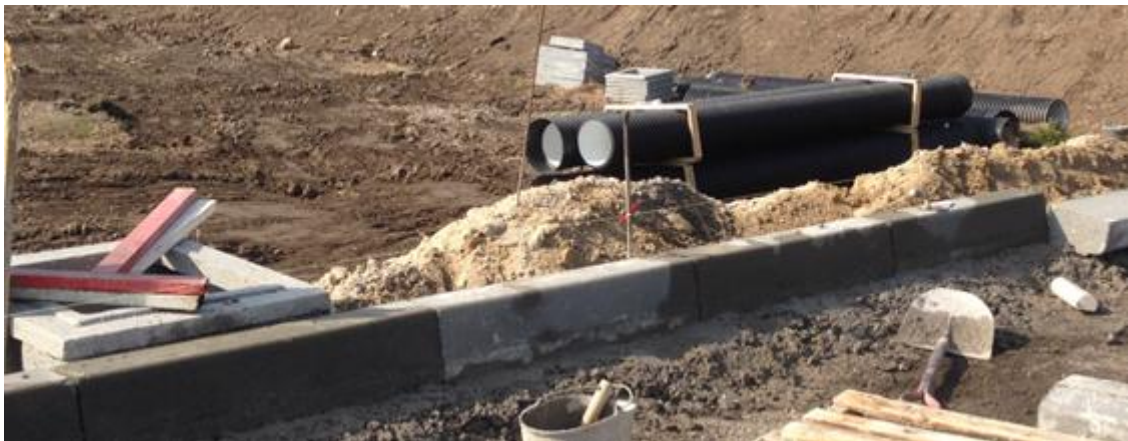
Figura 4.52 - Assentamento dos lancis
