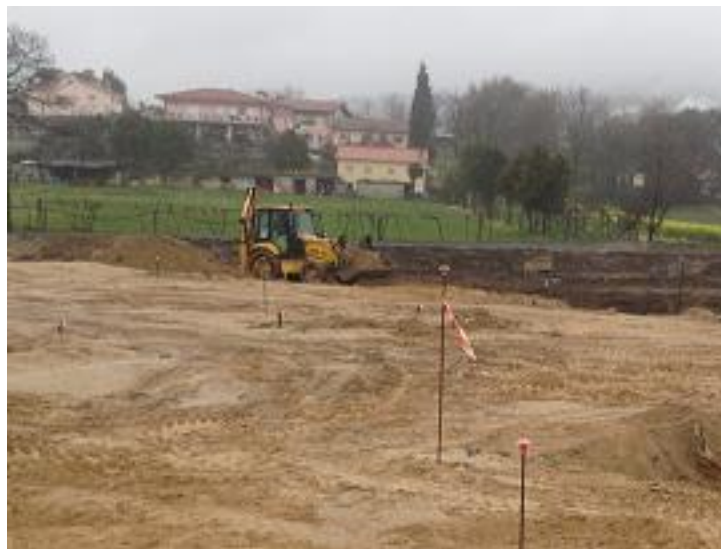
Figura 4.18 - Espalhamento do aterro
