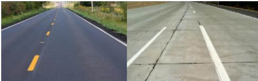
Figura 4.55 - Pavimento flexível e pavimento rígido
