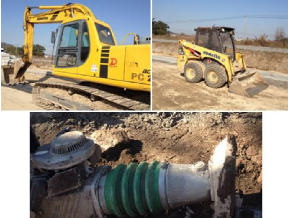
Figura 4.28 - Equipamentos utilizados para execução dos trabalhos
