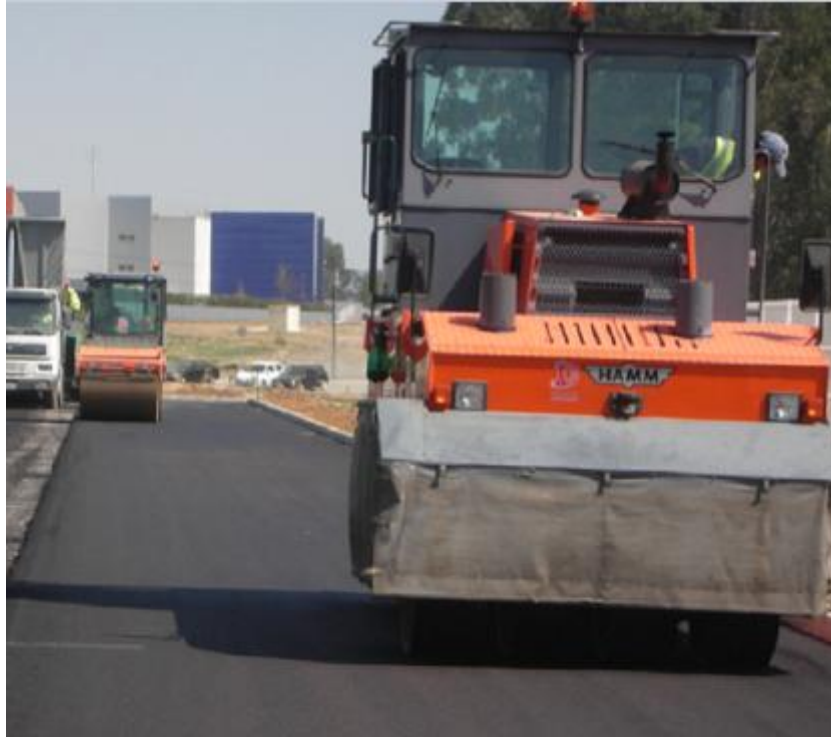
Figura 4.66 - Compactação da mistura betuminosa
