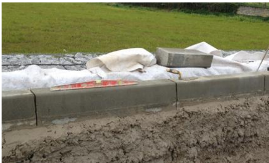
Figura 4.54 - Nivelamento dos lancis
