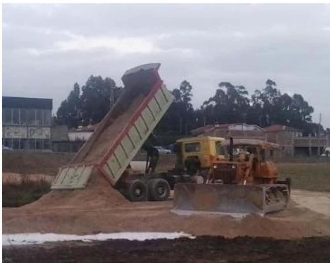
Figura 4.12 - Primeiro aterro sobre o geotêxtil
