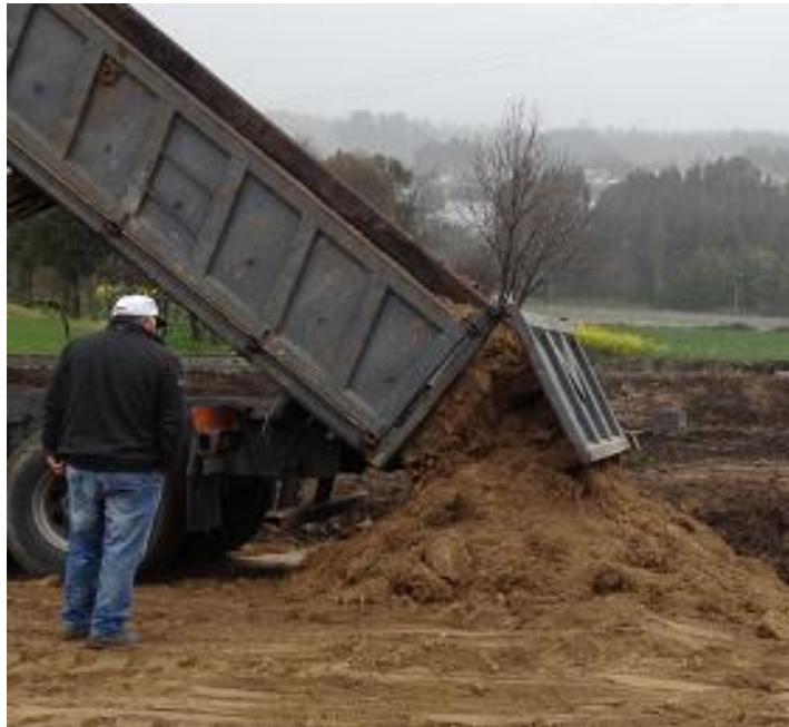
Figura 4.17 - Descarga de saibro para aterro
