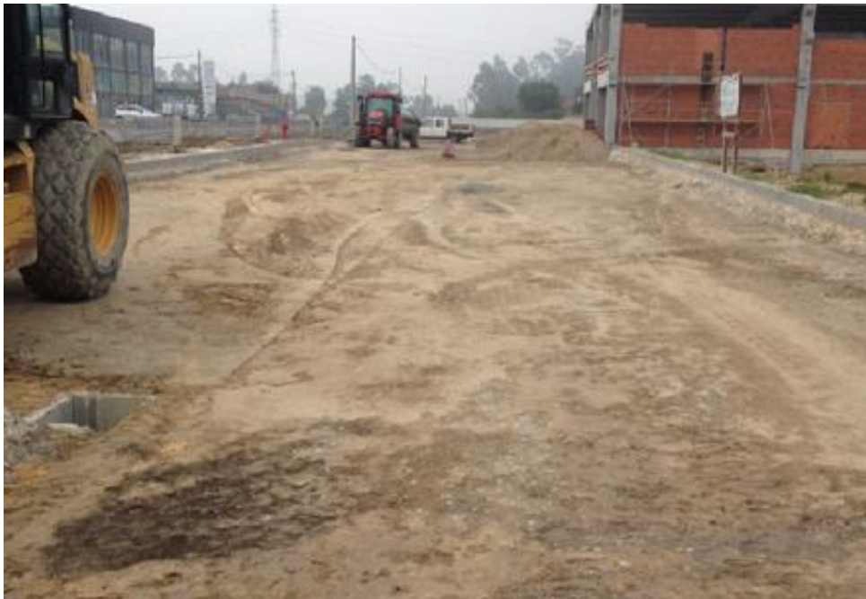
Figura 4.60 - Preparação para a colocação da sub-base
