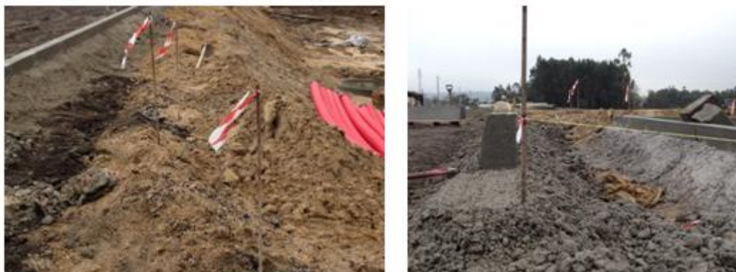
Figura 4.50 - Pormenor da implantação e nivelamento dos pontos para a colocação em obra
