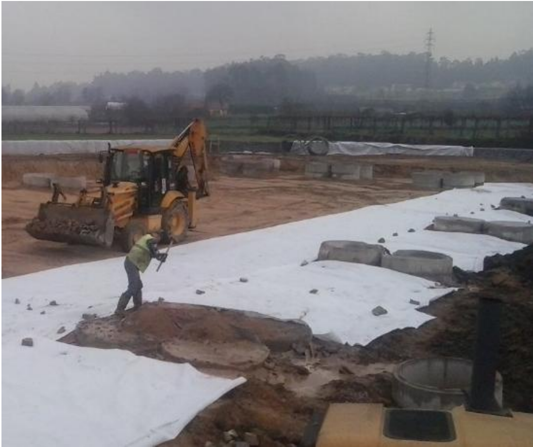
Figura 4.13 - Colocação do geotêxtil na zona do edifício
