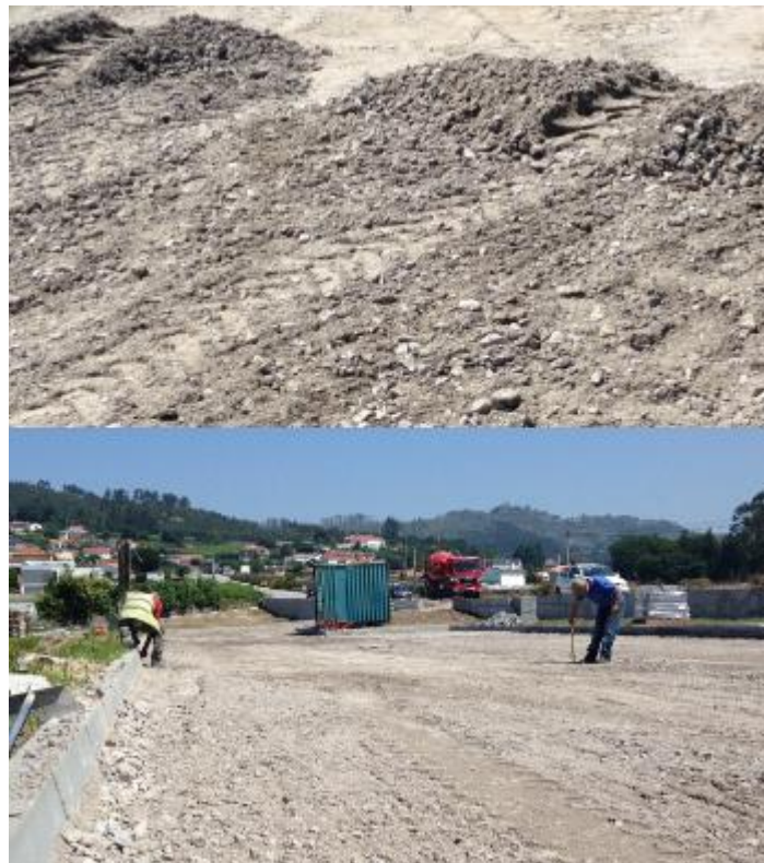
Figura 4.62 - AGE usado na camada base e verificação das cotas
