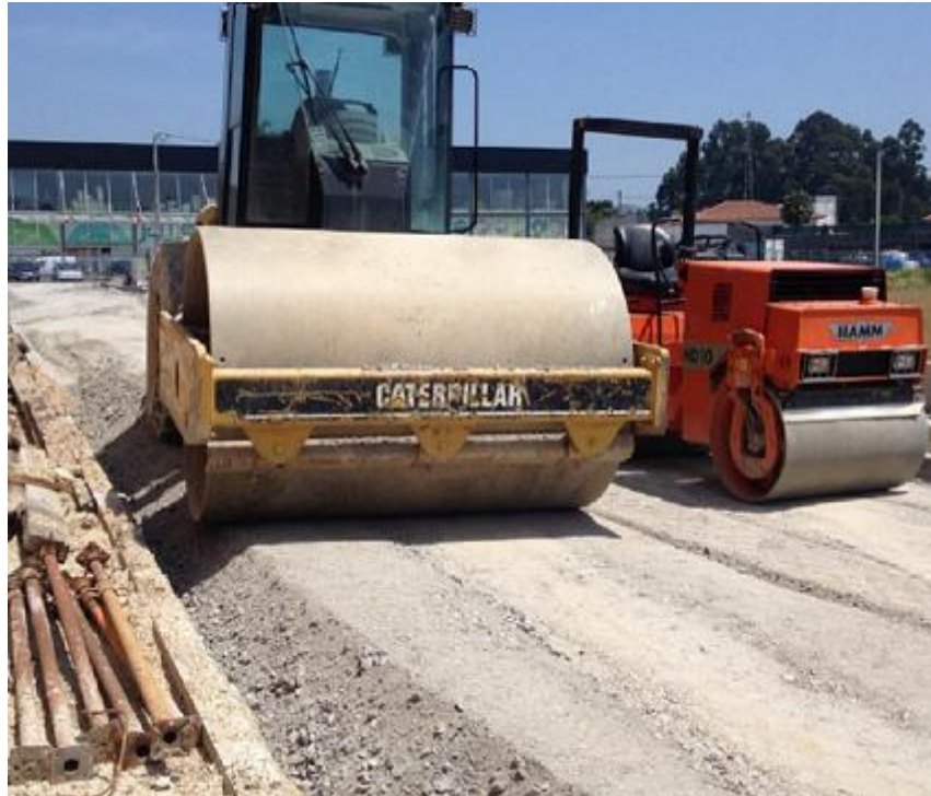
Figura 4.63 - Compactação da camada base
