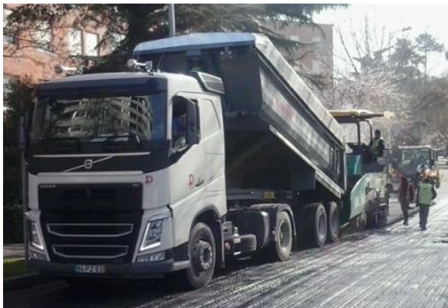
Figura 4.64 - Descarga da mistura betuminosa na espalhadora
