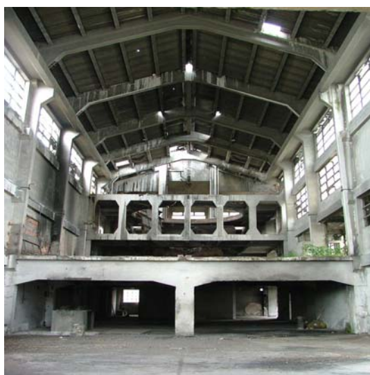
Fig.20. Nave da fábrica da Empresa Industrial do Freixo. No segundo e terceiro piso localizava-se o forno eléctrico.
