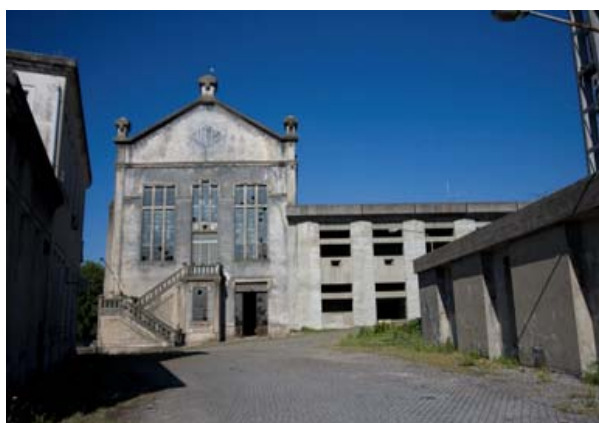
Fig. 24. Central do Freixo. Fachada Nascente. Podemos apreciar o novo corpo construído em 1972.
