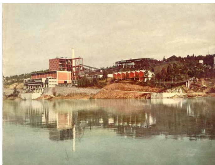
Fig.21. Central da Tapada do Outeiro da Empresa Termoeléctrica Portuguesa.
