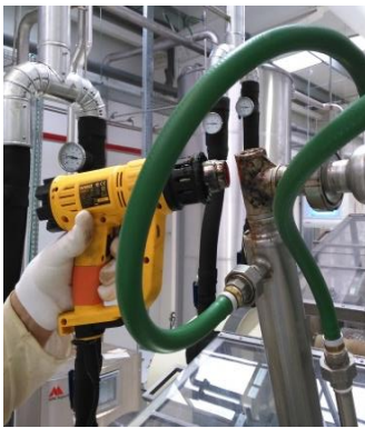
Figura 31: Aquecimento das tubagens com uma pistola de calor
