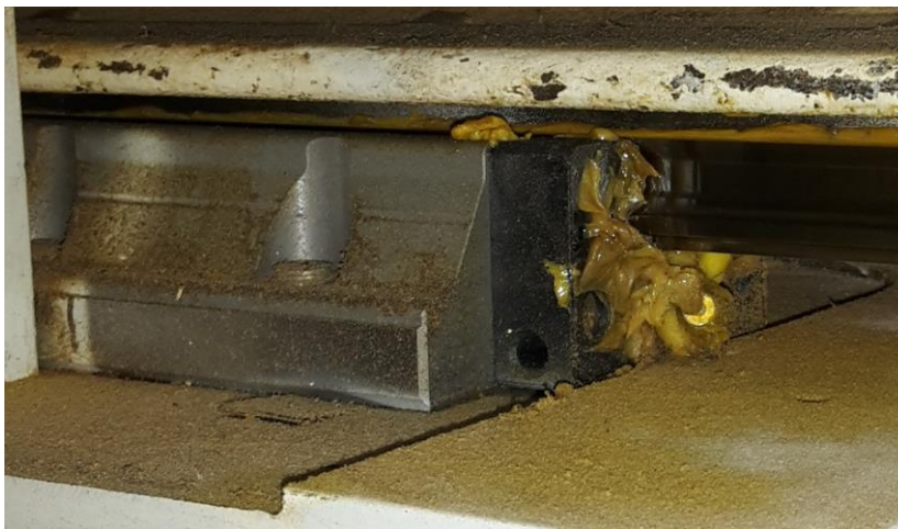
Figura 5.1 – Carro guia com lubrificação em excesso
