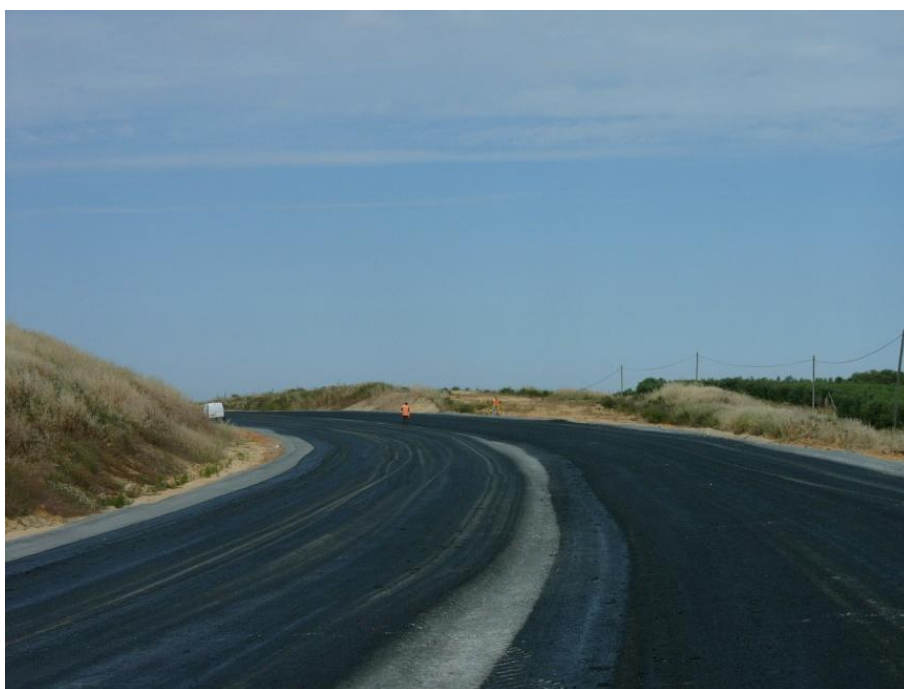
Fig.A.3.13 – Aspeto final da camada de base após rega de colagem
