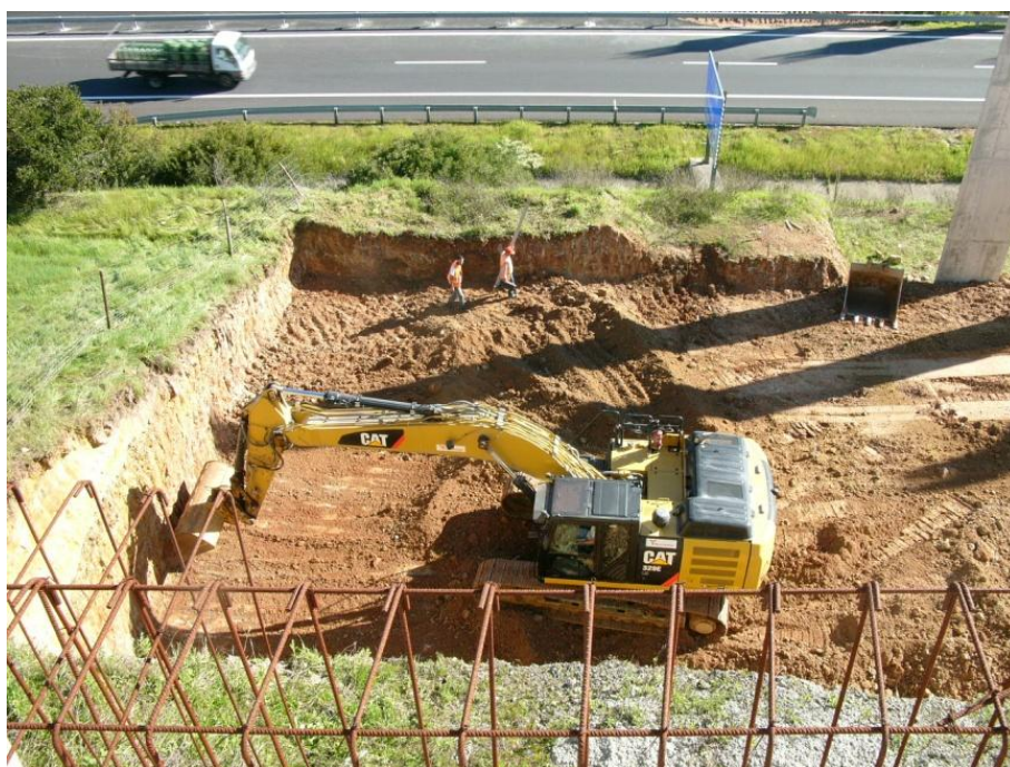
Fig. A.1.8 – Nivelamento do fundo de caixa da plataforma
