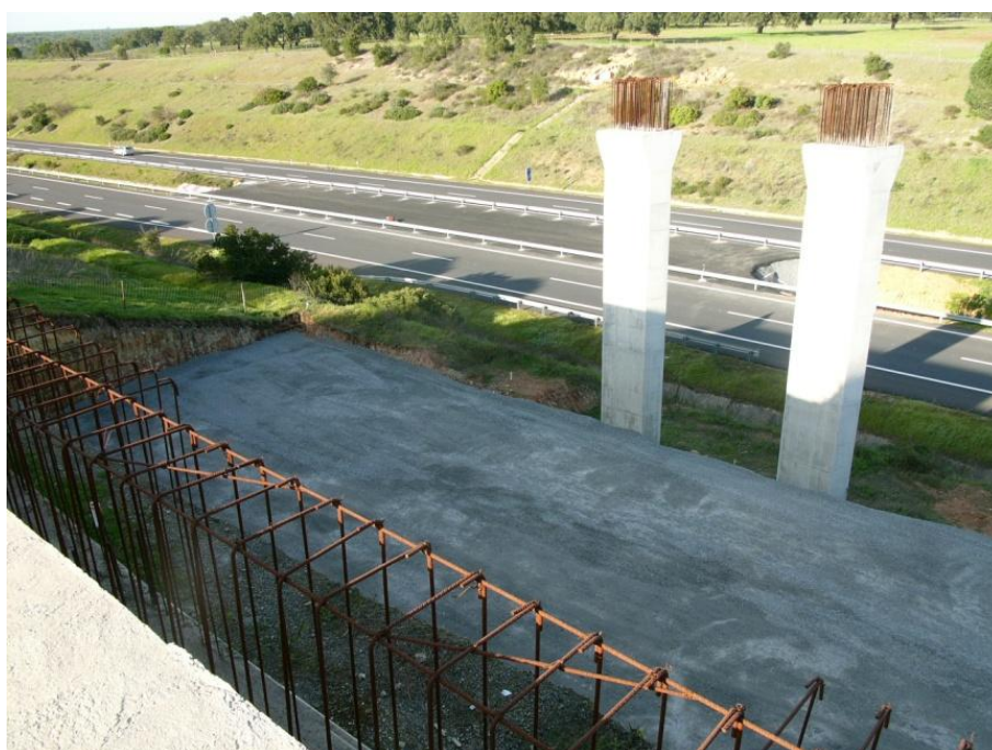
Fig. A.1.10 – Aspeto após colocação da primeira camada de agregado britado
