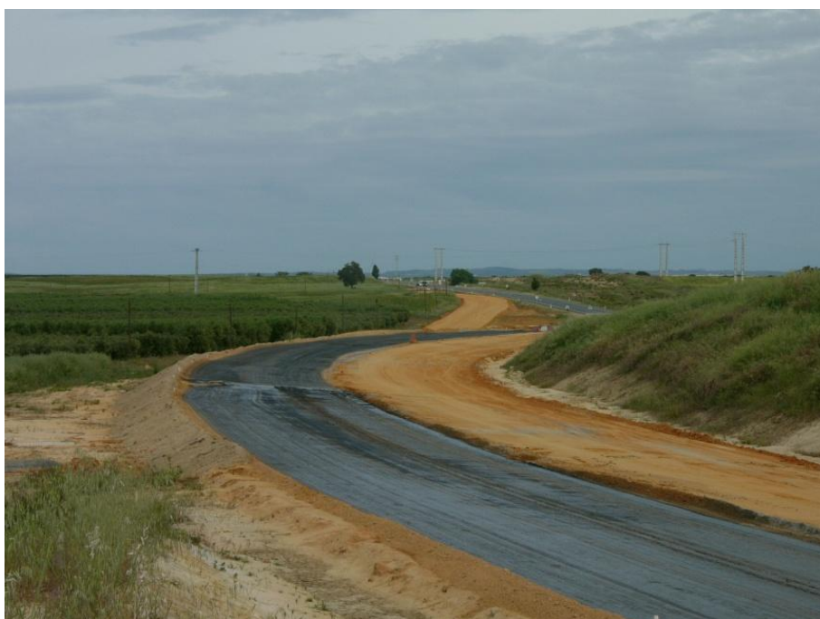
Fig. A.3.9 – Aspeto final da Camada do Leito do Pavimento numa das faixas da plataforma
