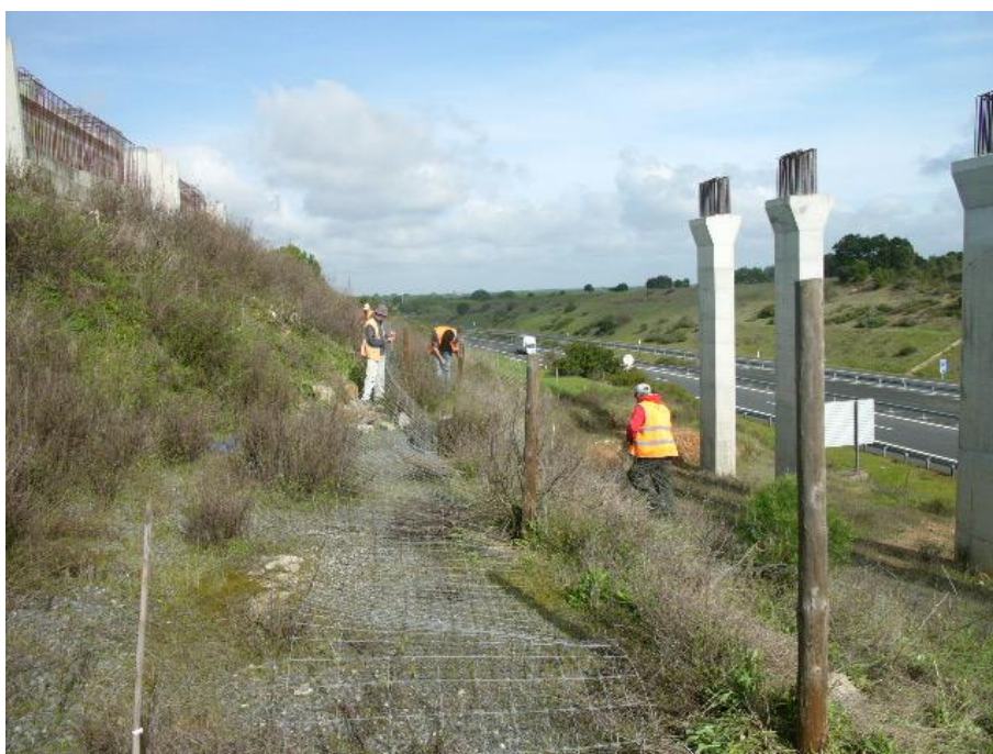
Fig. A.1.2 – Início da desmatação e remoção de vedações
