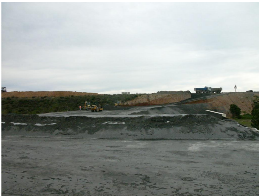
Fig A.2.5 – Aspeto geral do aterro em construção
