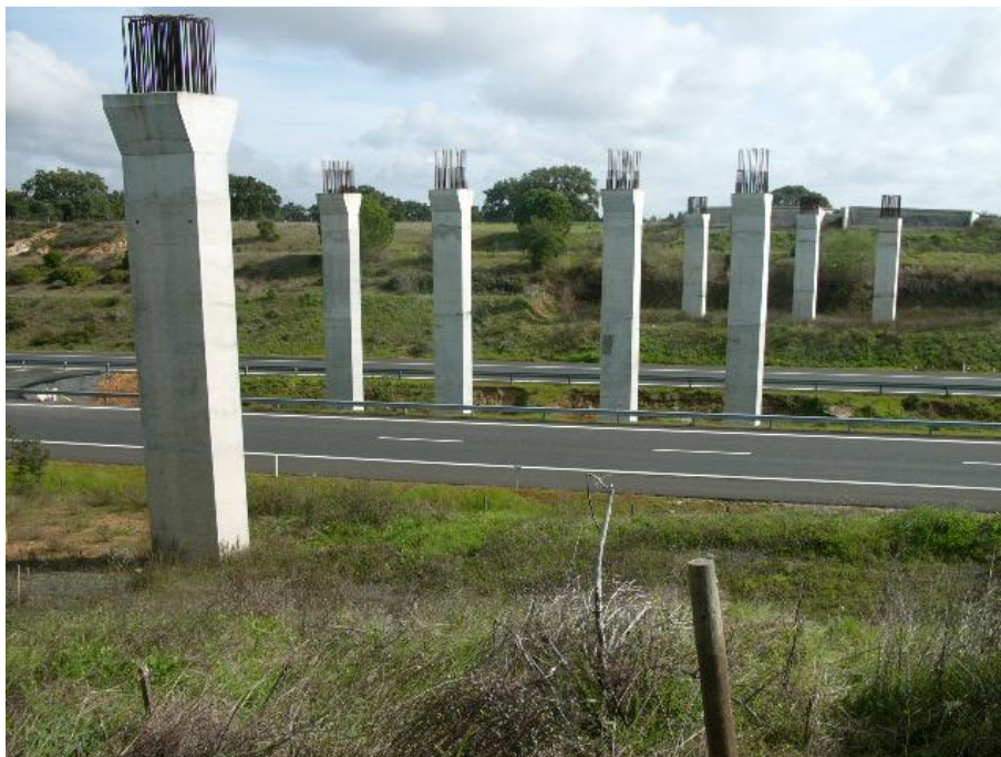
Fig. A.1.1 – Aspeto geral antes da construção das plataformas
