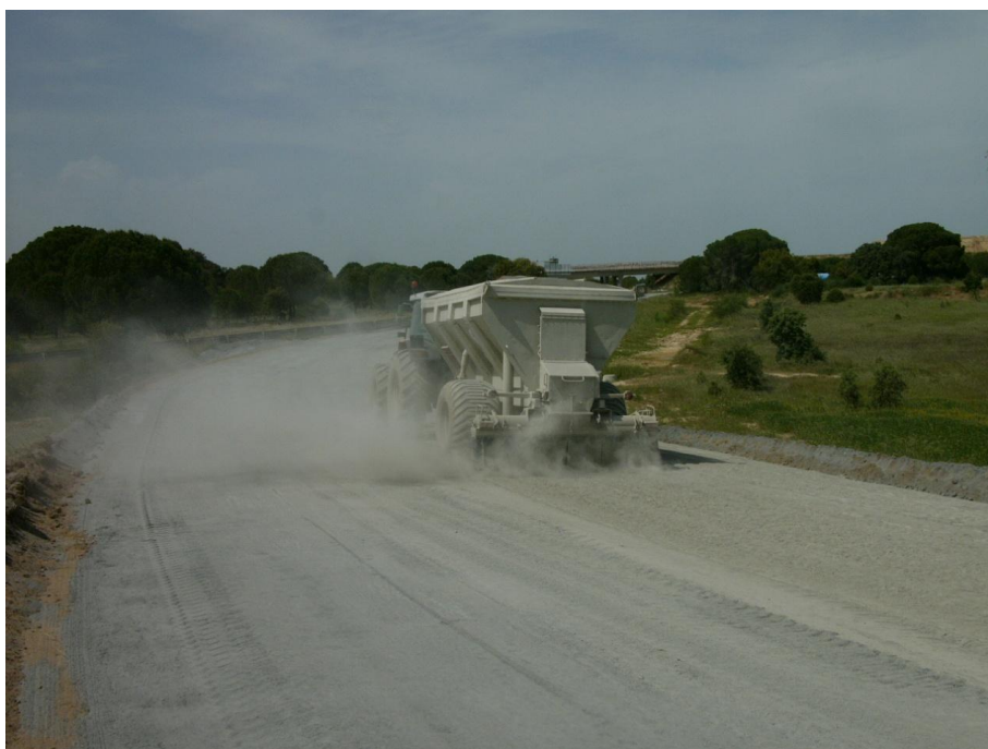
Fig.A.3.1 – Aplicação do cimento em pó sobre a PSA
