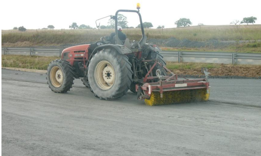
Fig. A.3.11 – Processo de varrimento da camada de base
