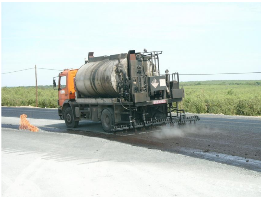
Fig.A.3.12 – Aplicação de rega de colagem por impregnação betuminosa de rotura lenta
