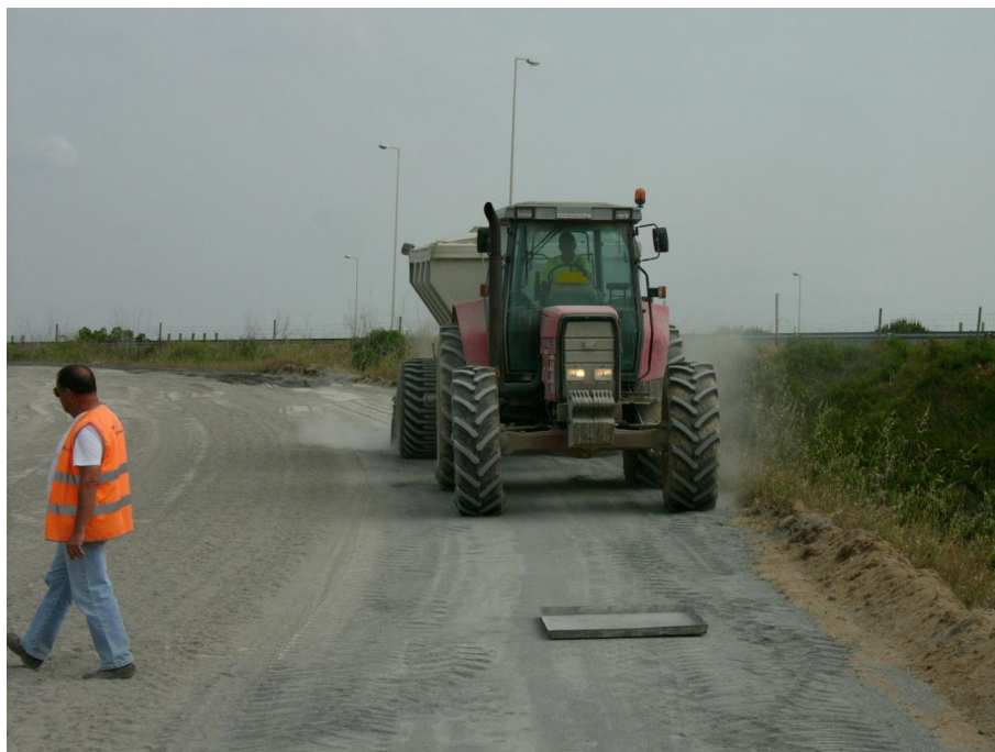
Fig. A.3.4 – Verificação da quantidade de cimento depositada por m 2
