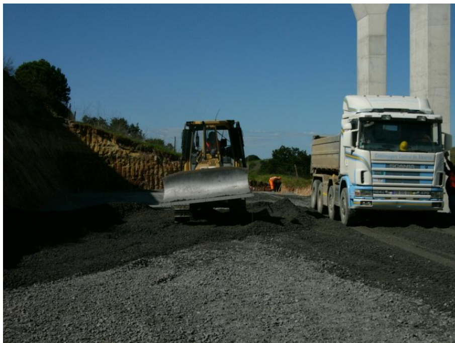
Fig. A.1.11 – Início do espalhamento da segunda camada de agregado britado
