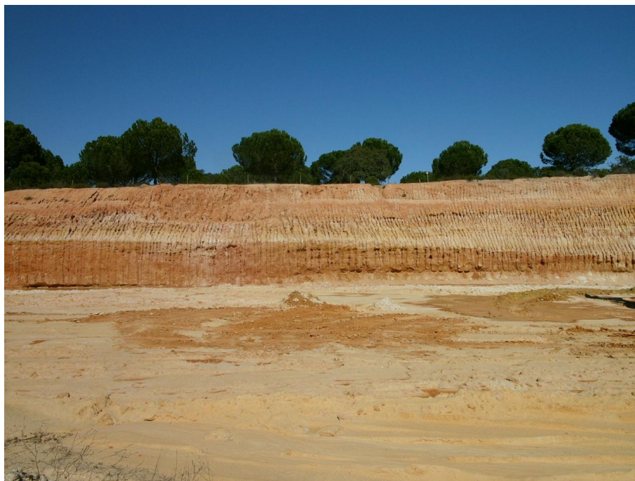
Fig.4.15 – Local de empréstimo da areia siltosa mal graduada a aplicar nos ramos de acesso ao nó de ligação com o IP8
