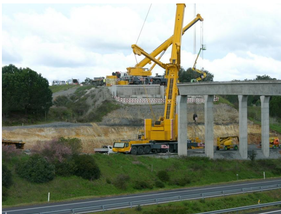
Fig.A.1.12 – Gruas em operação
