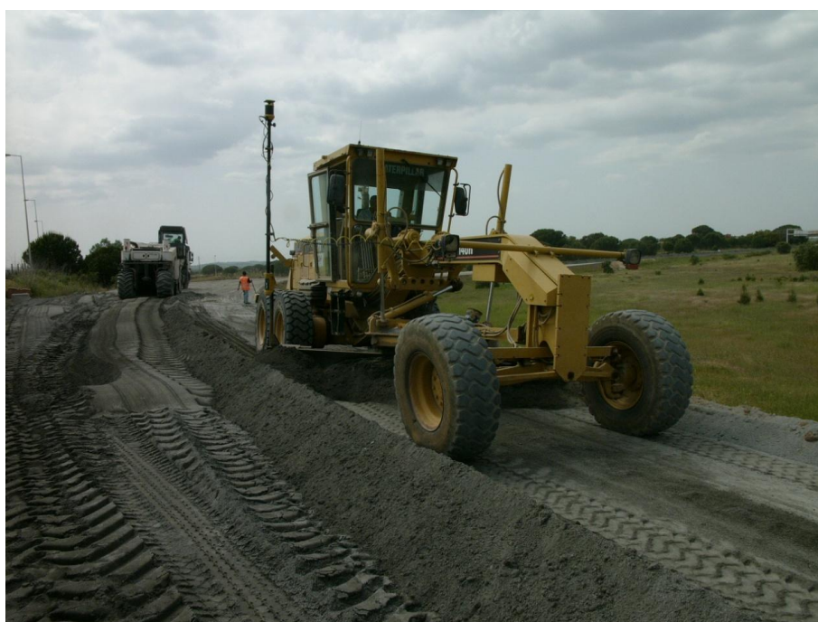
Fig. A.3.3 – Nivelamento da camada tratada pelo cimento
