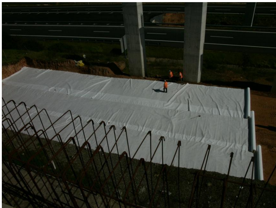
Fig. A.1.9 – Colocação do geotêxtil sobre o fundo de caixa
