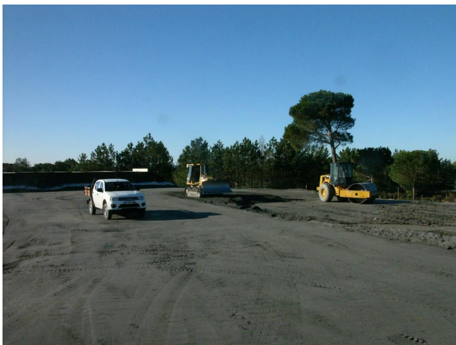
Fig.A.2.2 – Operações de espalhamento e compactação
