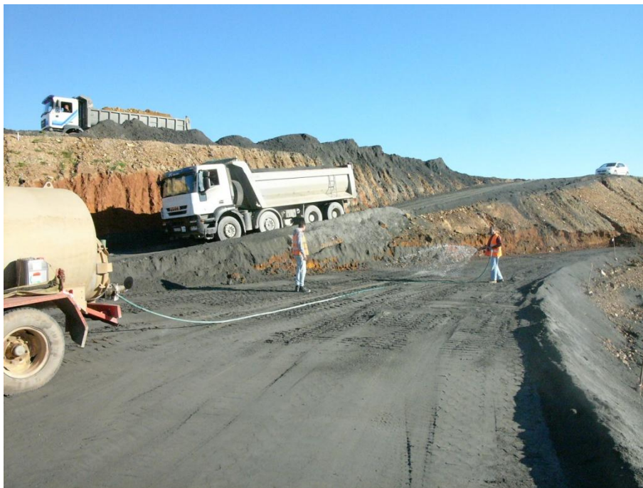
Fig.A.2.1 – Humidificação da camada antes da compactação
