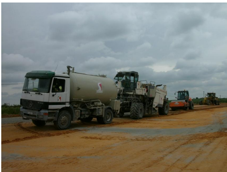
Fig. A.3.7– Conjunto cisterna de água, máquina misturadora, cilindro, niveladora
