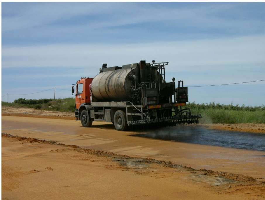
Fig. A.3.8 – Rega de impregnação para impermeabilização do leito do pavimento
