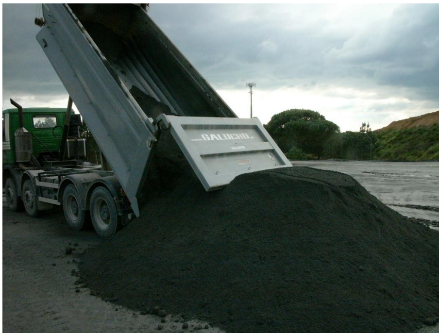
Fig.A.2.3 – Descarga do material britado para espalhamento
