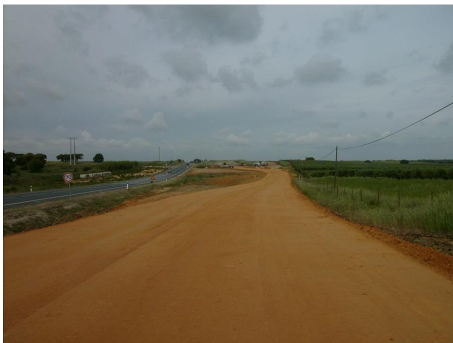
Fig. A.3.5 – Aspeto da superfície da Parte Superior do Aterro antes da aplicação do solo-cimento
