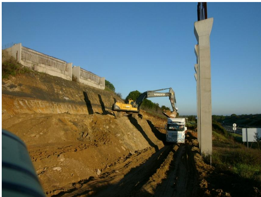
Fig. A.1.5 – Extração frontal de terras e carga no camião para transporte
