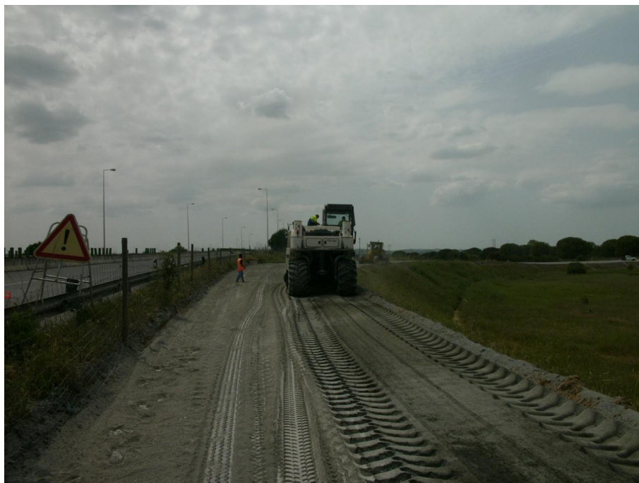
Fig.A.3.2 – Mistura do cimento com o material granular britado
