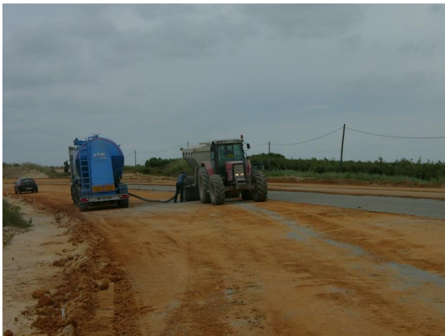
Fig. A.3.6 – Transferência do cimento do camião cisterna para a espalhadora
