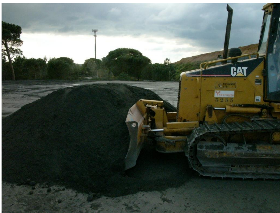
Fig.A.2.4 – Espalhamento com Bulldozer
