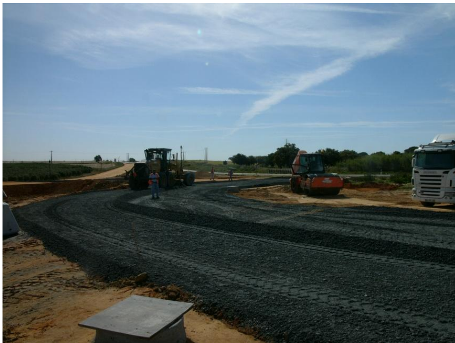
Fig.A.3.10 – Nivelamento das camadas granulares
