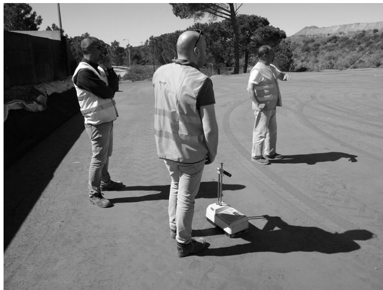
Fig.4.12 –Utilização do gamadensímetro para leitura do Grau de Compactação de uma camada de aterro
