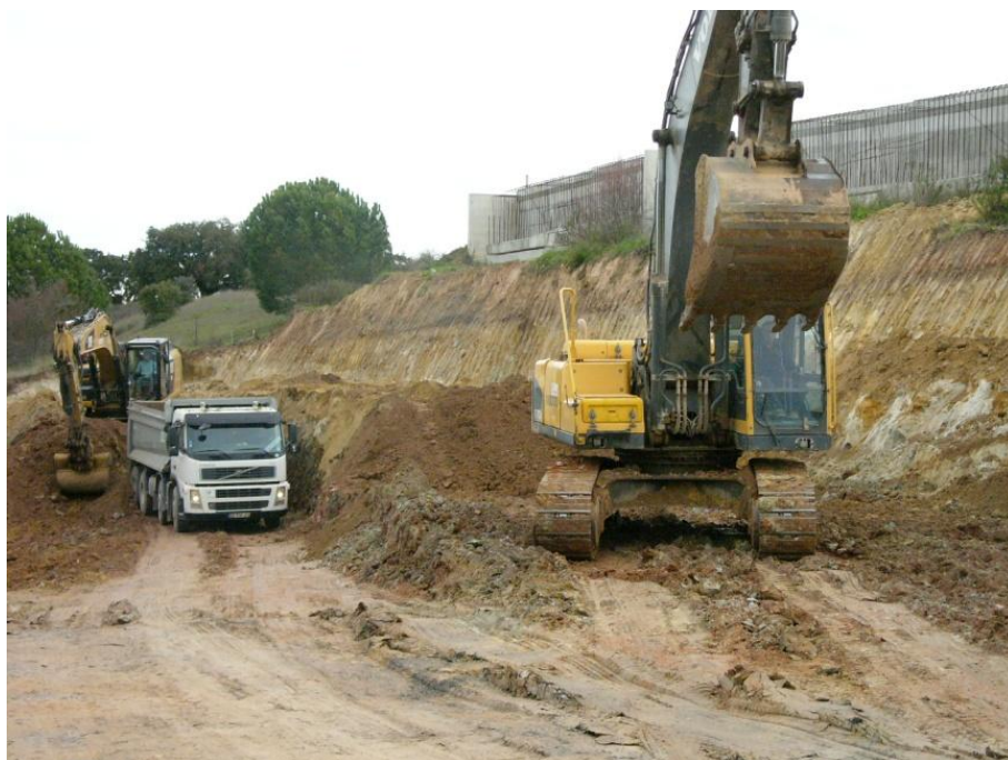
Fig. A.1.7 – Extração frontal de terras e carga no camião para transporte
