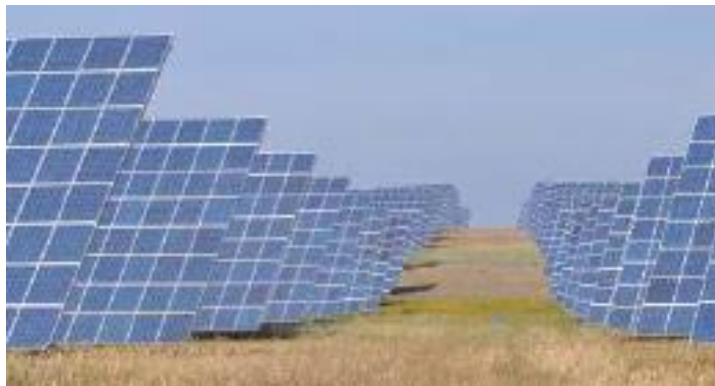
Figura 3.29 - Representação correta de orientação dos módulos fotovoltaicos segundo o sol , referência [15].
