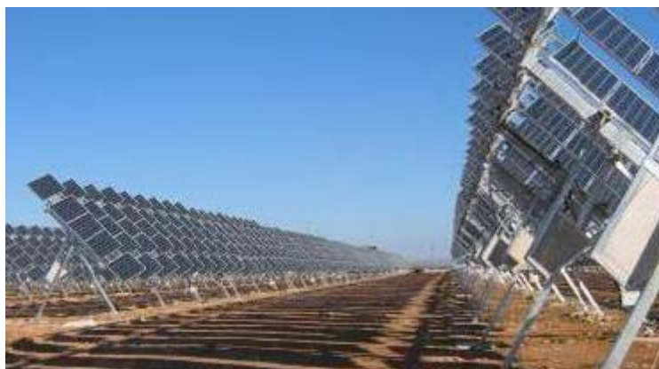
Figura 3.5 - Representação de módulos Fotovoltaicos orientados segundo o sol, referência [15].
