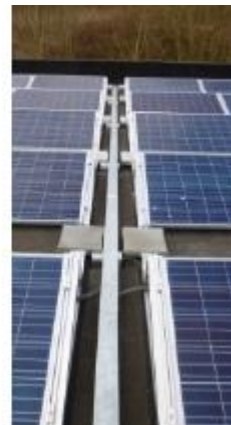
Figura 3.22 - Representação de uma expansão transversal, referência [15].
