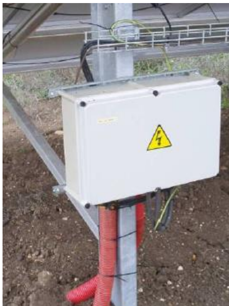
Figura 14 - Representação de uma caixa de ligação devidamente rotulada, referência [15].
