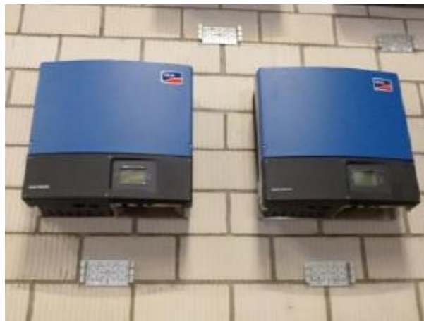
Figura 3.6 - Representação de dois inversores fixo numa parede, referência [15].
