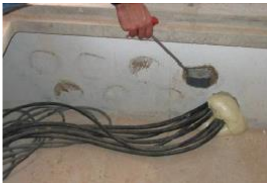
Figura 3.12- Representação de um edifício impermeável, onde as entradas de água estão seladas, referência [15].
