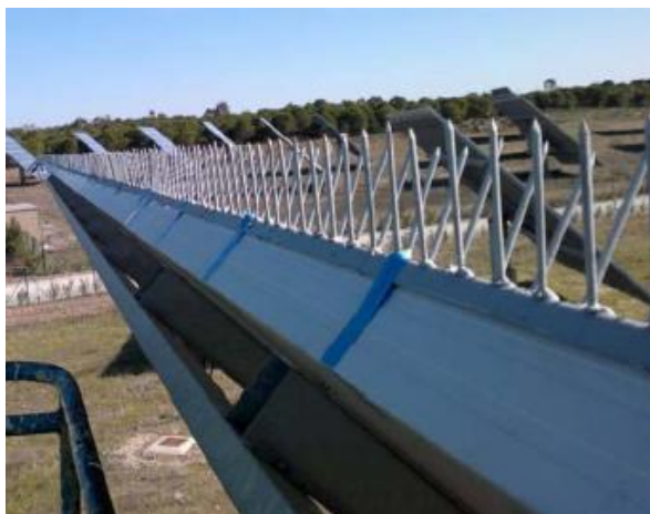
Figura 3.30 - Representação de dispositivos contra as aves nos topos dos módulos FV, referência [15].
