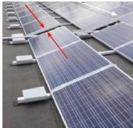
Figura 3.22 - Representação de uma expansão transversal, referência [15].
