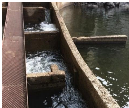
Fig. 37 - Diferentes tipos de jatos pelo descarregador superficial: jato desafogado (bacia superior) e jato afogado (bacia inferior)
