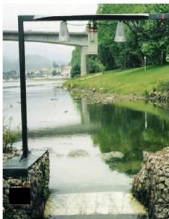
Fig. 65 - Sugestão de um sistema de contagem visual nos dispositivos do tipo bacias sucessivas (Pinheiro, et al., 2005)
