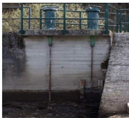
Fig. 36 - Orifícios de entrada de água (saída de peixes) no dispositivo munidos de comportas do tipo mural
