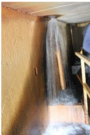
Fig. 24 - Descarga de caudal proveniente do corpo da barragem
