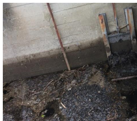
Fig. 36 - Orifícios de entrada de água (saída de peixes) no dispositivo munidos de comportas do tipo mural
