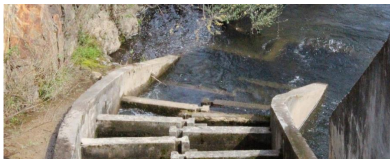
Fig. 47 - Bacias inferiores do dispositivo do A.H. Torga inundadas
