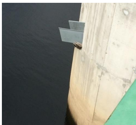
Fig. 30 - Rampa de lançamento dos peixes na albufeira - Dispositivo de Rebordelo
