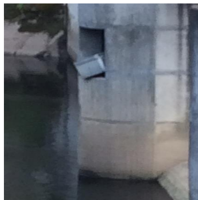
Fig. 23 - Desnível entre a soleira de saída dos peixes do elevador e o nível de albufeira
