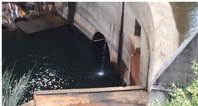
Fig. 31 - Inexistência de acesso às bacias sucessivas do dispositivo de Rebordelo
