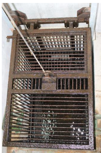
Fig. 63 - Cuba do elevador do A.H. Rebordelo de cor escura
