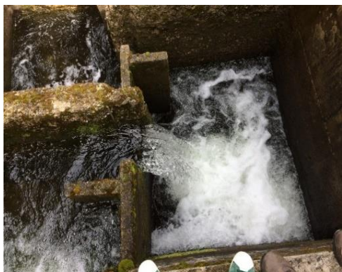
Fig. 48 - Existência de condições hidráulicas que impossibilitam a passagem de peixes
