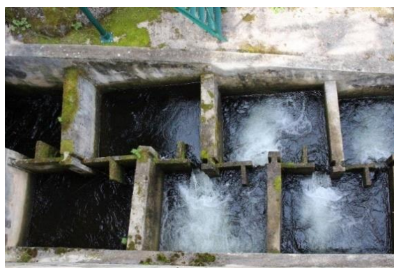
Fig. 51 - Fraca dissipação de turbulência nas bacias
