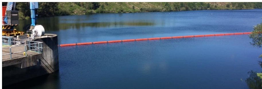
Fig. 59 - Grelha de retenção de detritos no elevador de Touvedo
