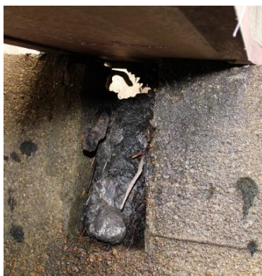
Fig. 39 - Obstrução do descarregador lateral
