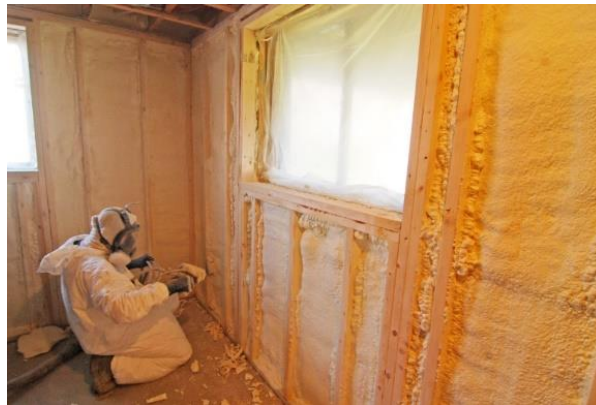
Figura 3.15 – Aplicação de poliuretano projetado [56]
