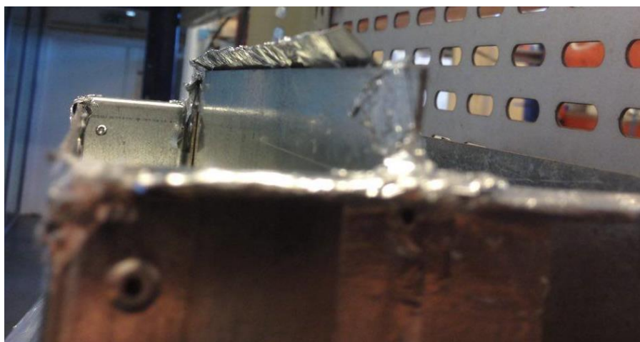
Figura 4.45 - Fotografia da cantoneira utilizada na divisória entre o compartimento dos gases de combustão e da insuflação de ar,
