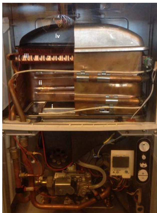
Figura 2.1 - Vista em corte de um esquentador.
