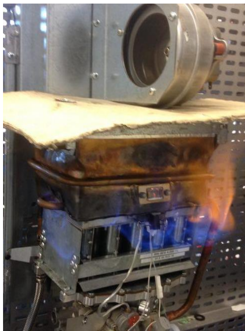
Figura 4.22 - Fotografia elucidativa do fenómeno de fuga de chama.
