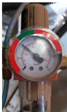
Figura 40-Marcação dos manómetros
