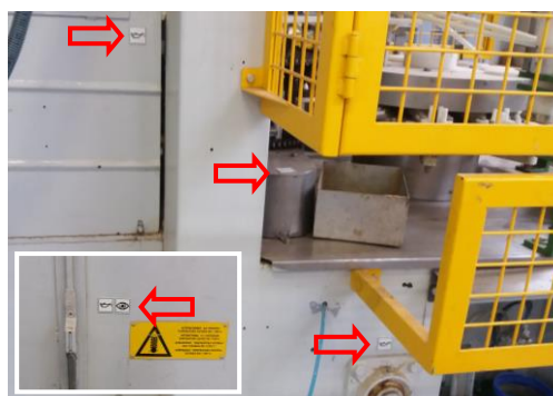
Figura 45-Exemplo de gestão visual realizada na colagem
