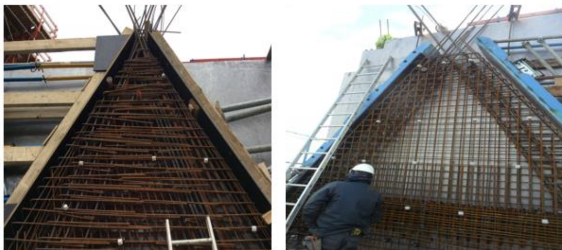
Figura 41 - Antes e depois das alterações de armadura dos muros
