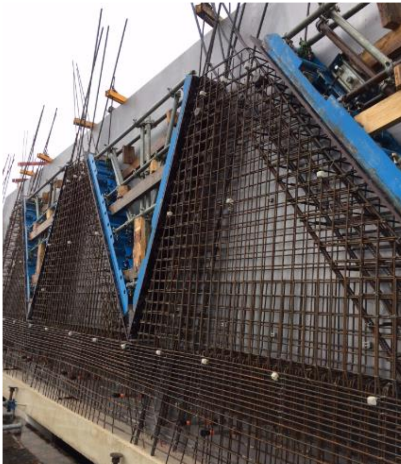
Figura 23 - Fixação das cofragens das janelas ao painel
