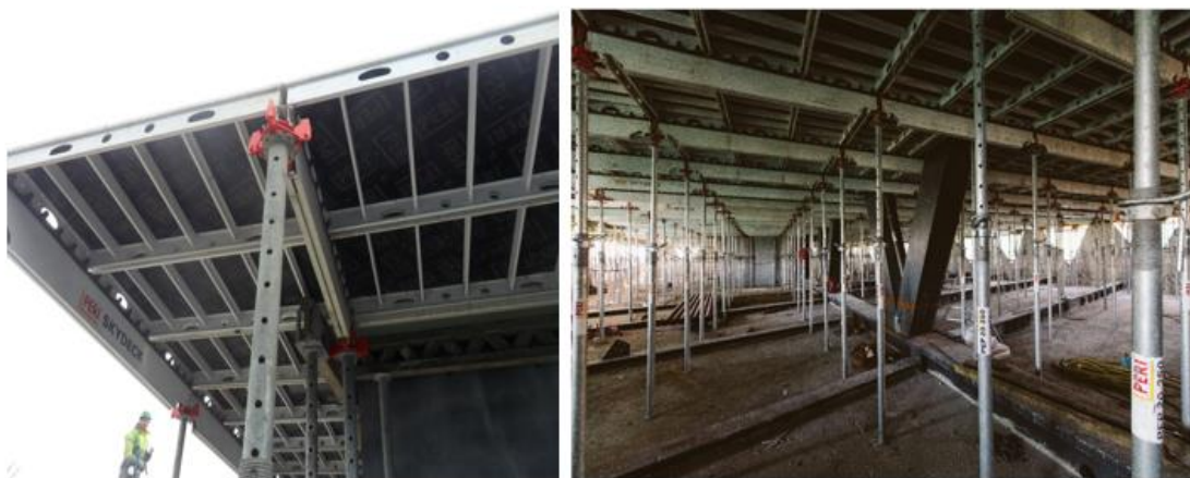
Figura 26 - Montagem do sistema "Skydeck"
