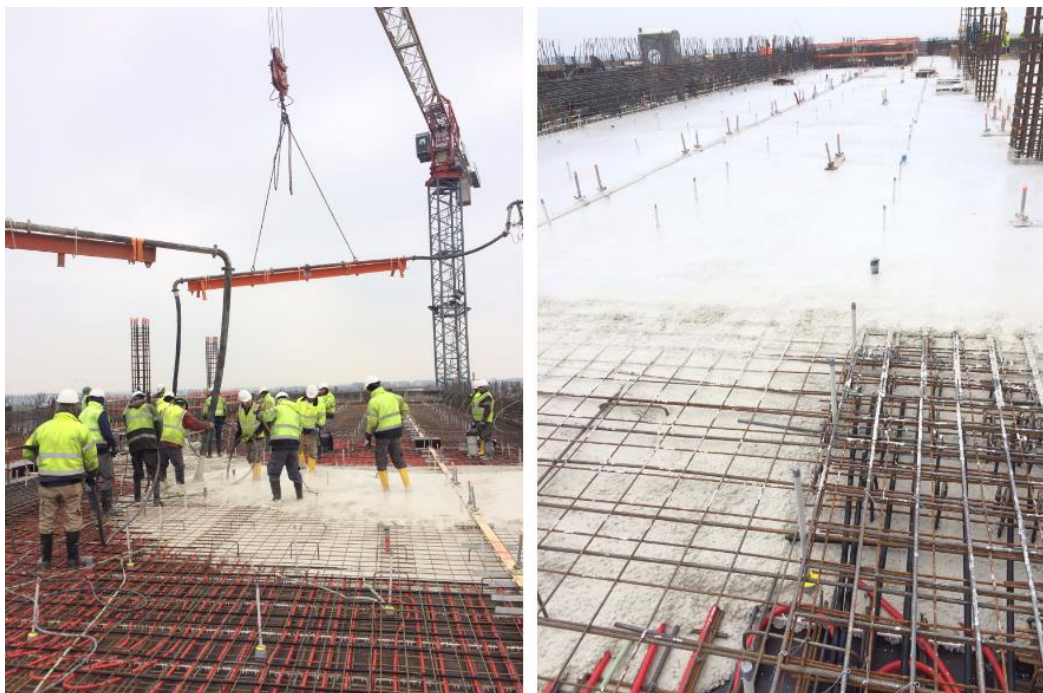
Figura 30 - Fase de betonagem
