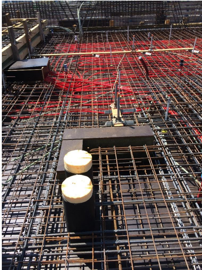
Figura 42 - Colocação de "negativos" na laje
