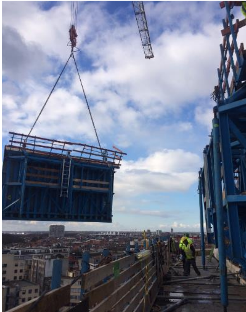
Figura 21 - Colocação do painel de cofragem
