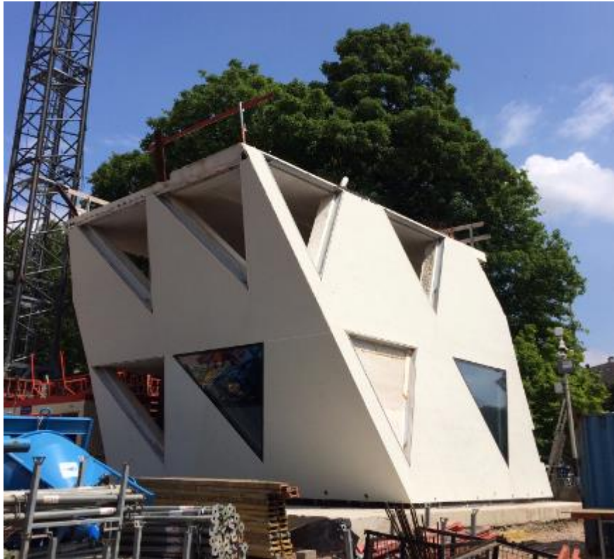
Figura 43 - Ilustração do "Mockup" inserido no estaleiro de obra
