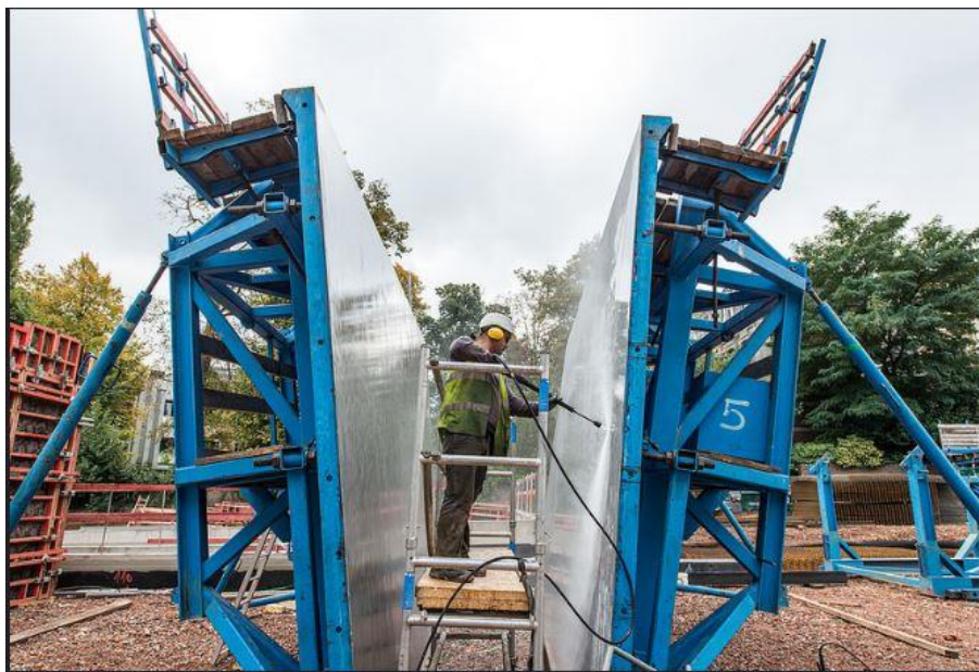
Figura 20 - Lavagem de cofragem
