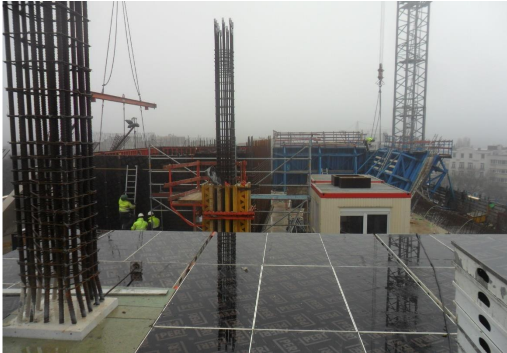
Figura 34 - Representação da colocação da cofragem "skydeck" da Peri
