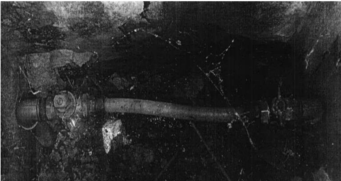
Figura 4.23: Ligação direta nº 2 detetada no município de Vila Nova de Gaia
