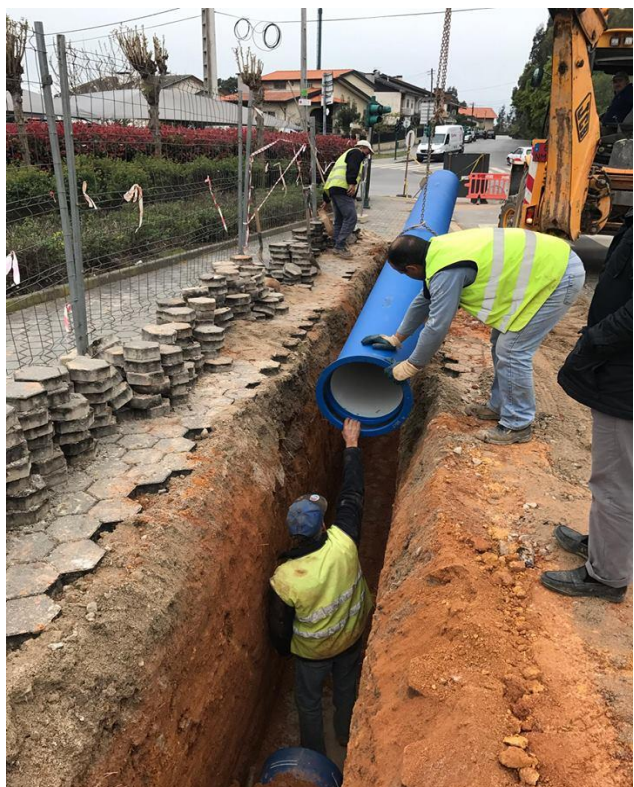
Figura 4.6: Colocação da conduta.
