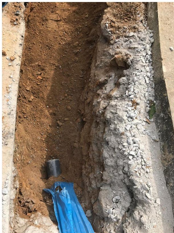
Figura 4.11: Conduta inserida.
