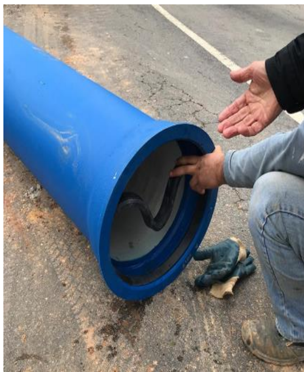
Figura 4.5: Preparação da conduta a inserir.
