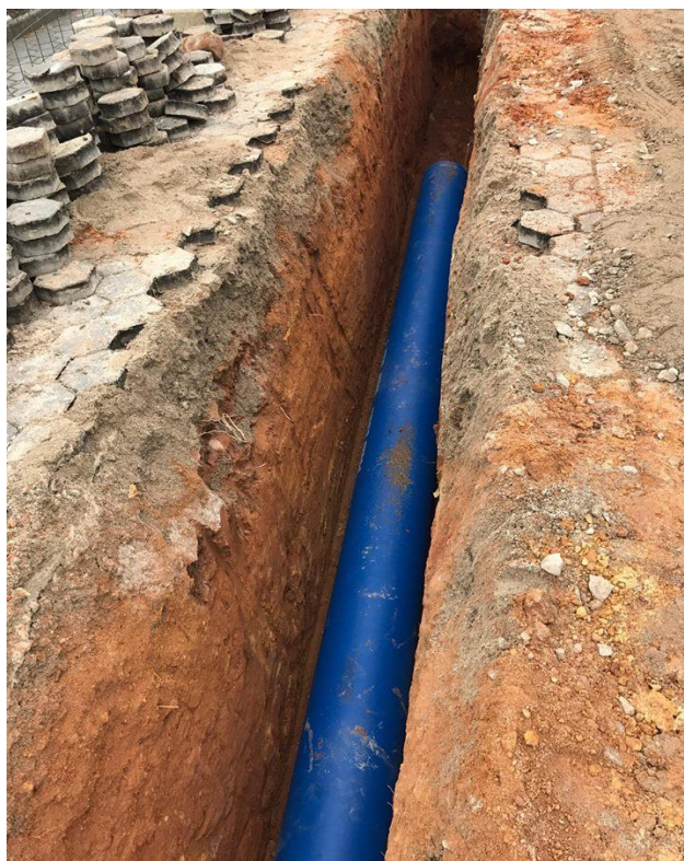
Figura 4.7: Conduta inserida.
