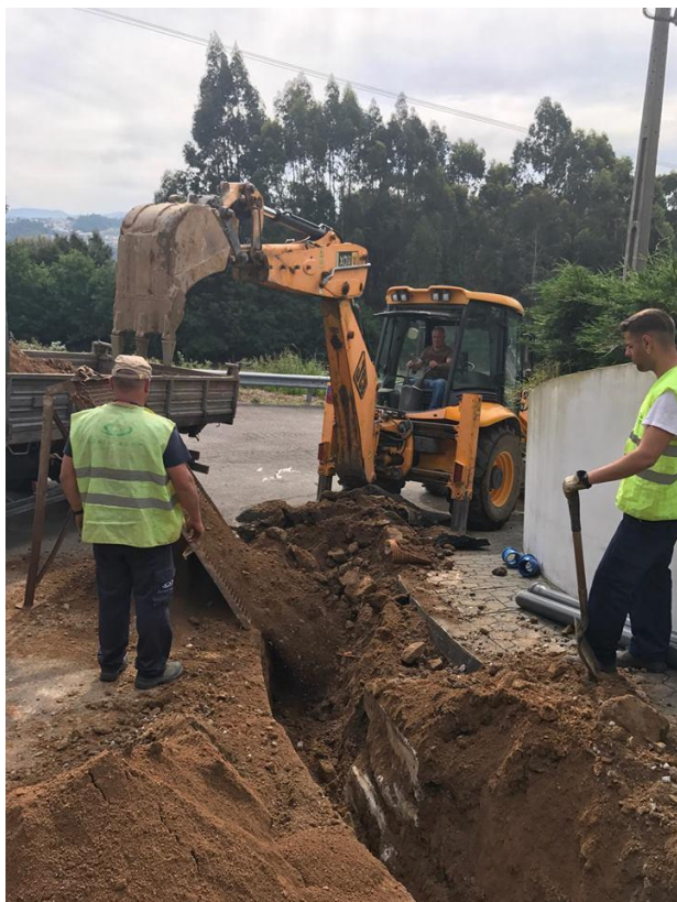
Figura 4.8: Escavação do terreno.
