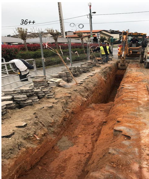
Figura 4.4: Escavação do terreno.
