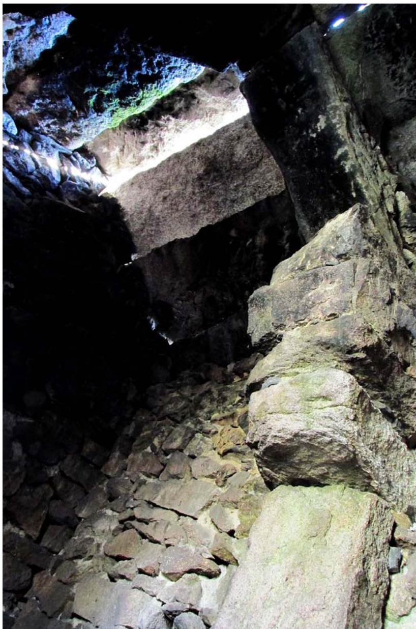
Fig. 31 – Pormenor da estrutura de sustentação da cobertura. Forno nº2 do Lugar da Seara (branda), situado na “Bezerreira” (expressão local). 2014
