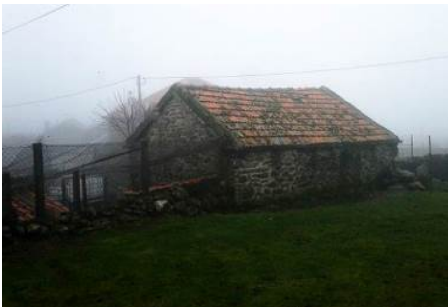
Fig. 3 – Forno de Lugar das Eiras (branda). Vista Nordeste. 2017
