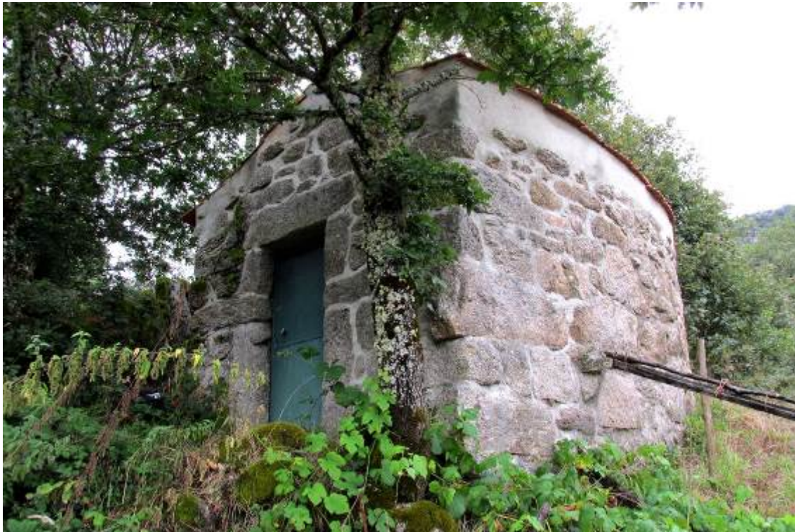
Fig. 42 – Forno nº1 do Lugar do Bago de Baixo (inverneira). Vista Sudoeste. 2014
