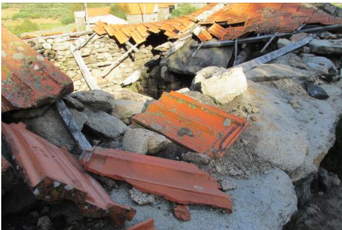
Fig. 61 – Forno nº2 do Lugar de Portos (branda). Vista Noroeste sobre a cobertura. 2014
