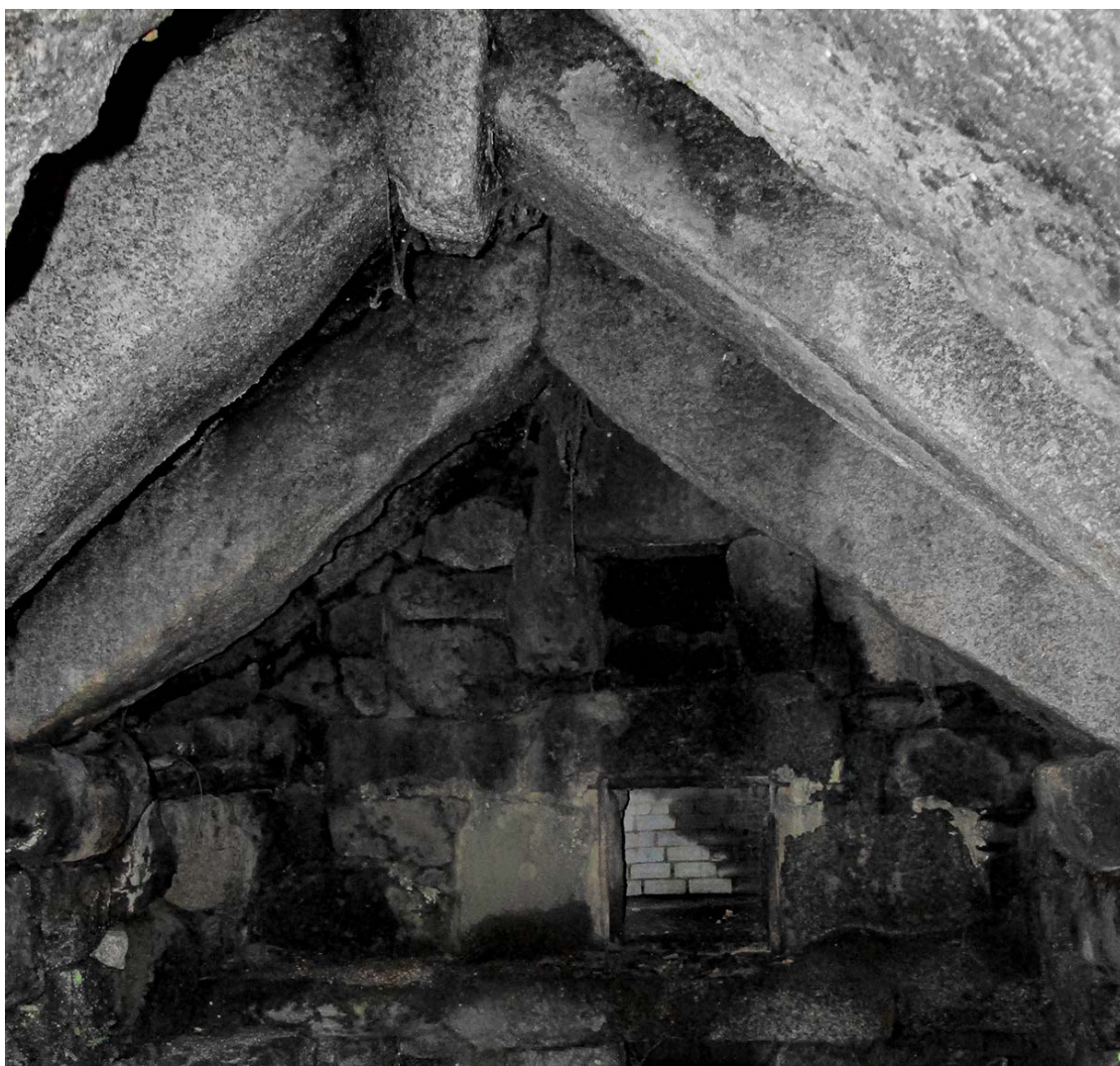
Fig. 28 – Pormenor da estrutura de sustentação da cobertura. Forno nº2 do Lugar do Barreiro (inverneira). 2014
