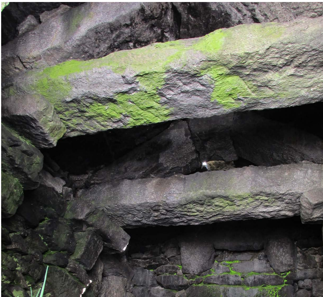
Fig. 30 – Pormenor da estrutura de sustentação da cobertura. Forno nº3 do Lugar do Rodeiro (branda), situado no “Vido do Rodeiro” (expressão local). 2014
