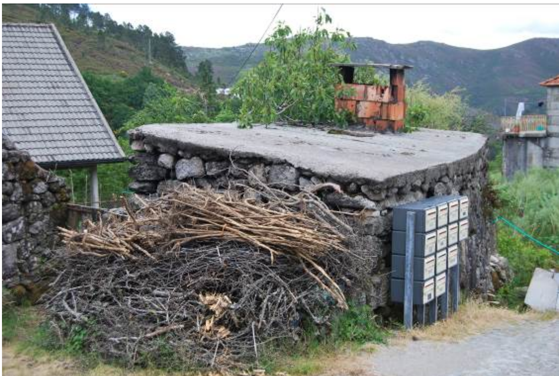
Fig. 40 – Forno do Lugar de Ribeiro de Cima. Vista Norte. 2014
