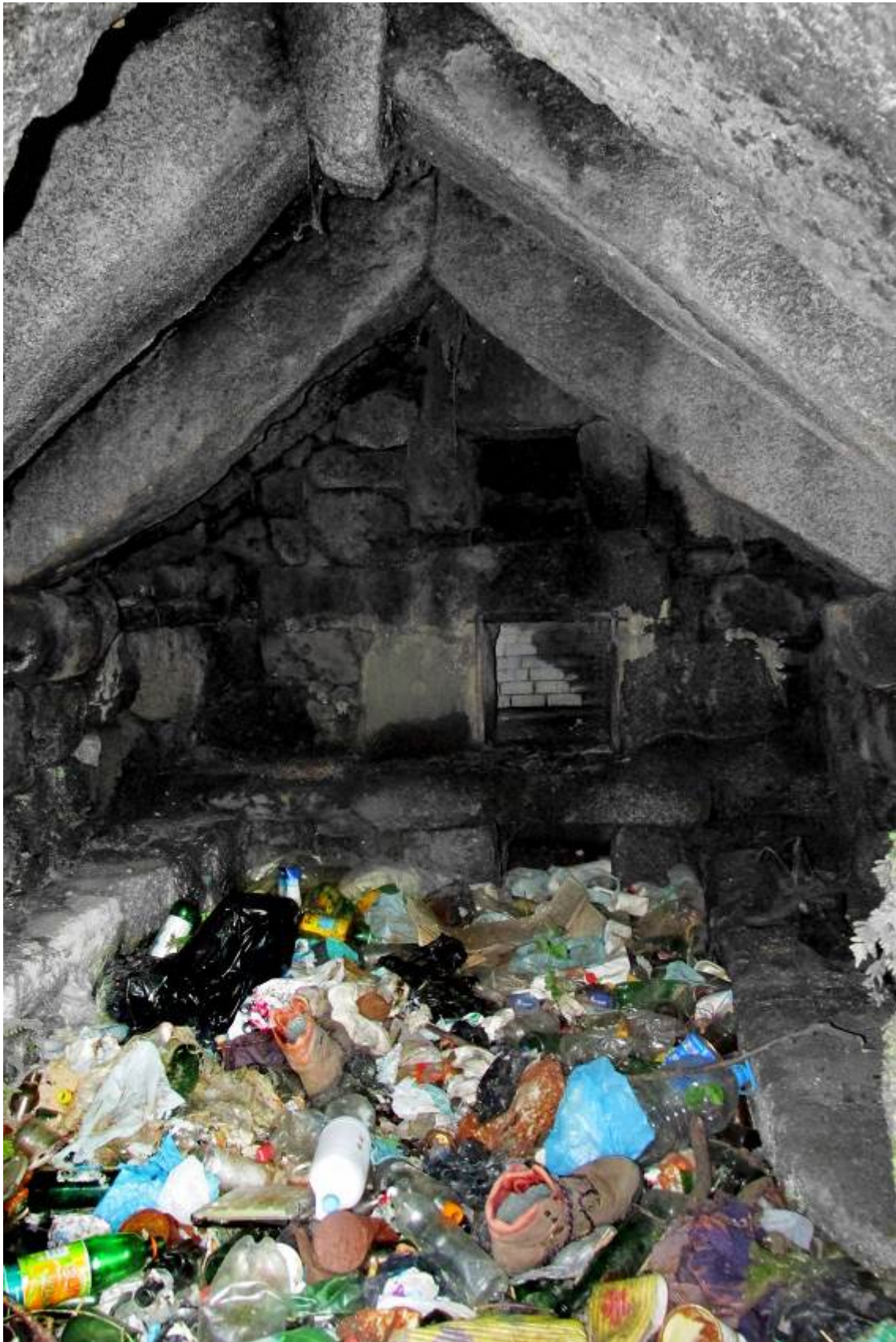
Fig. 47 – Interior do forno nº2 do Lugar do Barreiro (inverneira). 2014
