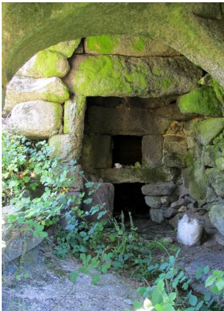
Fig. 56 - Forno do Lugar de Varziela (inverneira). Pormenor da parede Sul (lado esquerdo), parcialmente arruinada, por onde penetra a vegetação no interior do forno. 2014
