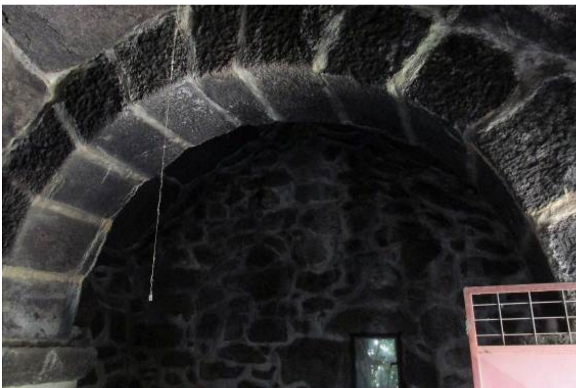
Fig. 27 – Pormenor de um dos arcos de sustentação da cobertura. Forno do Lugar de Curveira (inverneira). 2014
