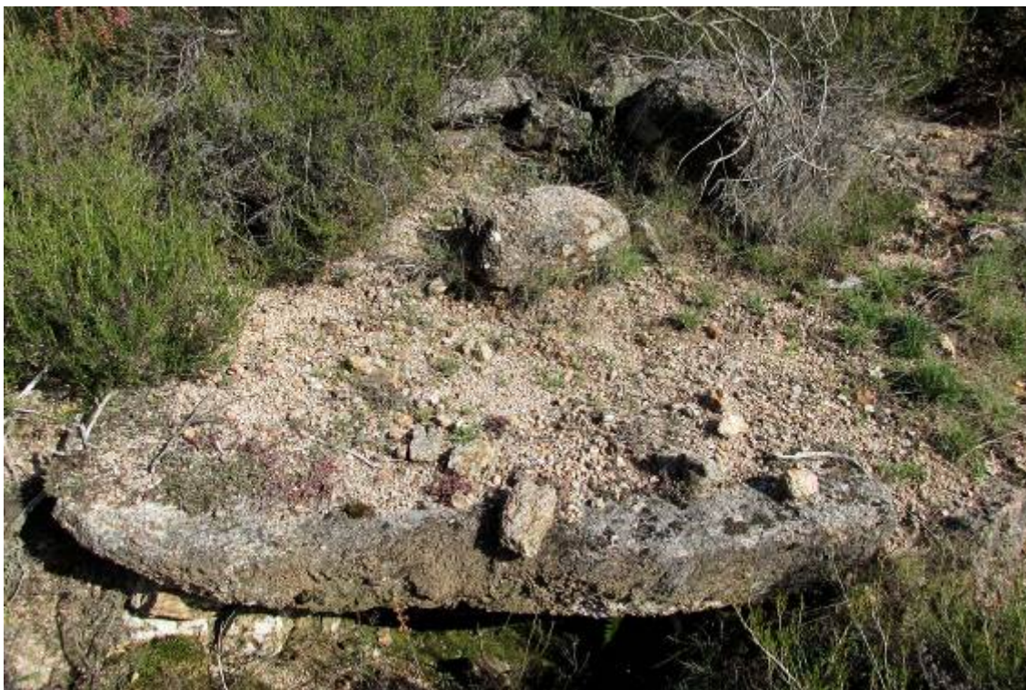
Fig. 34 – Forno nº2 do Lugar do Bago de Baixo (inverneira). Outra perspetiva. Em ruína. 2014
