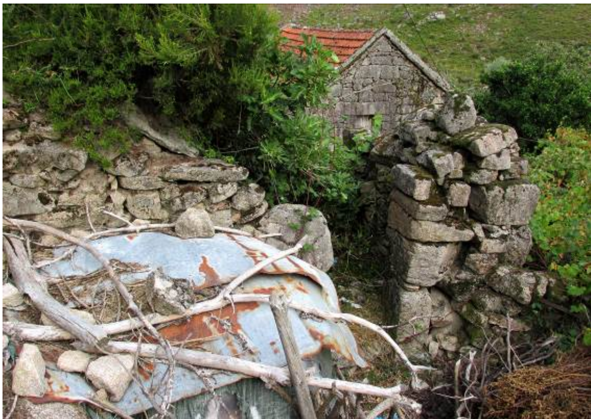
Fig. 63 - Forno do Ribeiro de Baixo (lugar fixo). Vista Noroeste. Arruinado, com exceção da fornalha. 2015
