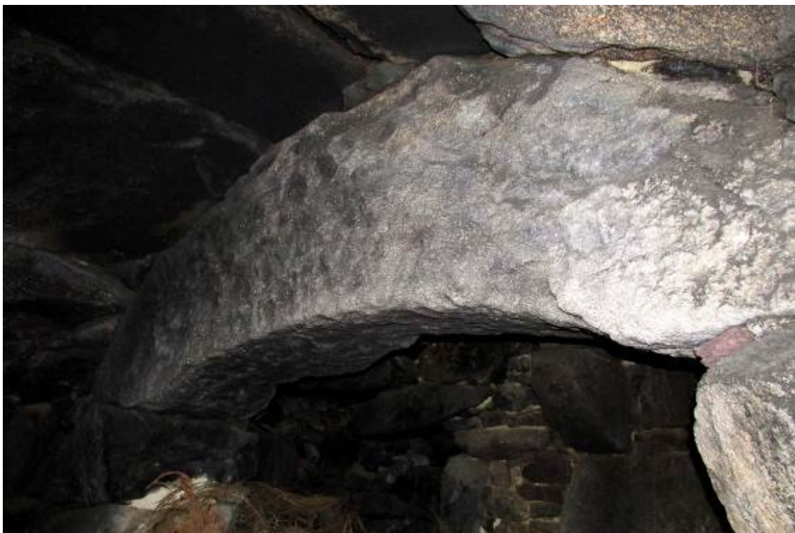
Fig. 29 – Pormenor do arco (em monólito) de sustentação da cobertura. Forno do Lugar de Curral do Gonçalo (branda). 2017
