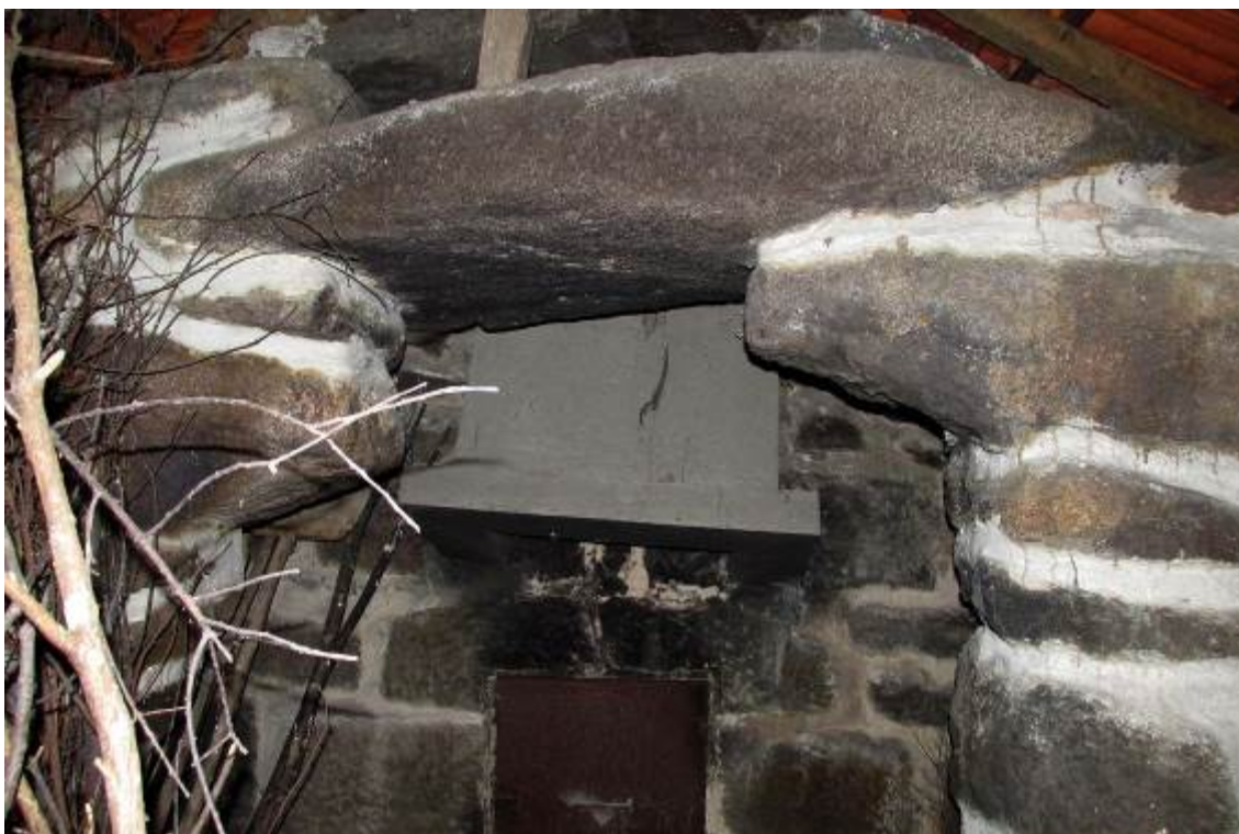
Fig. 26 – Pormenor da estrutura de sustentação antiga da cobertura, que hoje é em vigas de madeira. Forno do Lugar de Mareco (inverneira). 2014
