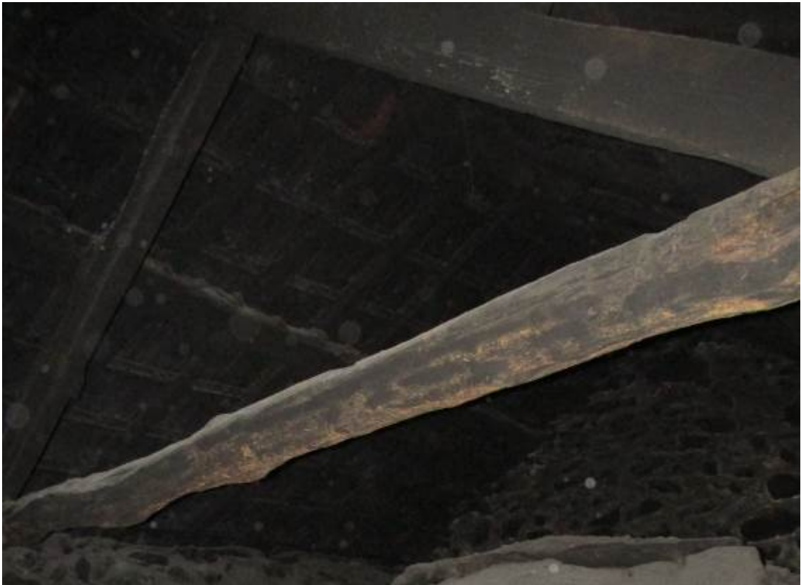
Fig. 32 – Pormenor da estrutura de sustentação da cobertura em madeira. Forno do Lugar de Eiras (branda).
