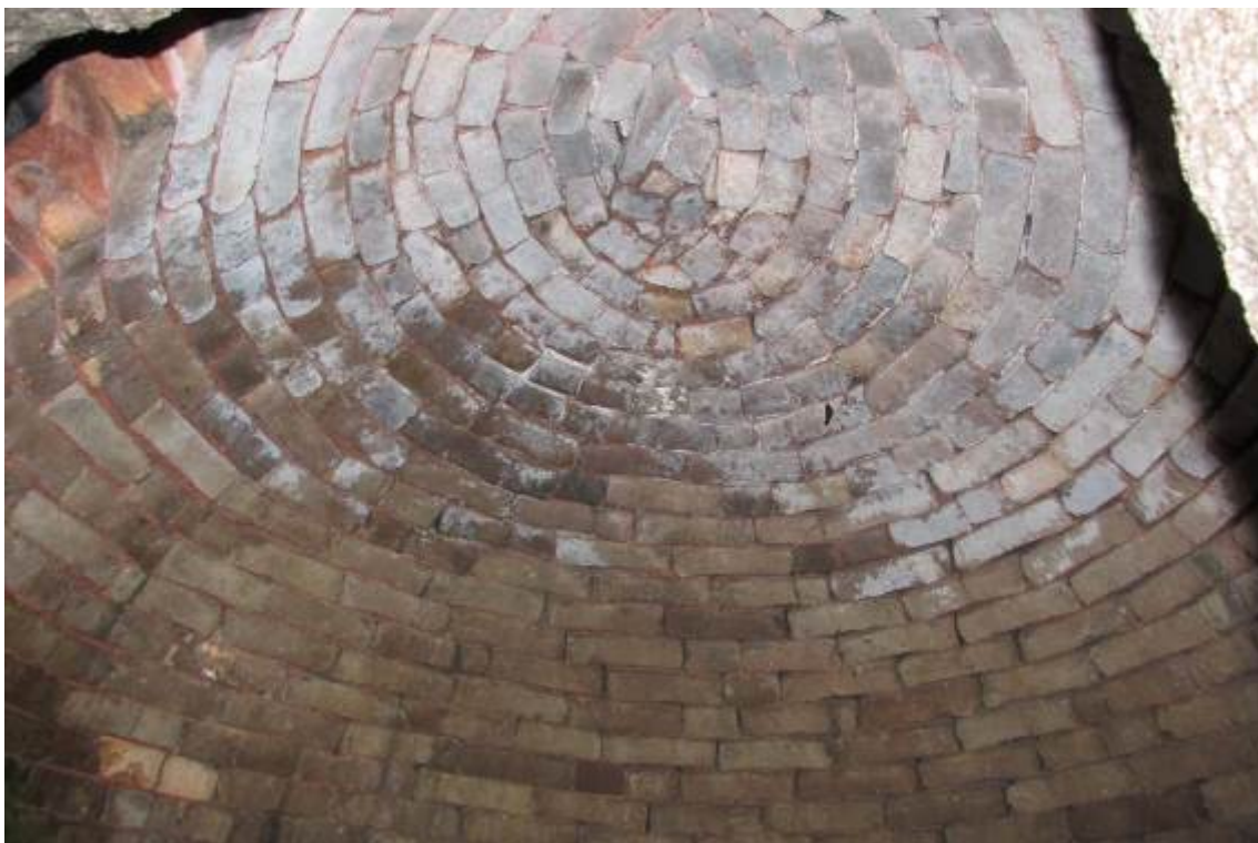
Fig. 6 - Estrutura em cúpula vista do interior. Fornalha do forno nº2 do Lugar da Seara (branda). 2014.
