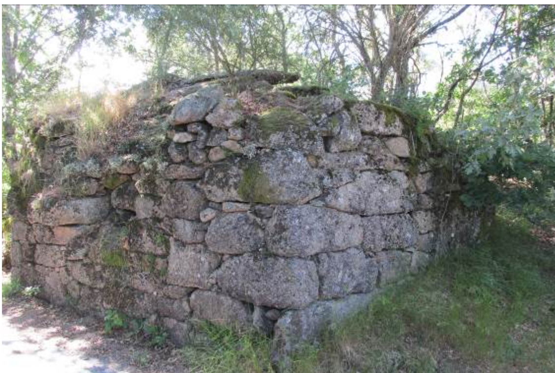
Fig. 10 – Exemplo de um forno sem cabeceira, da tipologia a). Forno do Lugar de Bago de Cima (inverneira). Vista Sudeste. 2014.
