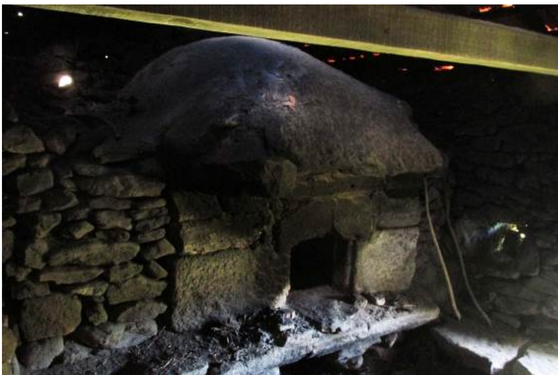
Fig. 7 – Estrutura de uma cúpula, vista do exterior. Fornalha do forno nº1 do Lugar de Portos (branda). 2014.
