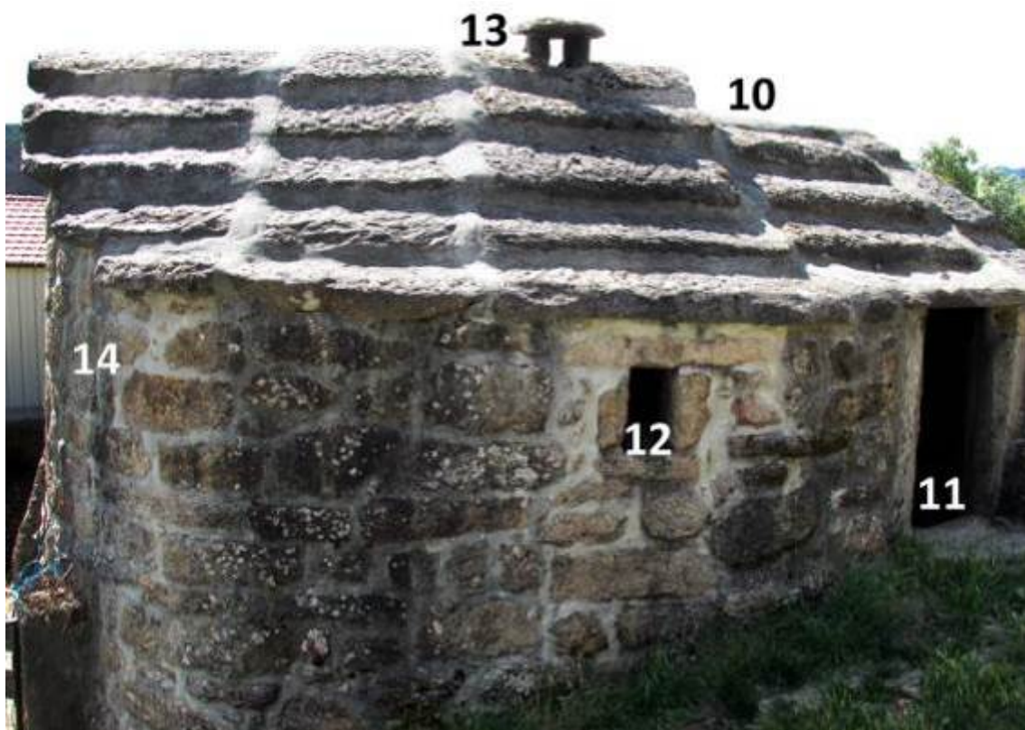
Fig. 8 - Forno do Lugar da Ameijoeira (inverneira). Vista Este. Imagem ilustrativa das diferentes partes que compõem um forno no exterior. 2014.
