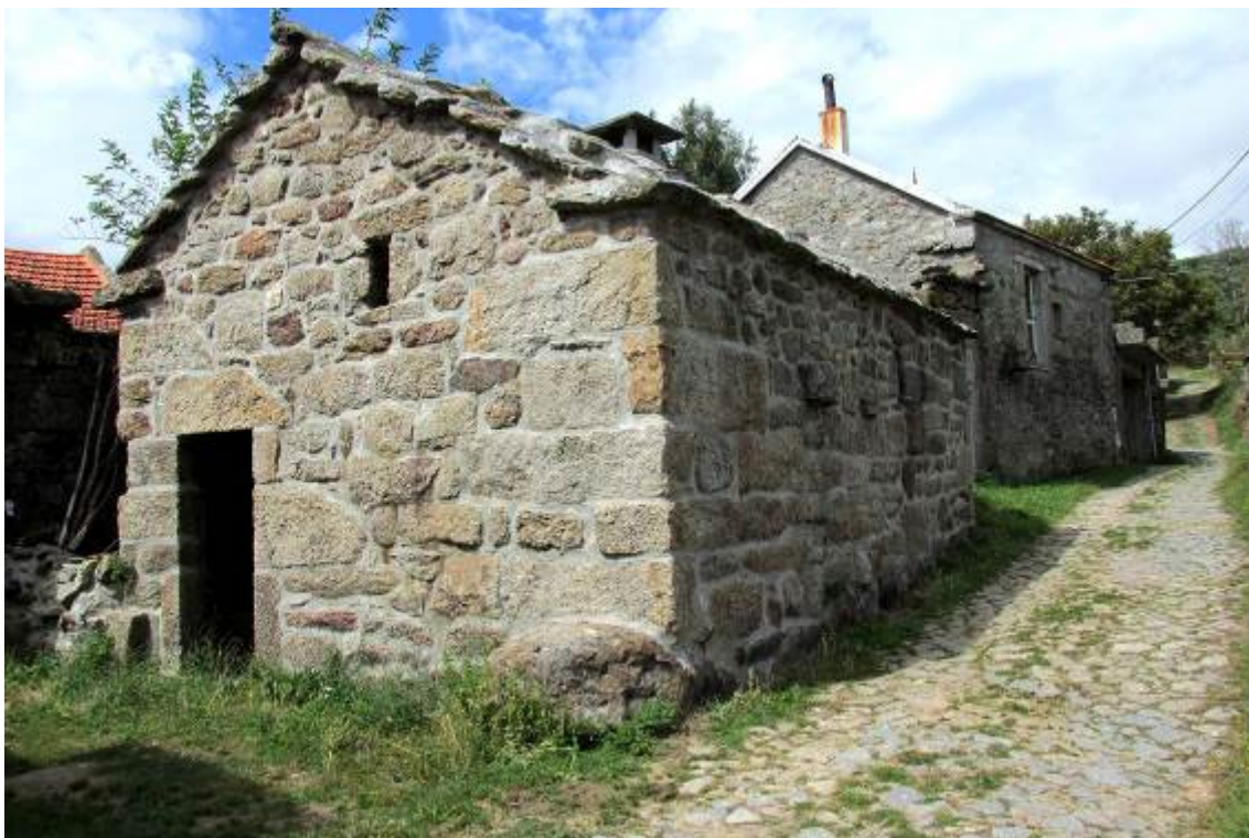
Fig. 44 – Forno do Lugar de Várzea Travessa (lugar fixo). Vista Sudoeste. 2014
