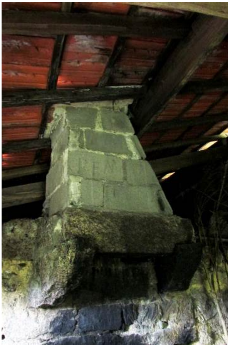
Fig. 37 – Pormenor do canal de escoamento de fumo – “campana” com chaminé em tijolo de cimento. Forno do Lugar da Podre (inverneira). 2014
