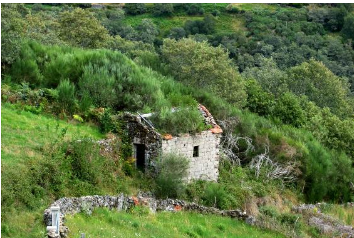
Fig. 58 – Forno do Lugar de Portela (branda). Vista Oste. Cobertura e estrutura consumida pela vegetação. 2014
