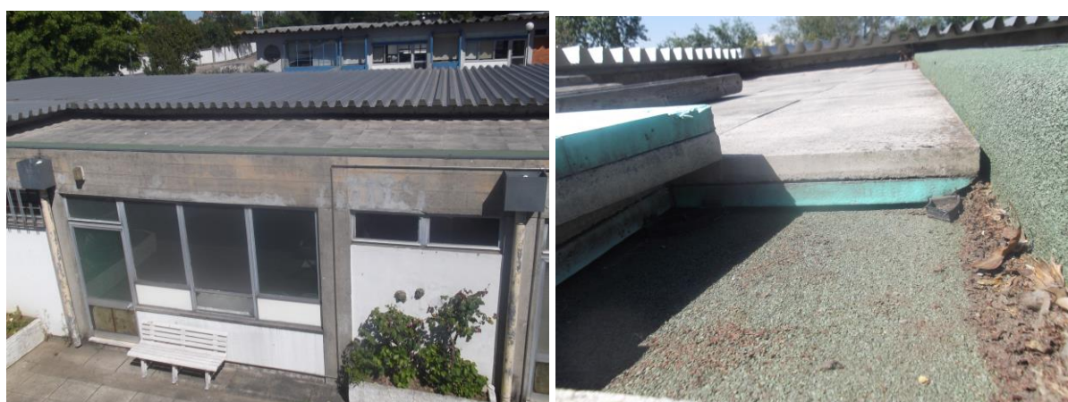
Fig.92 – Vista geral da cobertura intervencionada da sala de aula e respetivo corredor (à esquerda), e pormenor da impermeabilização, isolamento térmico e respetiva proteção da cobertura invertida (à direita)
