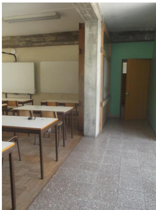
Fig.29 – Fotografia do revestimento de piso do corredor de acesso à sala de aula (mosaico hidráulico) e da sala de aula propriamente dita (madeira)
