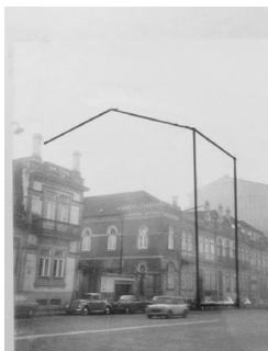
3.1.E Habitação demolidas para dar lugar ao edifício 931
