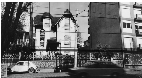
3.A. Casa demolida no local do actual edifício número 60
