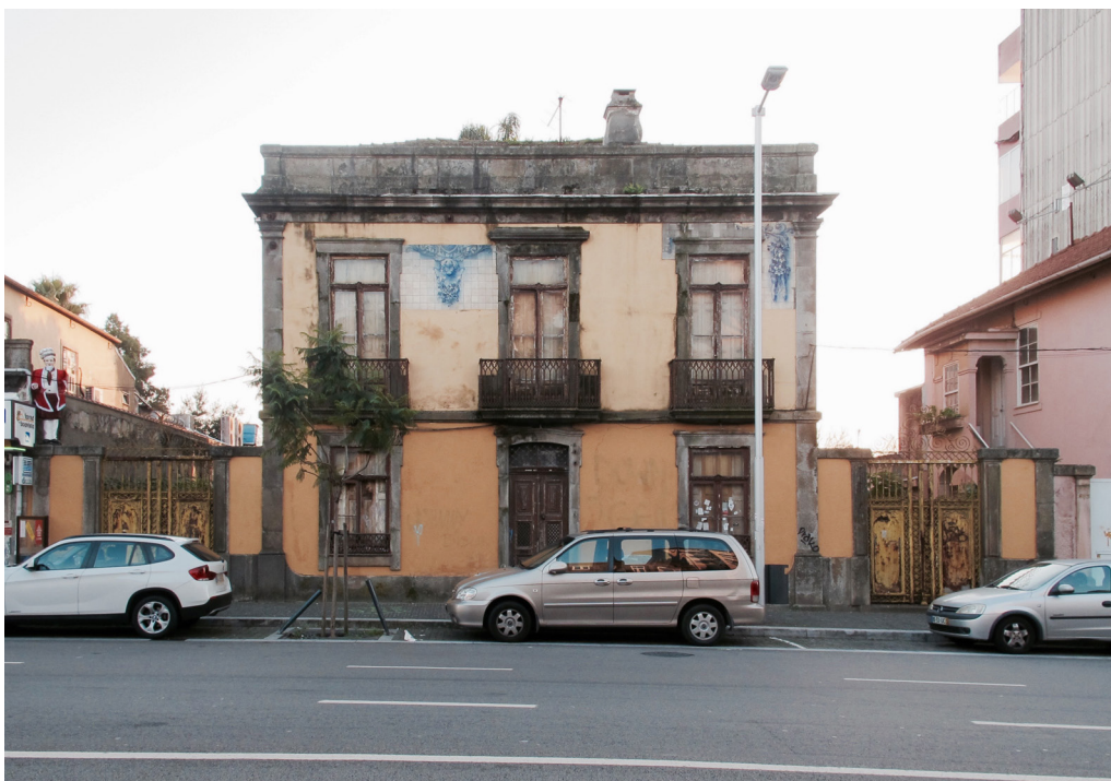
168. Edifício número 881, considerado imóvel de interesse patrimonial cada vez mais degradado. Dezembro 2016
