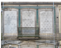
143. Encerramento de vão
