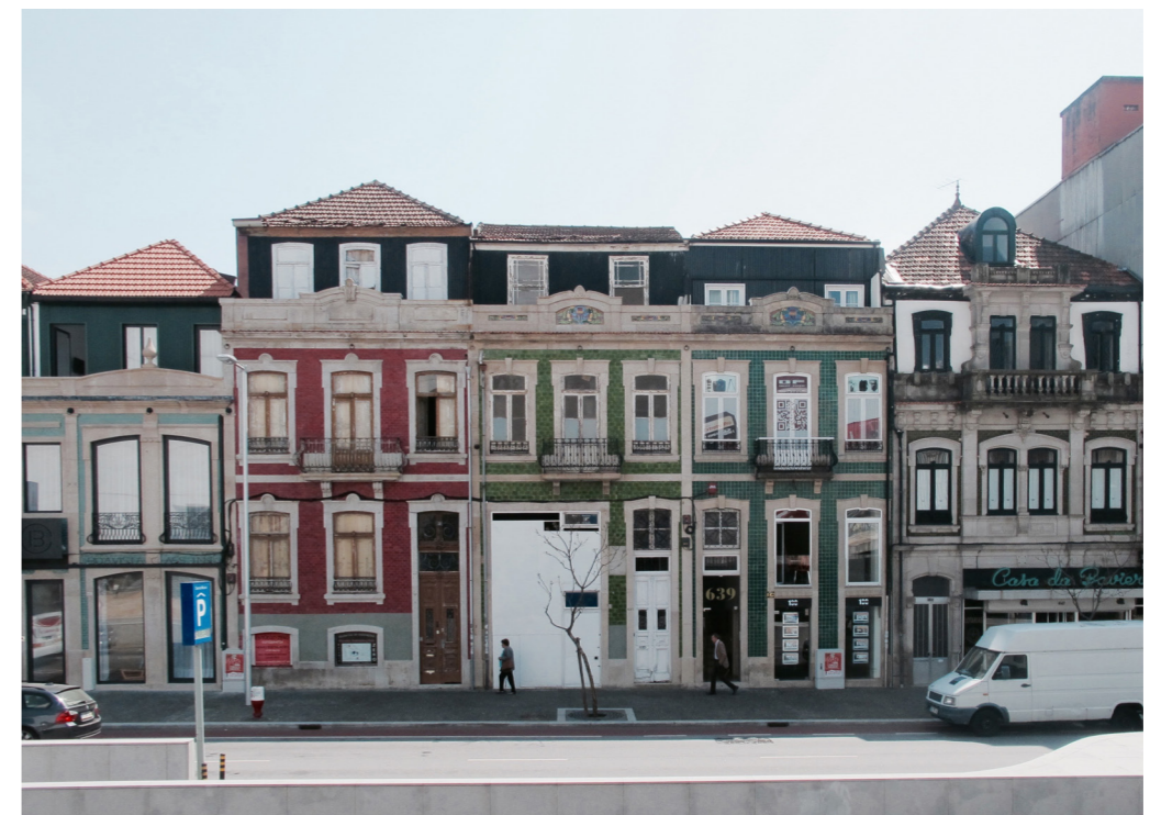
078. Edifícios burgueses do período liberal na Avenida da Boavista, Março 2017
