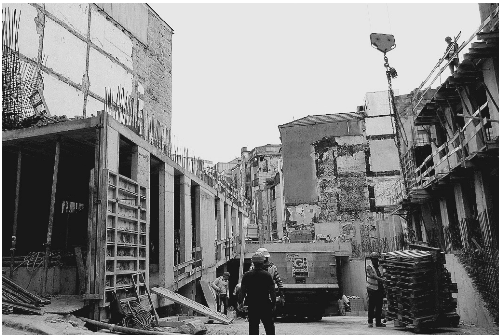
191. Demolição e reconstrução. Descaracterização das casas burguesas- quarteirão das Cardosas
