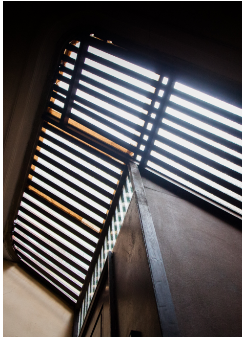
195 e 196. Divisória nas escadas do edifício nº156 da Avenida dos Aliados. Estrutura realizada interfere com a luminosidade que a clarabóia providencia
