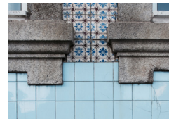
140. Colmatação de falhas de revestimento com azulejos diferentes
