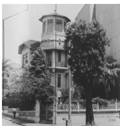
3.B. Casa demolida no local do actual edifício número 82
