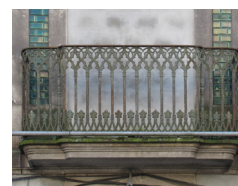
149. Oxidação/corrosão metálica
