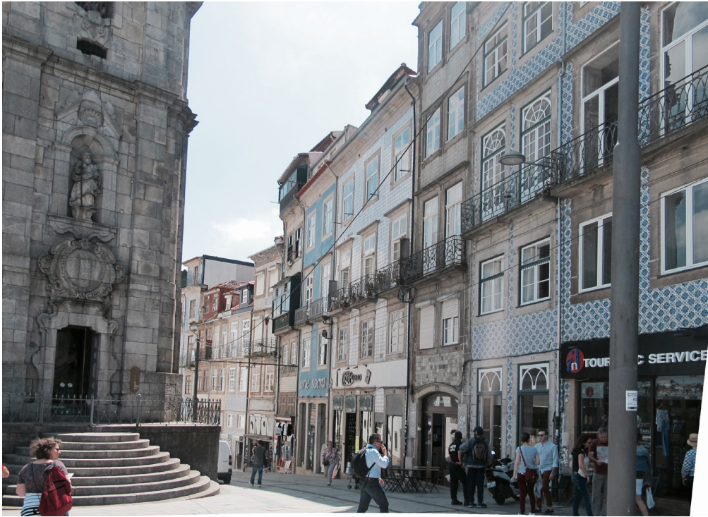
072. Casa no Porto Iluminista— Rua da Assunção
