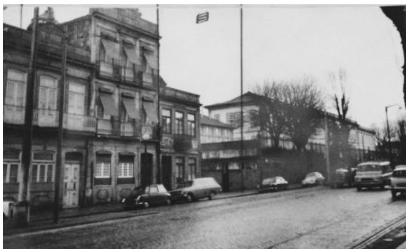
3.C. Casa demolida no local do actual edifício 280
