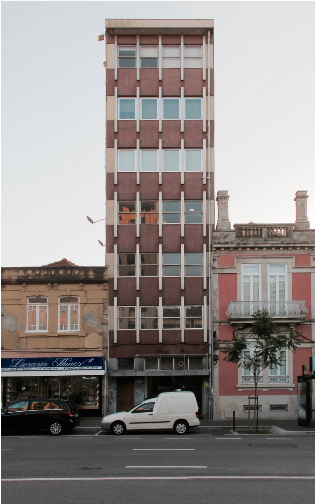
169. Edificado pre-existente e nova construção, Dezembro 2016
