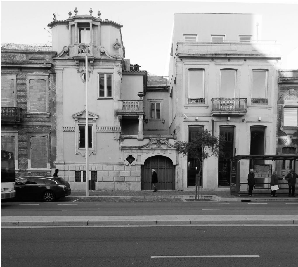
097. Fachada do edifício número 942, Março 2017
