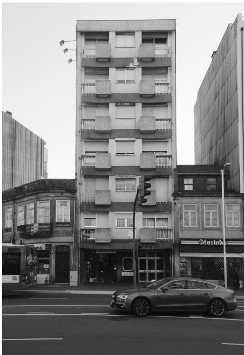
121. Fachada do edifício número 817, Março 2017
