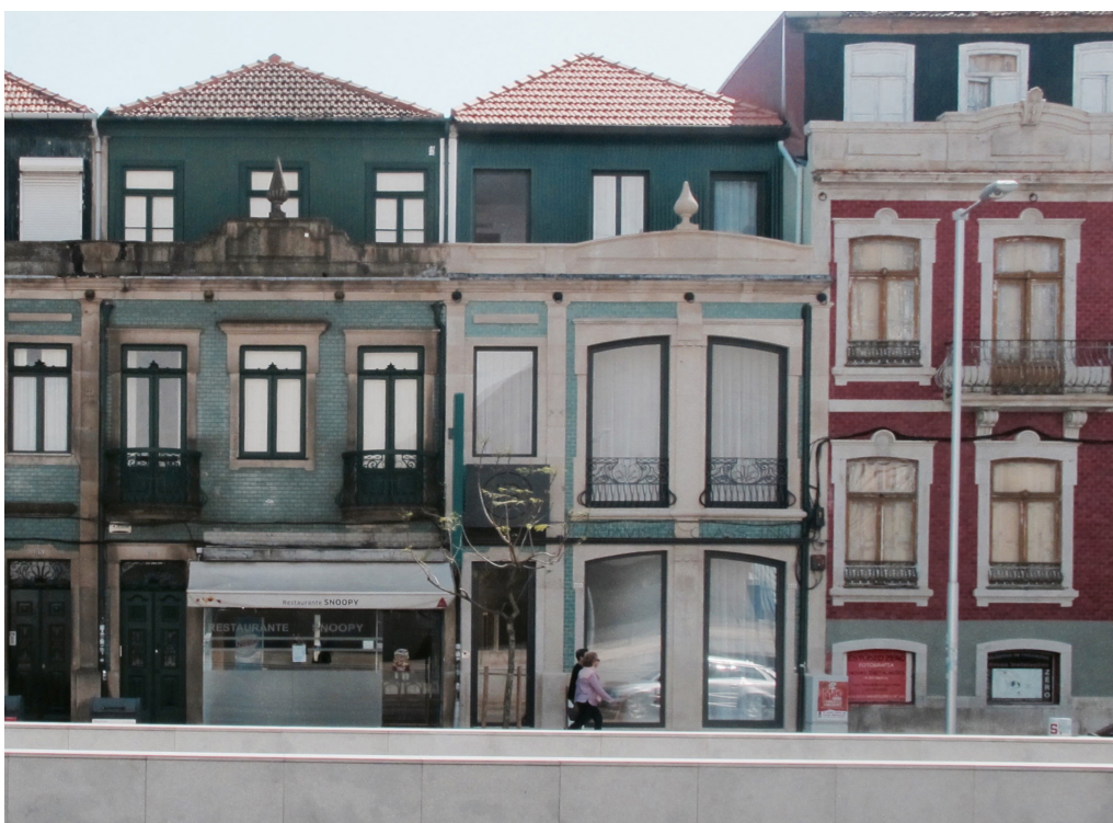
166. Edifício número 621 após reabilitação, Março 2017
