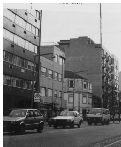
3.M. Casa demolida no local do actual edifício 1002.
