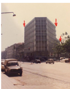
3.T. Edifício número 759 antes de ser recuperado
