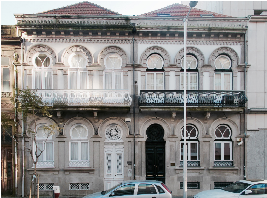
164. Edifícios número 1081 e 1083 após reabilitação, Março 2017
