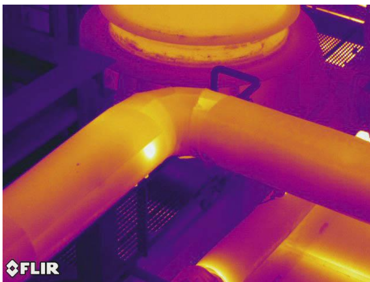
Figura 2.9 – Imagem termográfica de uma conduta industrial [10].
