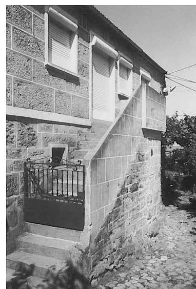
Fig.5. A escada exterior e a varanda são elementos arquitectónicos que representam reminiscências do passado rural e da casa tradicional [Parada do Monte].
