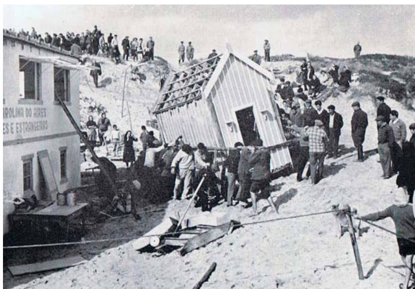
Fig.25. Processo de movimentação das casas.
