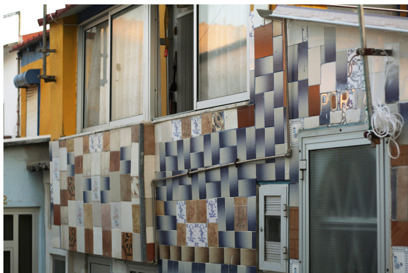
Fig.66. Os azulejos reutilizados na fachada da casa do Sr Caldeira.
