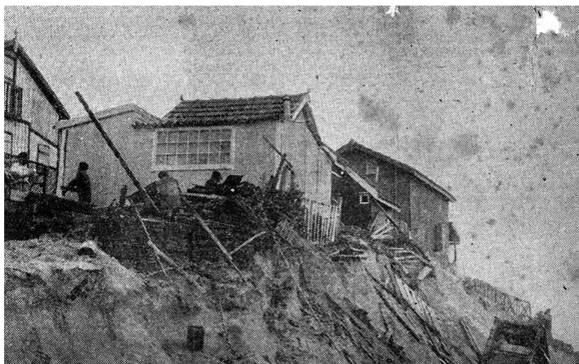
Fig.24. Recorte de jornal onde se observa a destruição das casas, provocada pelo mar.
