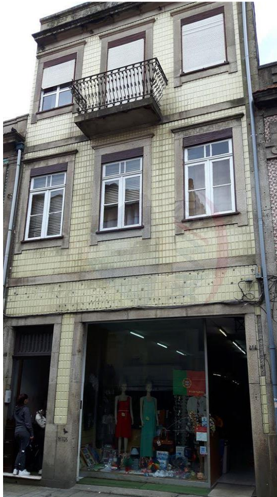
FIG. 20 - FOTOGRAFIA DO ALÇADO PRINCIPAL DO EDIFÍCIO 1 [58]
