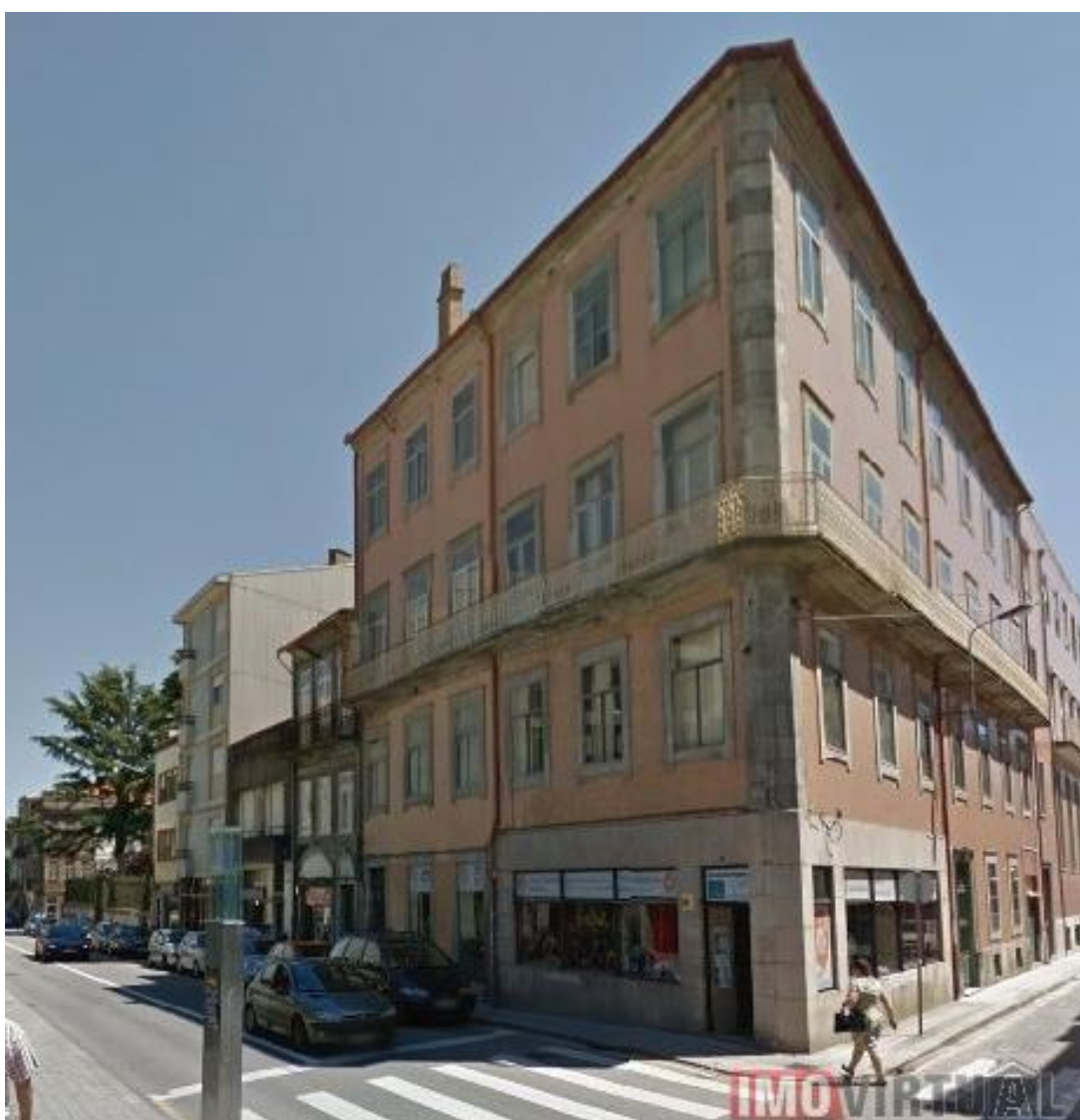
FIG. 28 - FOTOGRAFIA DOS ALÇADOS DO EDIFÍCIO 9 [58]
