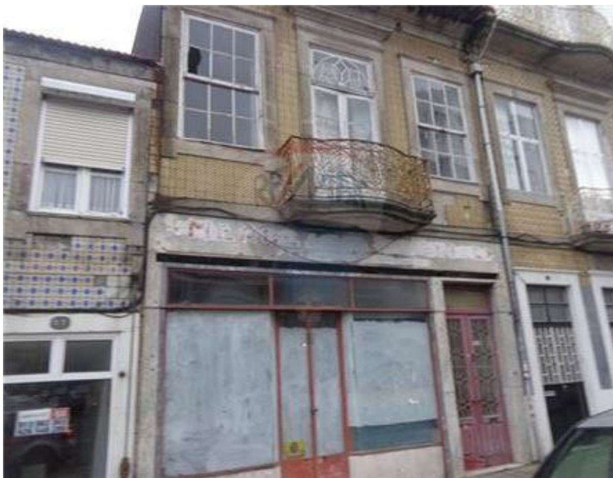
FIG. 22 - FOTOGRAFIA DO ALÇADO PRINCIPAL DO EDIFÍCIO 3 [58]
