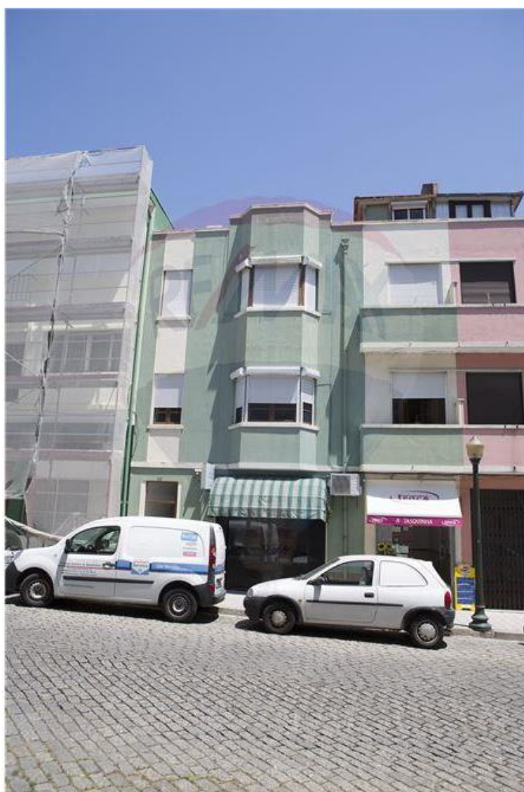
FIG. 21 - FOTOGRAFIA DO ALÇADO PRINCIPAL DO EDIFÍCIO 2 [58]
