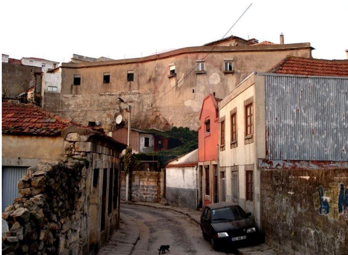
FIG. 23 - FOTOGRAFIA DE UM DOS ALÇADOS DO EDIFÍCIO 4 [58]
