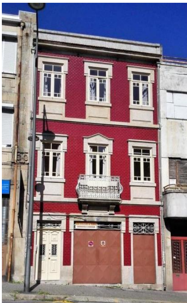
FIG. 26 - FOTOGRAFIA DO ALÇADO PRINCIPAL DO EDIFÍCIO 7 [58]
