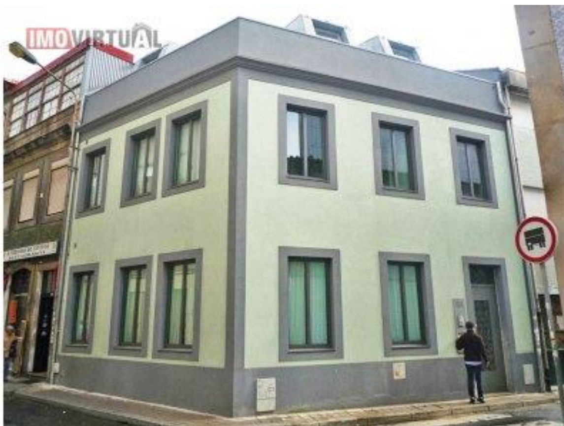
FIG. 27 - FOTOGRAFIA DOS ALÇADOS DO EDIFÍCIO 8 [58]
