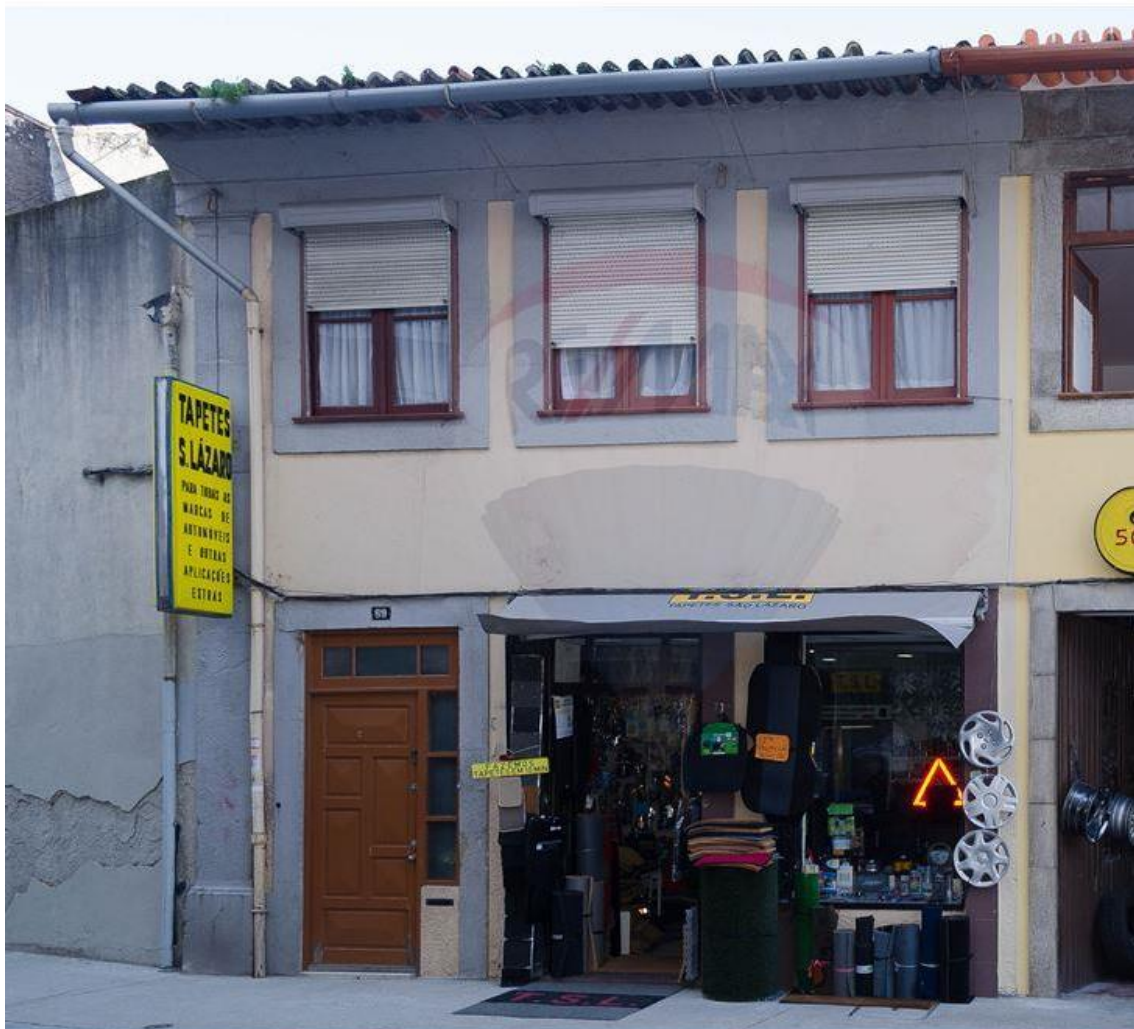
FIG. 24 - FOTOGRAFIA DO ALÇADO PRINCIPAL DO EDIFÍCIO 5 [58]
