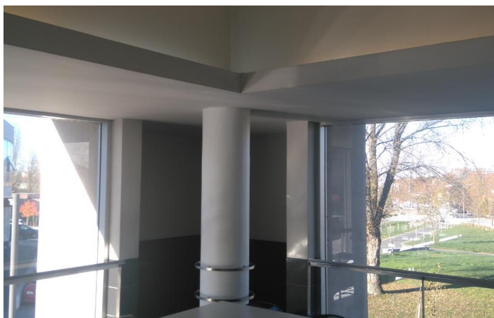
Fig. 5.14 – Detalhe do canto Oeste da cantina (refeitório)
