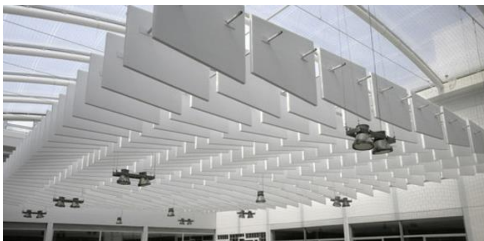
Fig. 2.34 – Exemplo de difusores suspensos aplicados num pavilhão [37]
