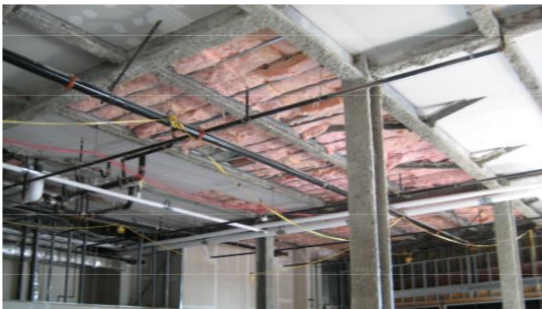
Fig. 4.3 – Instalação do isolamento no teto do restaurante, Boston [79]
