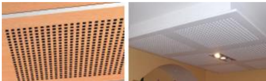
Fig. 2.29 e 2.30 – Exemplos de ressoadores agrupados em tetos falsos [2]
