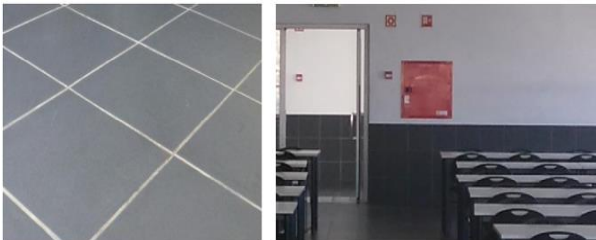
Fig. 5.12 e 5.13 – Revestimento do pavimento e das paredes (refeitório)
