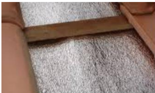
Fig. 2.41 – Exemplo de aplicação de manta acústica alumínica em telhado [39]
