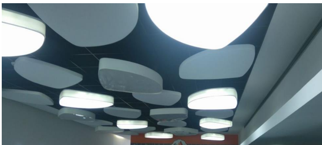
Fig. 5.20 – Painéis acústicos suspensos no teto do grill
