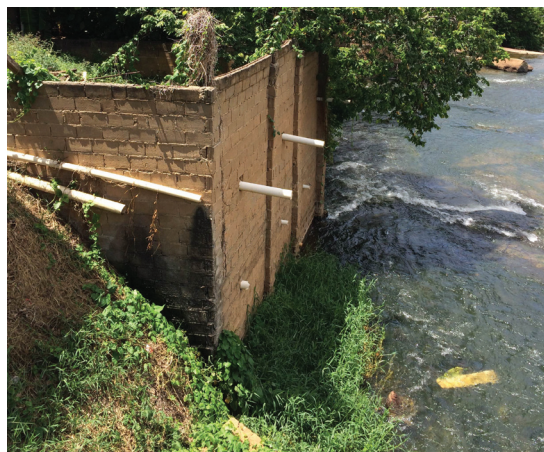
Fot. 5 - Lançamento de efluentes domésticos in natura no rio Muriaé (área urbana de Cardoso Moreira) (Fotografia de Raul Reis Amorim, abril de 2015).
