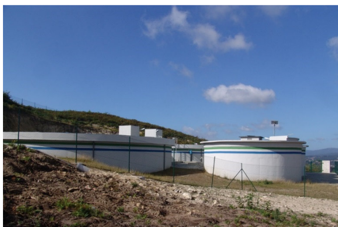
Panorama lateral das células do Reservatório R1 de Ganfei.
