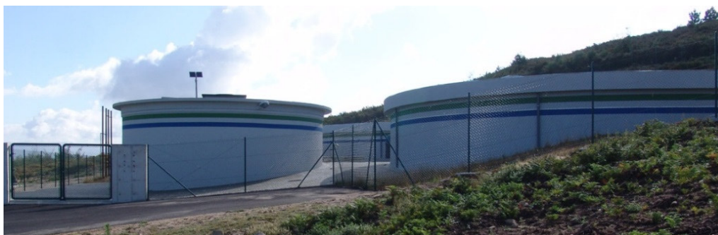
Figura 8.20 – Panorâmica lateral do Reservatório R1 de Ganfei (Fonte: AdNORTE).
