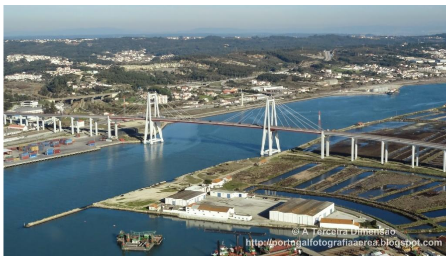
Fig. 2.17 – Imagem da ponte Edgar Cardoso (retirado de https://portugalfotografiaaerea.blogspot.com )
