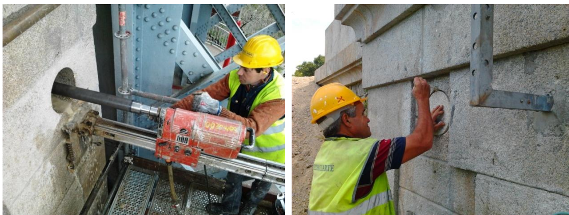
Fig. 4.68 – Furação por carotagem para a instalação das barras de pré-esforço / tamponamento do nicho
