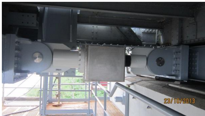
Fig. 4.67 – Aspeto do lock-up device já colocado
