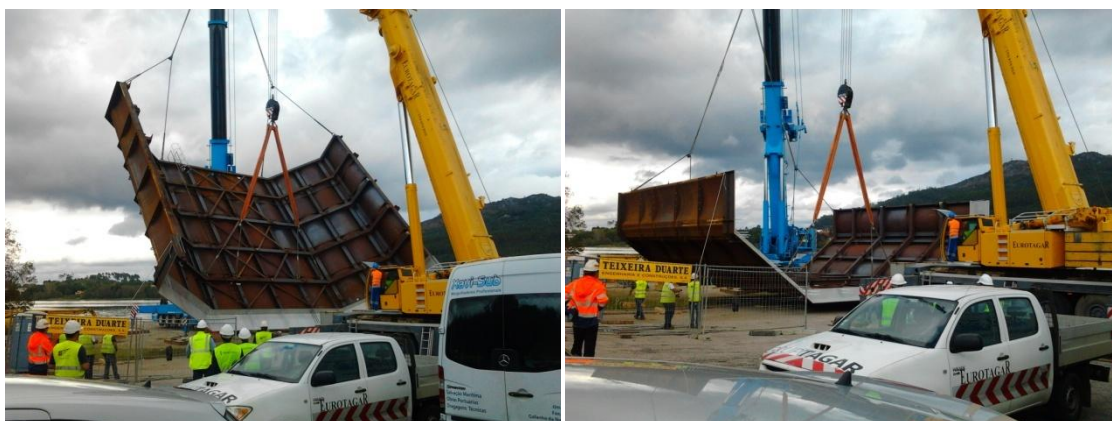
Fig. 4.31 – Operação de rotação da ensecadeira – 5ª fase / 6ª fase
