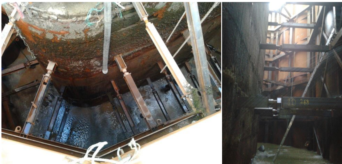
Fig. 4.40 – Vista da ensecadeira após a remoção da água do seu interior
