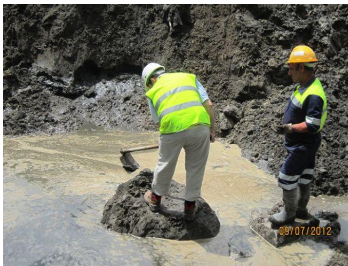
Fig. 4.17 – Inspeção a uma coluna de ensaio realizada
