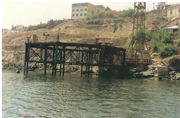
Fig. 2.32 – Imagem da plataforma metálica para construção da ensecadeira (retirado do livro Edgar Cardoso – Engenheiro Civil , p. 346)
