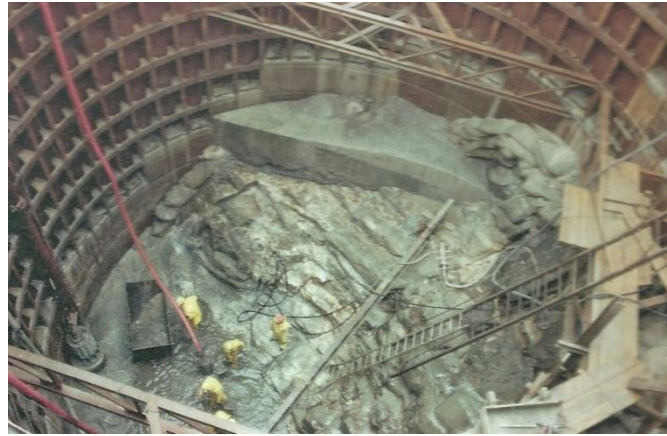
Fig. 2.34 – Imagem do interior da ensecadeira, após a remoção de água (retirado do livro Edgar Cardoso – Engenheiro Civil , p. 349)
