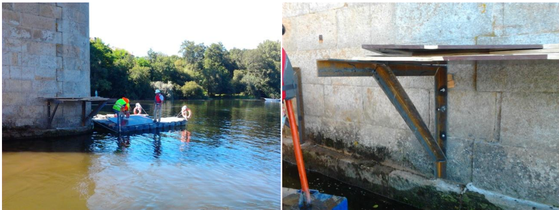
Fig. 4.18 – Montagem da cércea em redor de uma dos pilares - pormenor da poleia metálica da cércea
