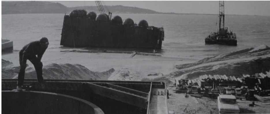
Fig. 2.28 – Imagem do lançamento ao rio do primeiro troço do caixão da torre Sul (retirado do livro Ponte Salazar , p. 73)
