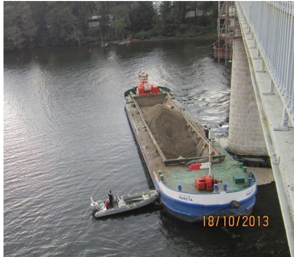
Fig. 4.46 – Realização de aterro com a areia anteriormente dragada em redor de um pilar
