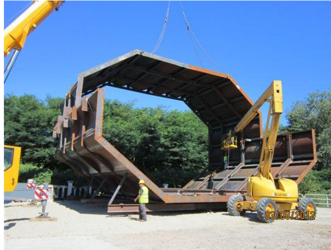
Fig. 3.7 – Operações de pré-montagem da ensecadeira
