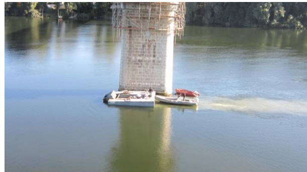
Fig. 4.47 – Transporte de enrocamento até ao pilar / descarga do enrocamento em redor do pilar
