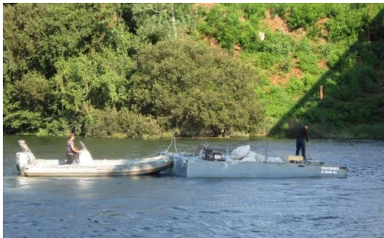
Fig. 4.47 – Transporte de enrocamento até ao pilar / descarga do enrocamento em redor do pilar
