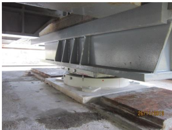
Fig. 4.71 – Aspeto dos novos aparelhos de apoio dos pilares
