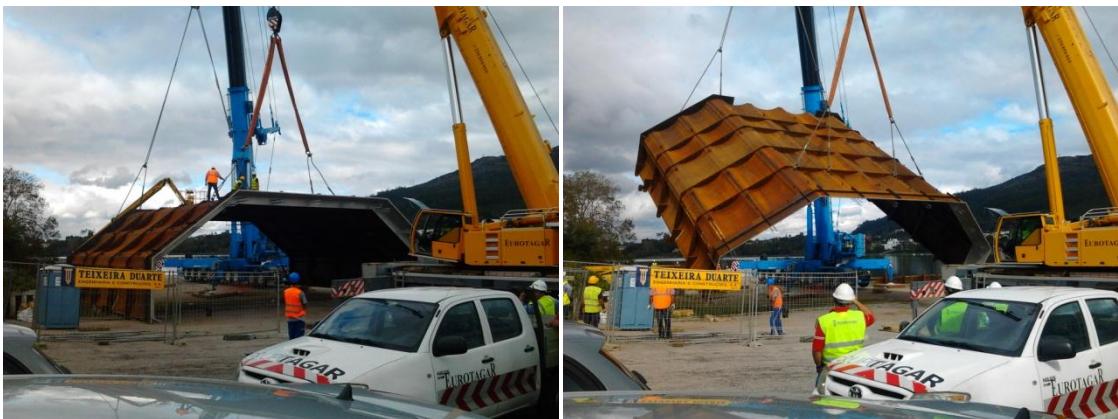
Fig. 4.29 – Operação de rotação da ensecadeira – 1ª fase / 2ª fase
