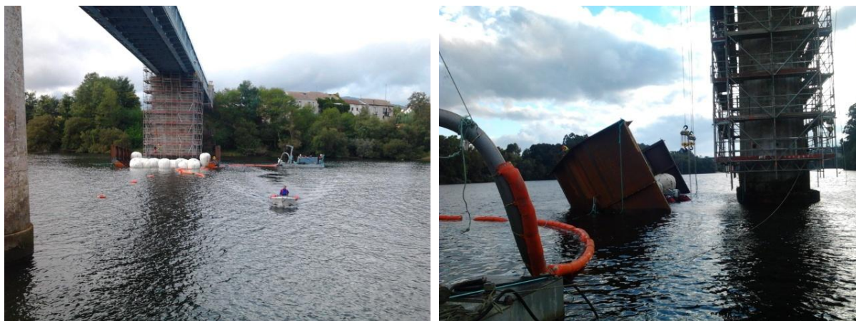
Fig. 4.36 – Movimentação da primeira metade da ensecadeira até ao pilar / operação de rotação da primeira metade da ensecadeira
