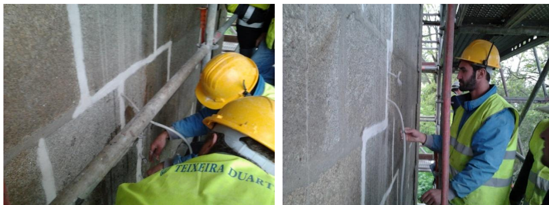
Fig. 4.59 – Trabalhos de refechamento de juntas e injeção com calda
