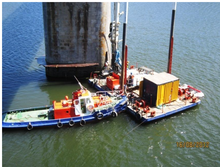
Fig. 4.20 – Posicionamento do conjunto plataforma flutuante / sonda hidráulica
