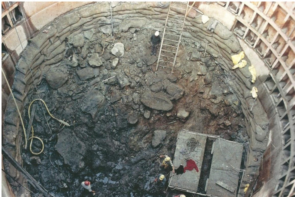
Fig. 2.35 – Imagem do interior da ensecadeira, durante as operações de saneamento do granito decomposto (retirado do livro Edgar Cardoso – Engenheiro Civil , p. 354)
