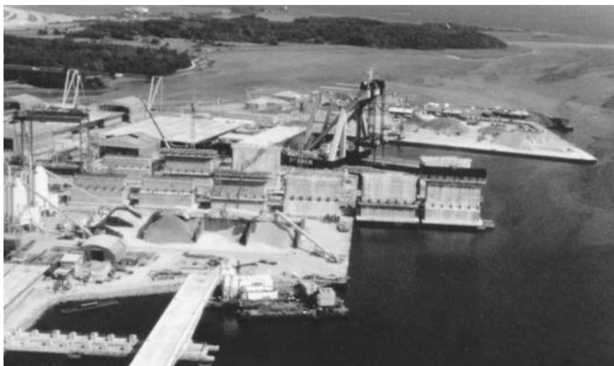
Fig. 2.4 – Imagem do estaleiro de prefabricação de caixões fechados (retirado de Bridge Engineering Handbook – Construction and Maintenance – p. 163)
