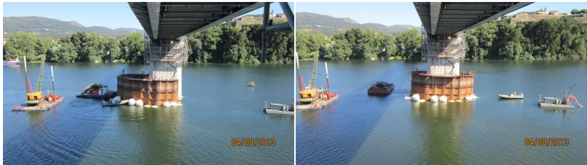
Fig. 4.43 – Atravessamento do pilar / fecho da ensecadeira e preparação para a sua descida e posicionamento na cota pretendida
