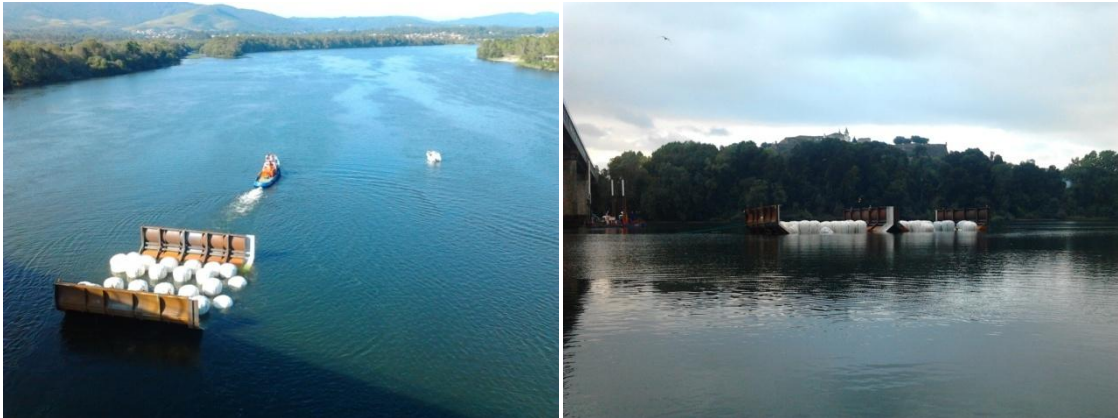
Fig. 4.32 – Transporte fluvial de metade da ensecadeira / as duas metades da ensecadeira ancoradas junto à ponte
