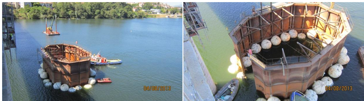
Fig. 4.42 – Movimentação da ensecadeira entre pilares / abertura da ensecadeira para instalação no novo pilar
