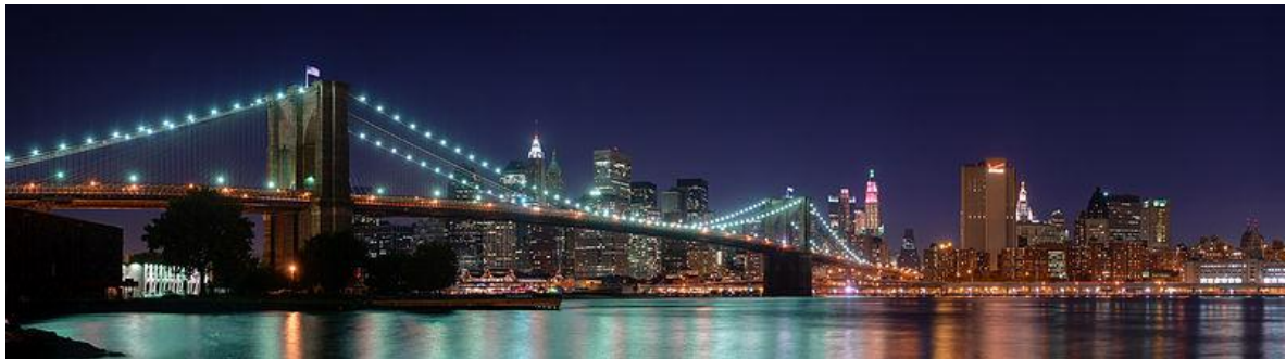
Fig. 2.10 – Imagem da ponte de Brooklyn (retirado de https://pt.wikipedia.org/wiki/Ponte_do_Brooklyn )
