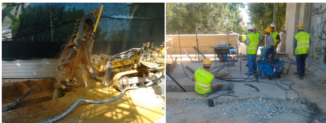
Fig. 4.63 – Execução de furação para colocação das ancoragens / realização de ensaios de receção de ancoragens
