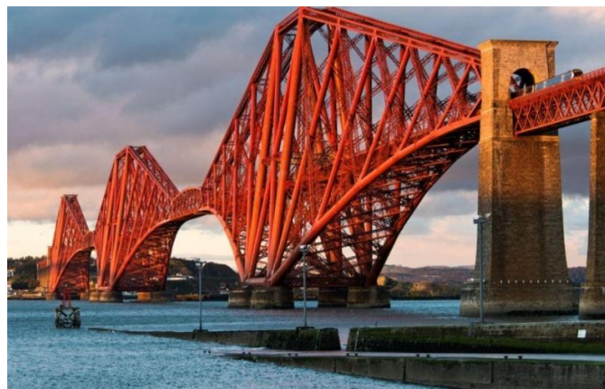
Fig. 2.11 – Imagem da ponte Ferroviária do Forth (retirado de http://archineeringtalk.com/?p=404 )
