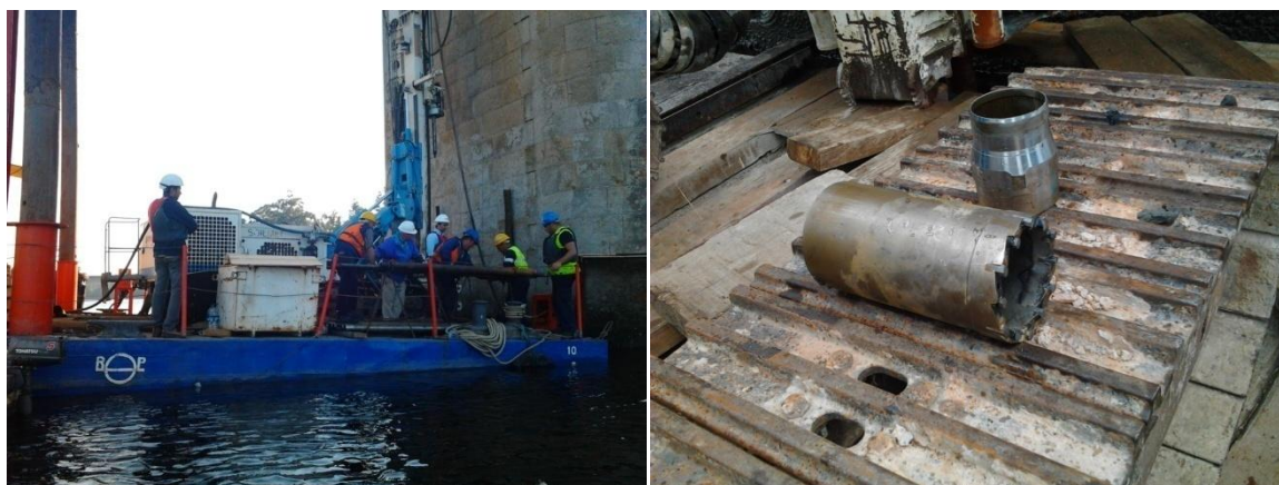
Fig. 4.22 – Recolha de amostras/coróa utilizada para a realização das carotagens
