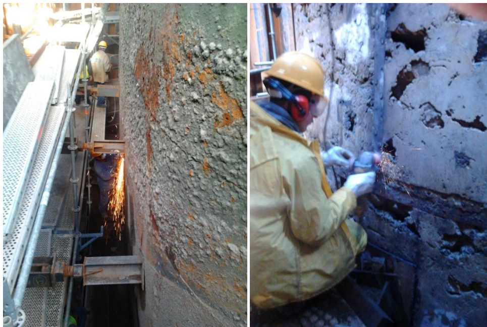
Fig. 4.48 – Corte da chapa metálica do caixão pneumático / escovagem ao grau St3 do esqueleto metálico do caixão
