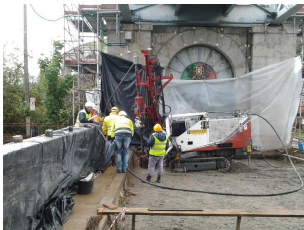
Fig. 4.62 – Realização de colunas de jet-grouting
