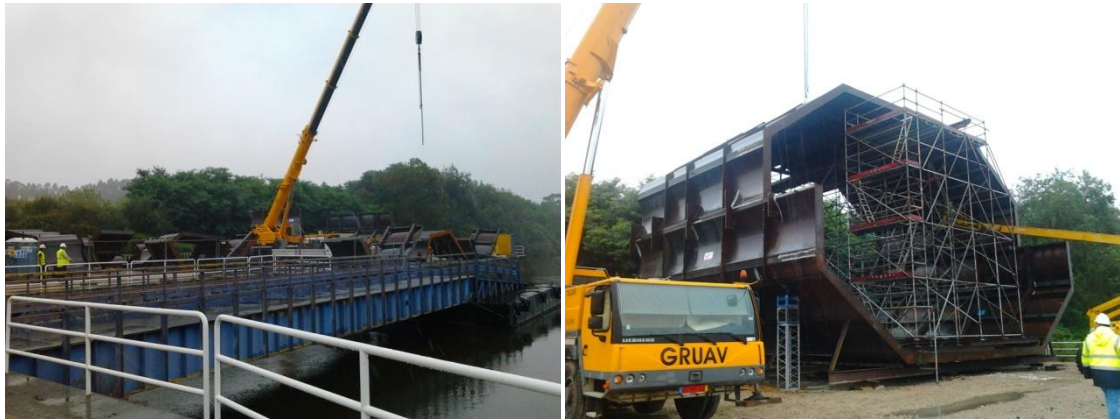
Fig. 4.25 – Trabalhos de pré-montagem da ensecadeira metálica no cais de Goian
