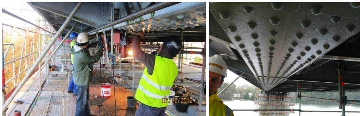
Fig. 4.64 – Descravação de rebites / aspeto final da corda após reforço
