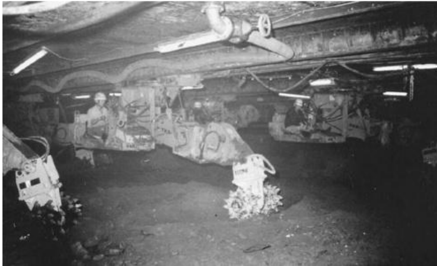
Fig. 2.7 – Imagem da escavação no interior de uma câmara de pressão com recurso a robots, neste caso a escavação da ponte Arco-Íris, em Tóquio (retirado de Bridge Engineering Handbook – Construction and Maintenance – p. 161)
