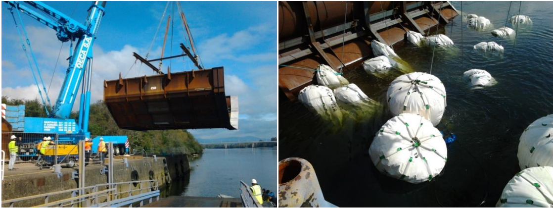
Fig. 4.28 – Colocação na água de metade da ensecadeira / enchimento dos balões de flutuação
