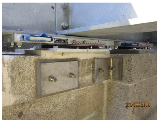
Fig. 4.70 – Aspeto final dos aparelhos de apoio dos tramos de margem
