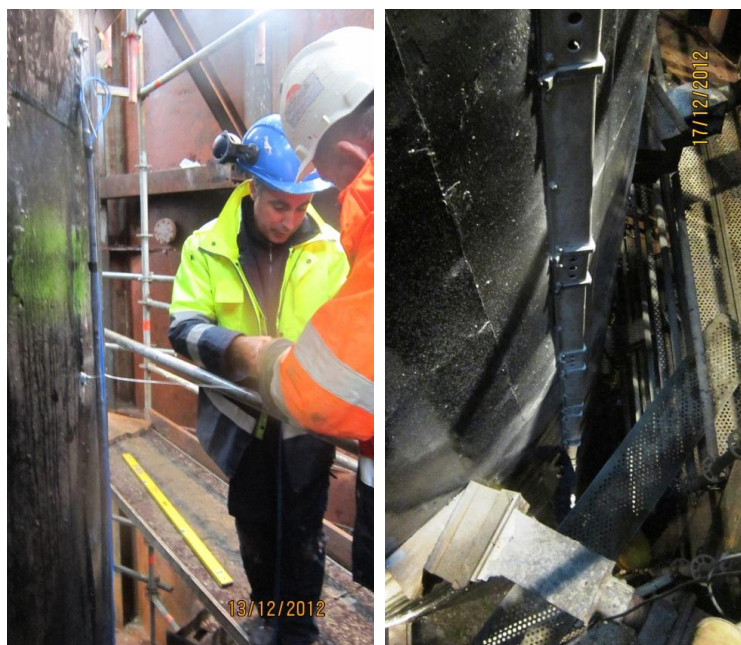
Fig. 4.55 – Montagem do array de fibra ótica no embasamento do pilar / calha de proteção da fibra ótica
