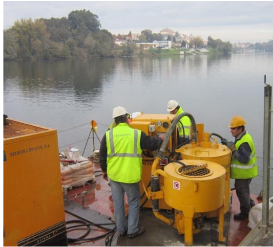
Fig. 4.57 – Realização de injeção de preenchimento e consolidação no pilar P2
