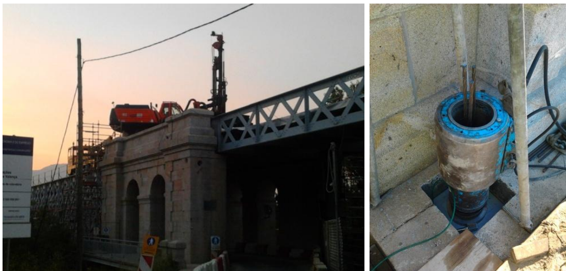
Fig. 4.69 – Execução da furação à roto-percussão a partir da plataforma ferroviária / tensionamento de ancoragem
