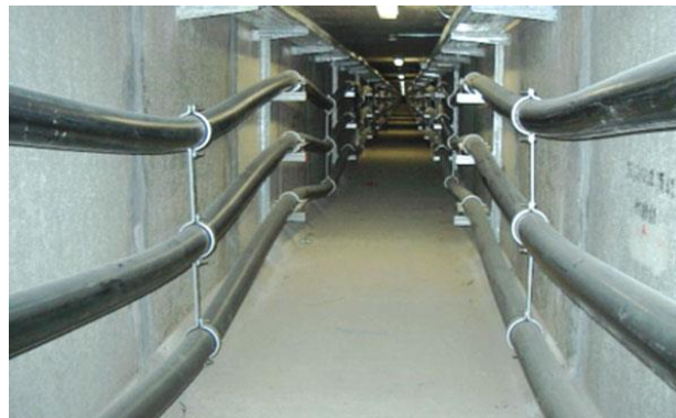
Figura 5 - Foto de túnel utilizado no projeto REE Barajas.
