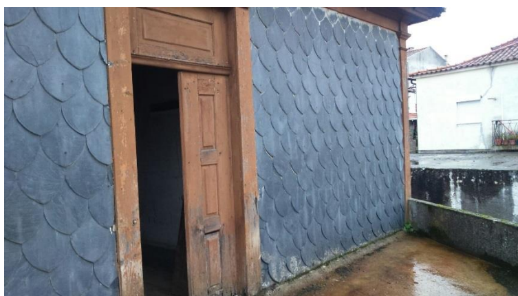
Fig. 4.16 – Vista de fachada evidenciando soletos de ardósia
