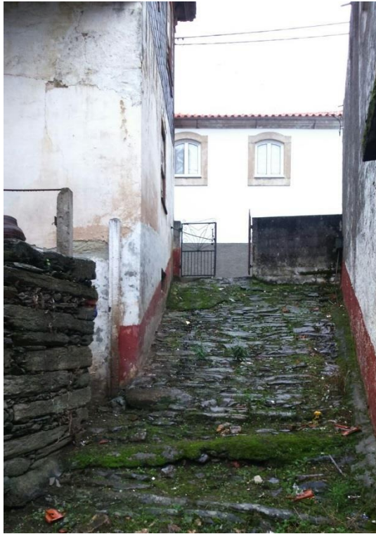
Fig. 4.8 – Acesso à habitação
