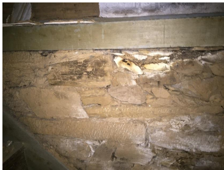
Fig. 4.9 – Paredes de pedra, na estrutura de apoio às escadas
