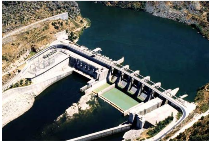
Fig. 2.12 – Barragem da Valeira
