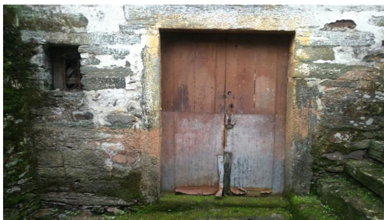
Fig. 4.19 – Ferro na construção- janelas
