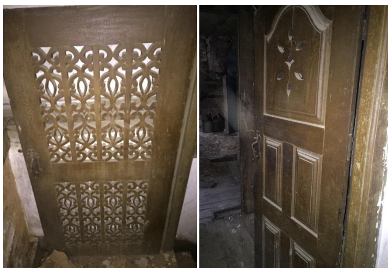
Fig. 4.18 – Exemplos da utilização da madeira no edifício estudado
