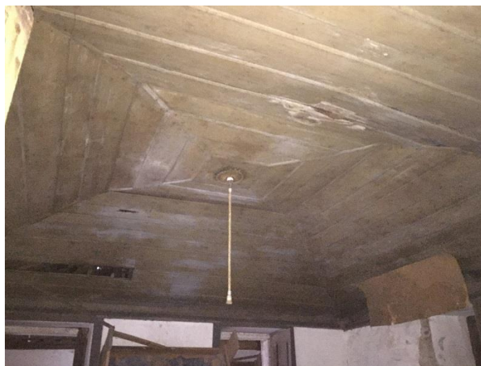
Fig. 4.22 – Forro de madeira
