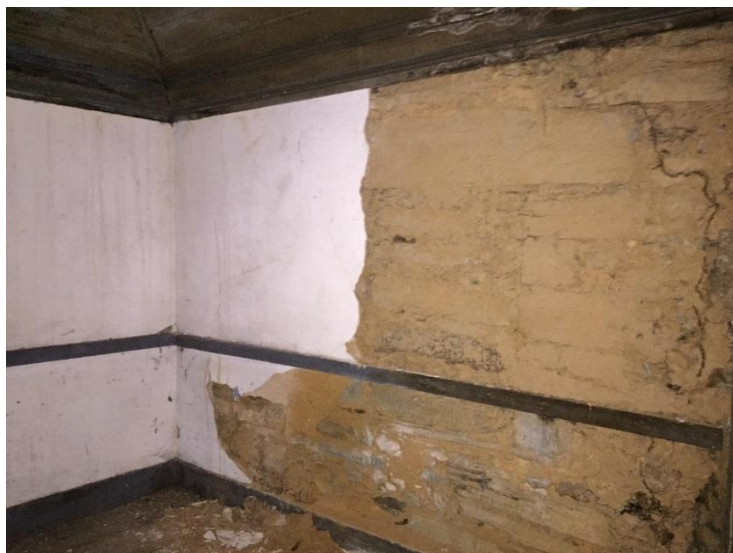
Fig. 4.10 – Parede divisória e resistente de pedra
