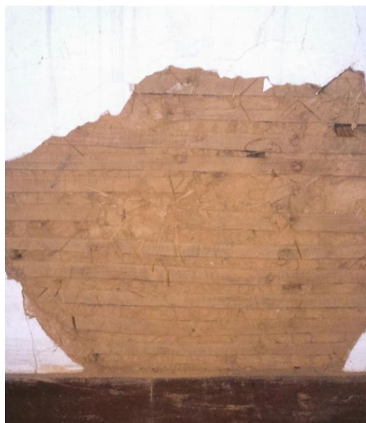
Fig. 4.23 – Parede de tabique
