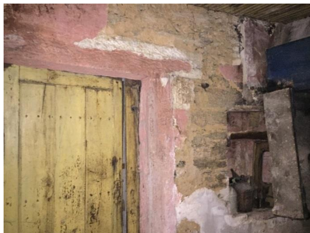
Fig. 4.15 – Utilização da pedra na construção
