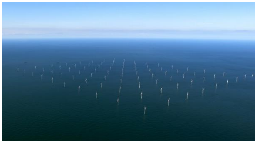
Figura 15-London Array, o maior parque eólico offshore da Europa (Renewable Energy 2013)
