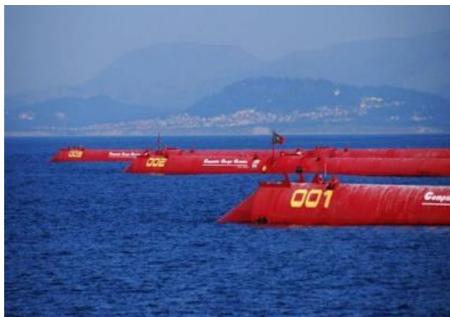
Figura 24- Pelamis em funcionamento no parque de ondas da Aguçadoura (Silva, Barbosa e Paes 2009/2010)
