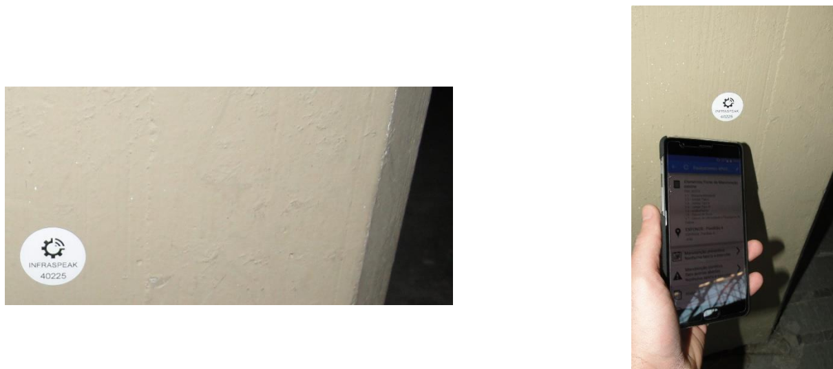
Fig. 36 – Colocação e Leitura de “tag” NFC Destinada ao Pavimento
