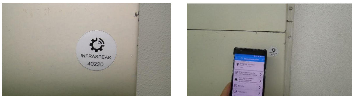
Fig. 41 - Colocação e Leitura de “tag” NFC Destinada aos Equipamentos
