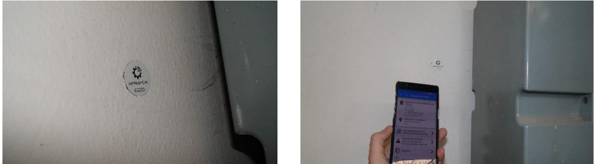
Fig. 38 - Colocação e Leitura de “tag” NFC Destinada às Paredes
