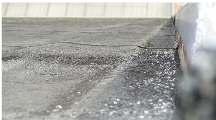
Fig. 11 - Fotografia Exemplificativa da Cobertura
