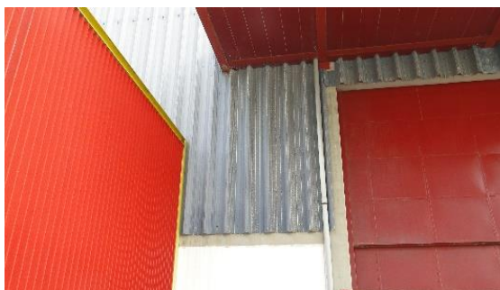
Fig. 12 - Fotografia Exemplificativa das Paredes
