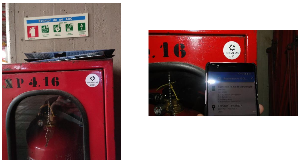
Fig. 40 - Colocação e Leitura de “tag” NFC Destinada à Segurança contra Incêndios
