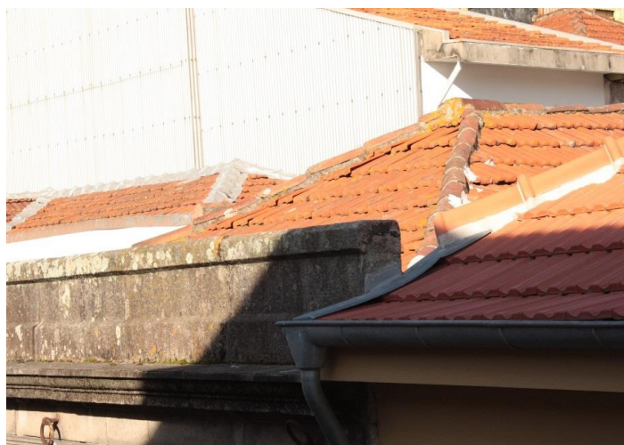
Fig. 4.14 – Vista parcial da cobertura junto do alçado principal
