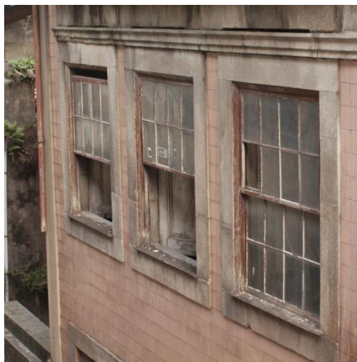
Fig. 4.23 – Janelas do Piso 2
