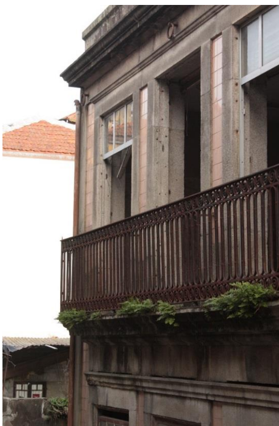
Fig. 4.22 – Fachada Principal com pormenor da Varanda
