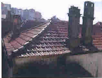
5- Vista da Cobertura
