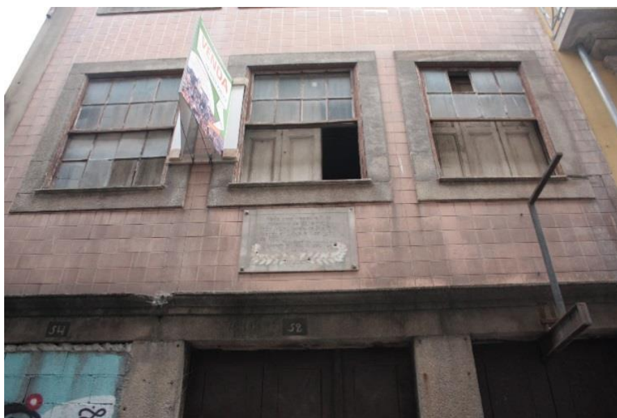
Fig. 4.15 – Fachada Principal em alvenaria de Pedra revestida a Azulejos
