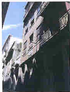
2- Fachada da R. da Ponte Nova
