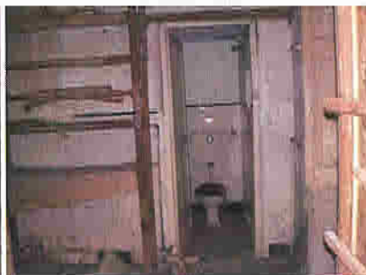
18- Vista do 2º Andar – Inst. Sanitária
