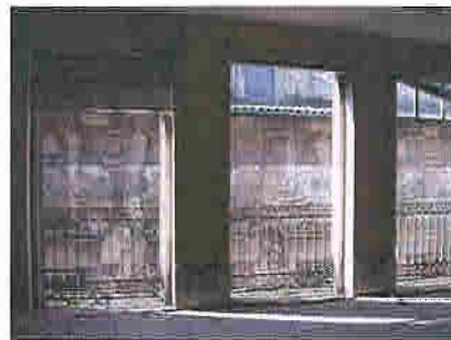
22- Vista do 3º Andar – Não possui caixilharias
