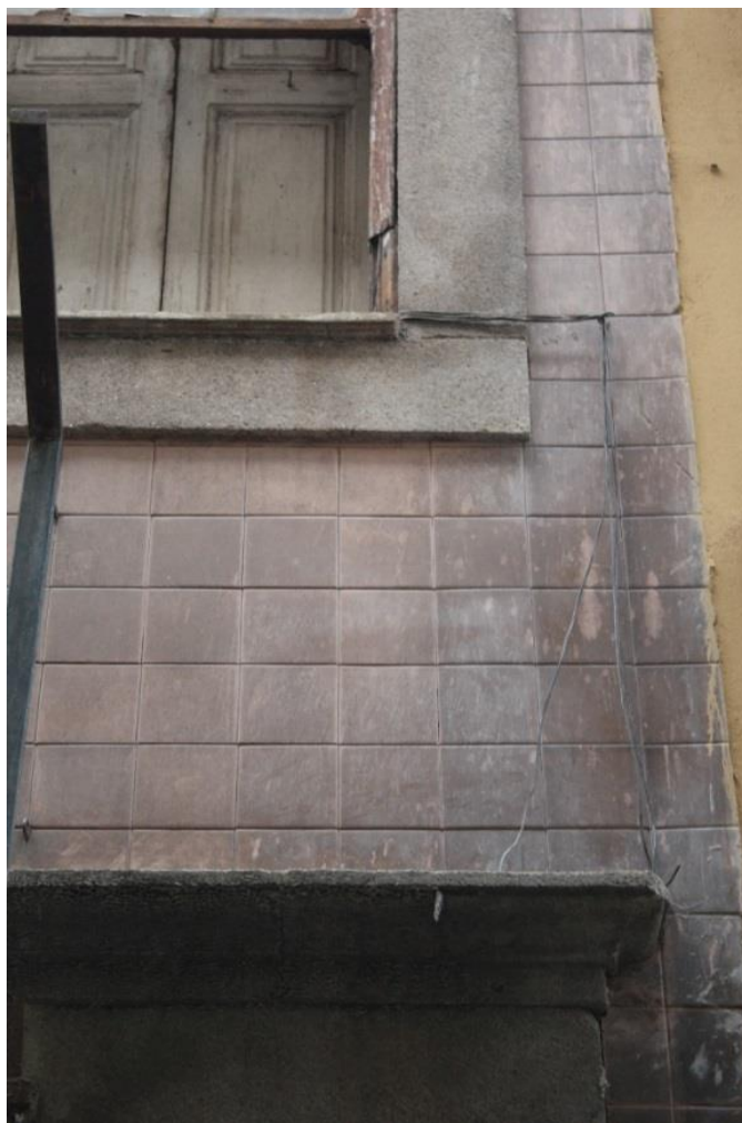
Fig. 4.16 – Pormenor dos Azulejos da fachada Principal
