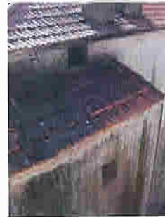
6- Vista da Cobertura
