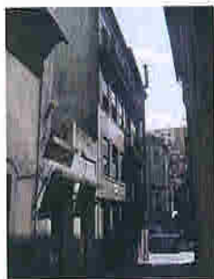
1- Fachada da R. da Ponte Nova
