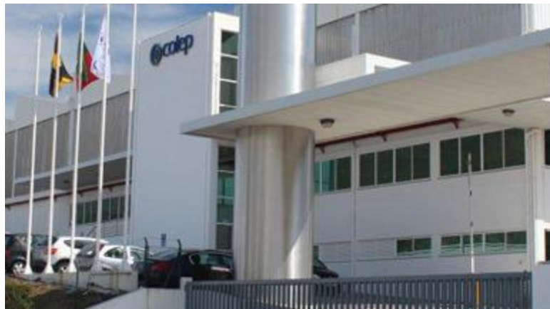
Figura 1 - Instalações da Colep em Vale de Cambra
