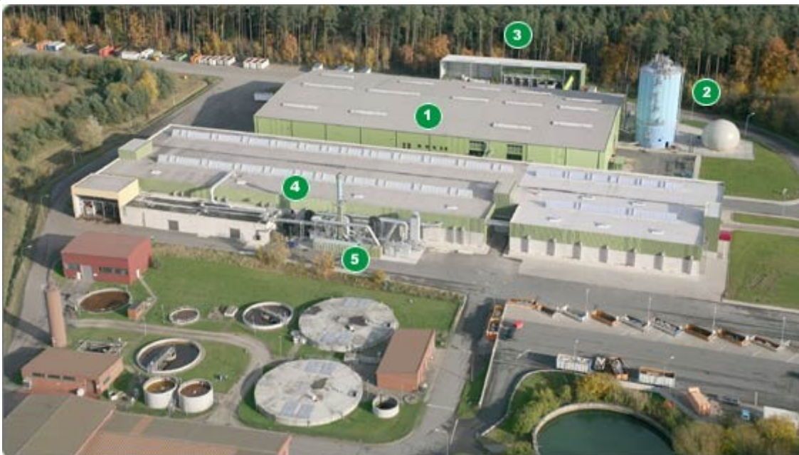
a) Vista aérea da instalação TMB-DA de Pohlsche Heide, Centro de Eliminação de Pohlsche Heide (2009)
