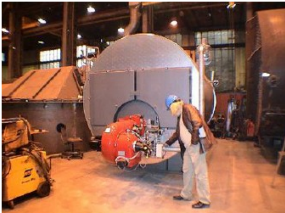
b) Caldeira para produção de vapor. ETAR de Kapusciska, Polónia (Norli, 2006)
