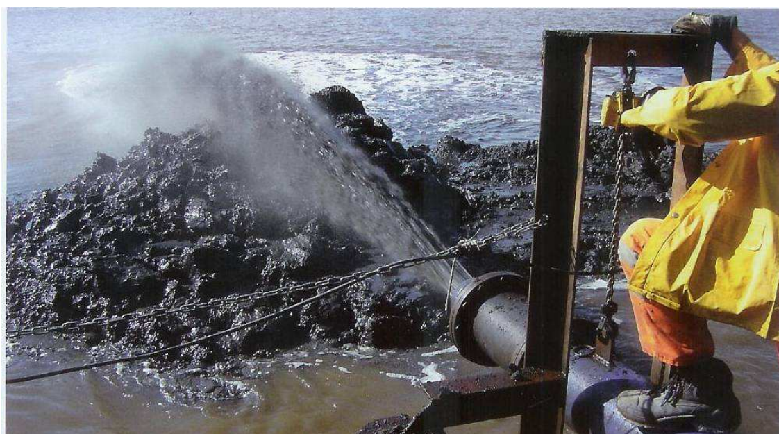
Figura 3.9 – Descarga de sedimento fluidificado através de tubagem (Terra et Aqua - 2006)
