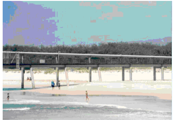
Figura A1.4 – Ponte-Cais de recolha de areia (2002)
