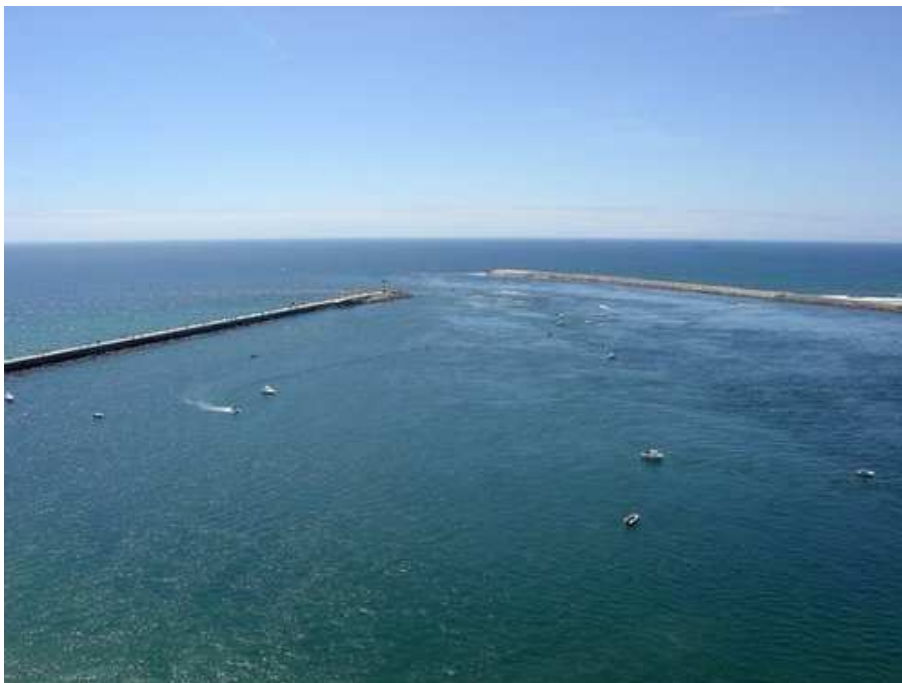
Figura 4.11 – Entrada marítima da barra de Aveiro (google earth)
