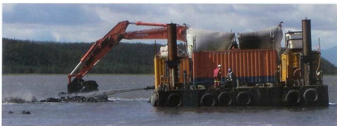
Figura 3.3 – Pá ou balde de maxilas (escavadora) montada numa pequena barçaça (Terra et Aqua - 2006)
